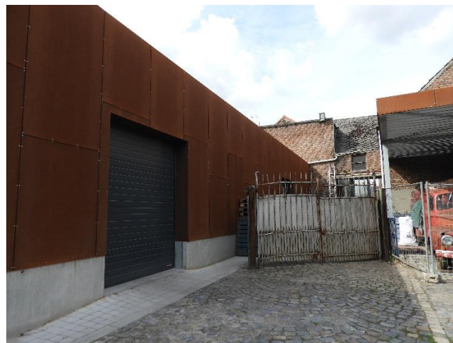
Foto 18: Het bijgebouw in cortenstaal ten zuiden van de brouwerijvleugel (06.10.2021).
