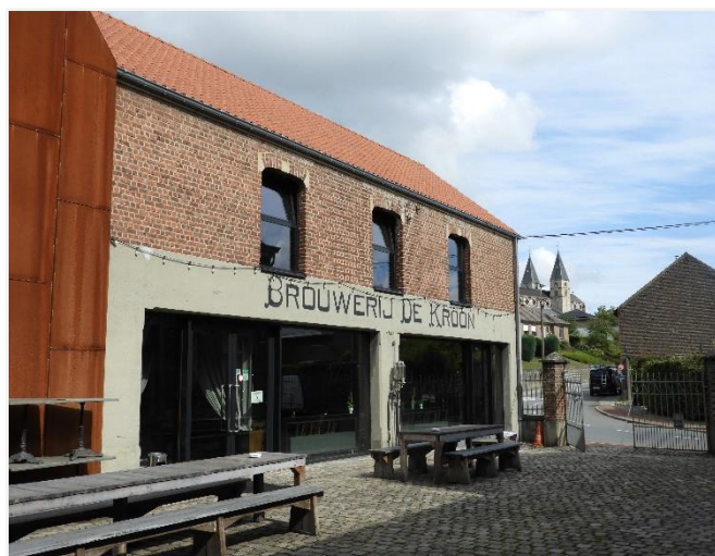
Foto 12: De noordvleugel vanuit het zuidwesten, erfgevel (09.09.2019).
