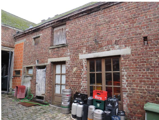
Foto 17: Bijgebouw met voormalige paardenstal (06.10.2021).
