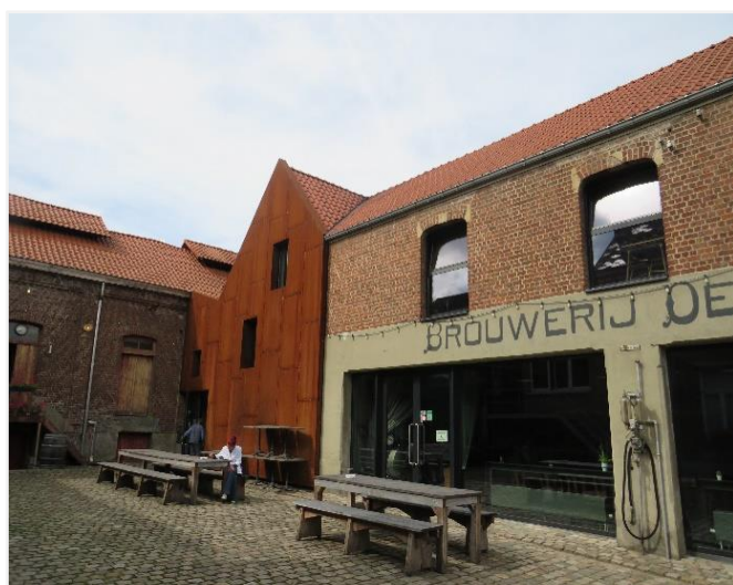
Foto 10: De hoek van het brouwerijgebouw en de noordvleugel, erfzijde (09.09.2019).
