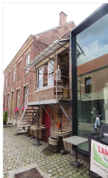
Foto 16: Het kantoorgebouw, erfgevel (06.10.2021).
