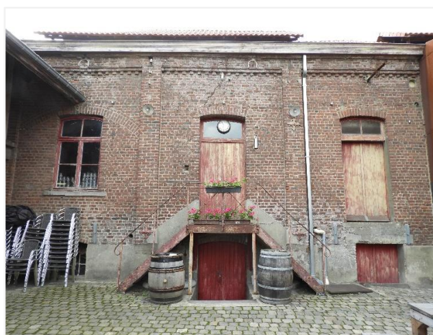
Foto 8: Het brouwerijgebouw, erfgevel (09.09.2019).
