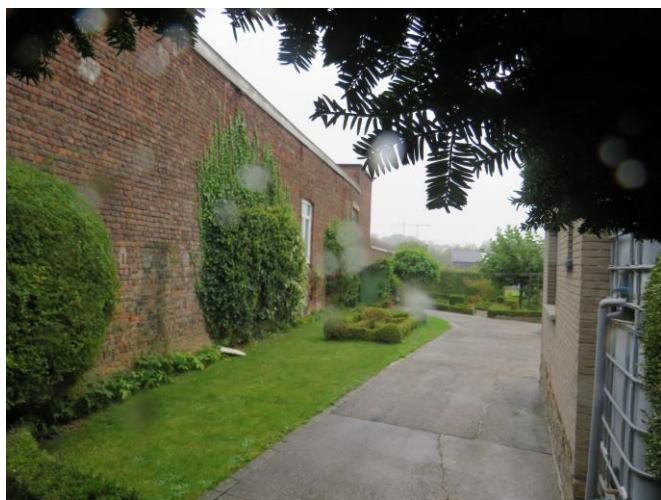
Foto 7: Het brouwerijgebouw, westgevel (06.10.2021)
