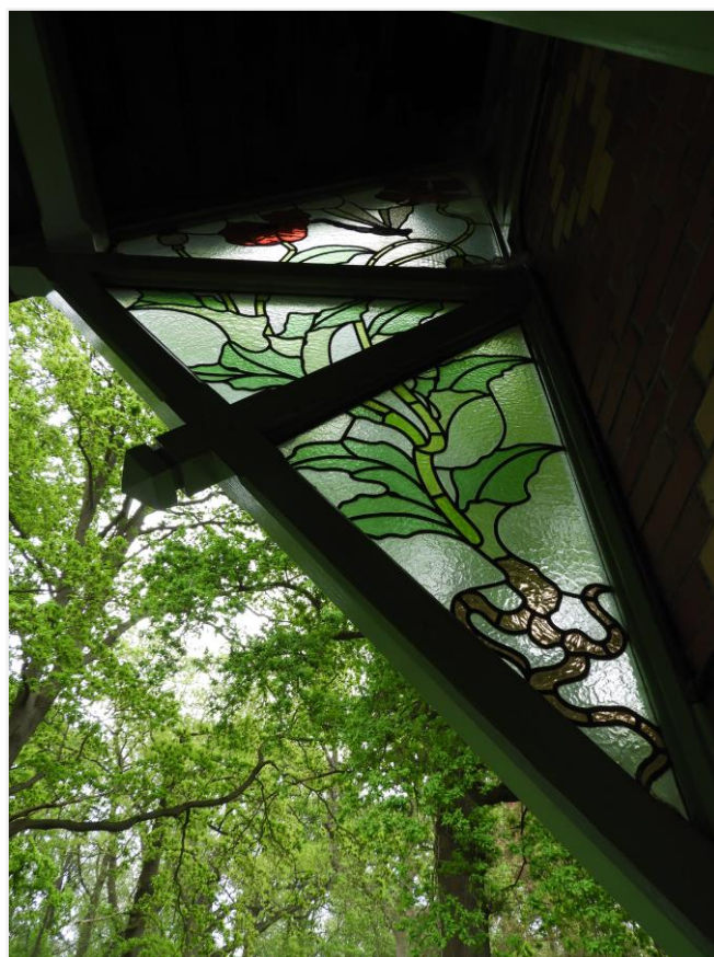
Foto 13: Detail glas-in-loodpaneel in de schoor van de luifel aan de zuidelijke erker, T. Pevernagie, 25 april 2022
