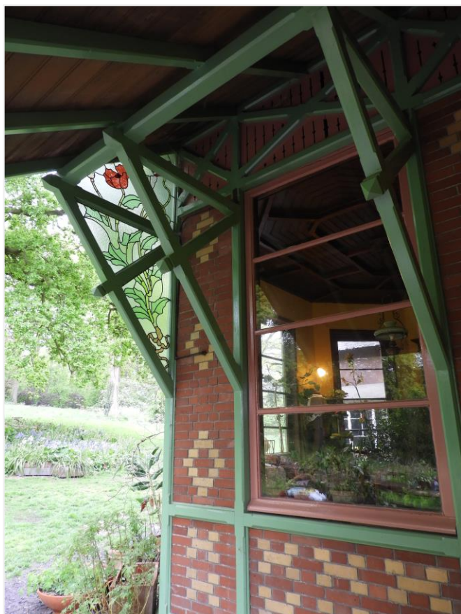
Foto 12: Detail zuidelijke erker Villa Louisa met glas-in-loodpanelen in de schoren van de luifels gerealiseerd door glazeniersatelier 'Colpaert Frères', T. Pevernagie, 25 april 2022
