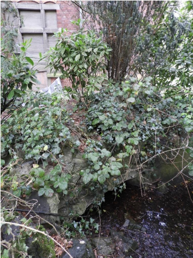
Foto 76: Vijver nabij het washuis, afvoer, foto T. Pevernagie, 25 april 2022
