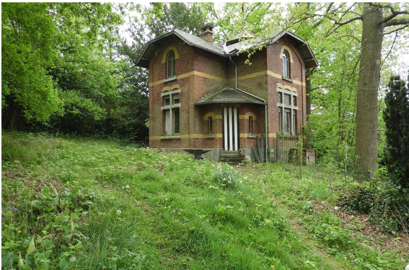
Foto 22: Washhuis met hekje, gebouwd in 1901. Kenmerkend in de rood bakstenen gevels zijn de banden en ontlastingsbogen in gele baksteen en de stenen raamkozijnen, H. Verboven, 20 april 2022.
