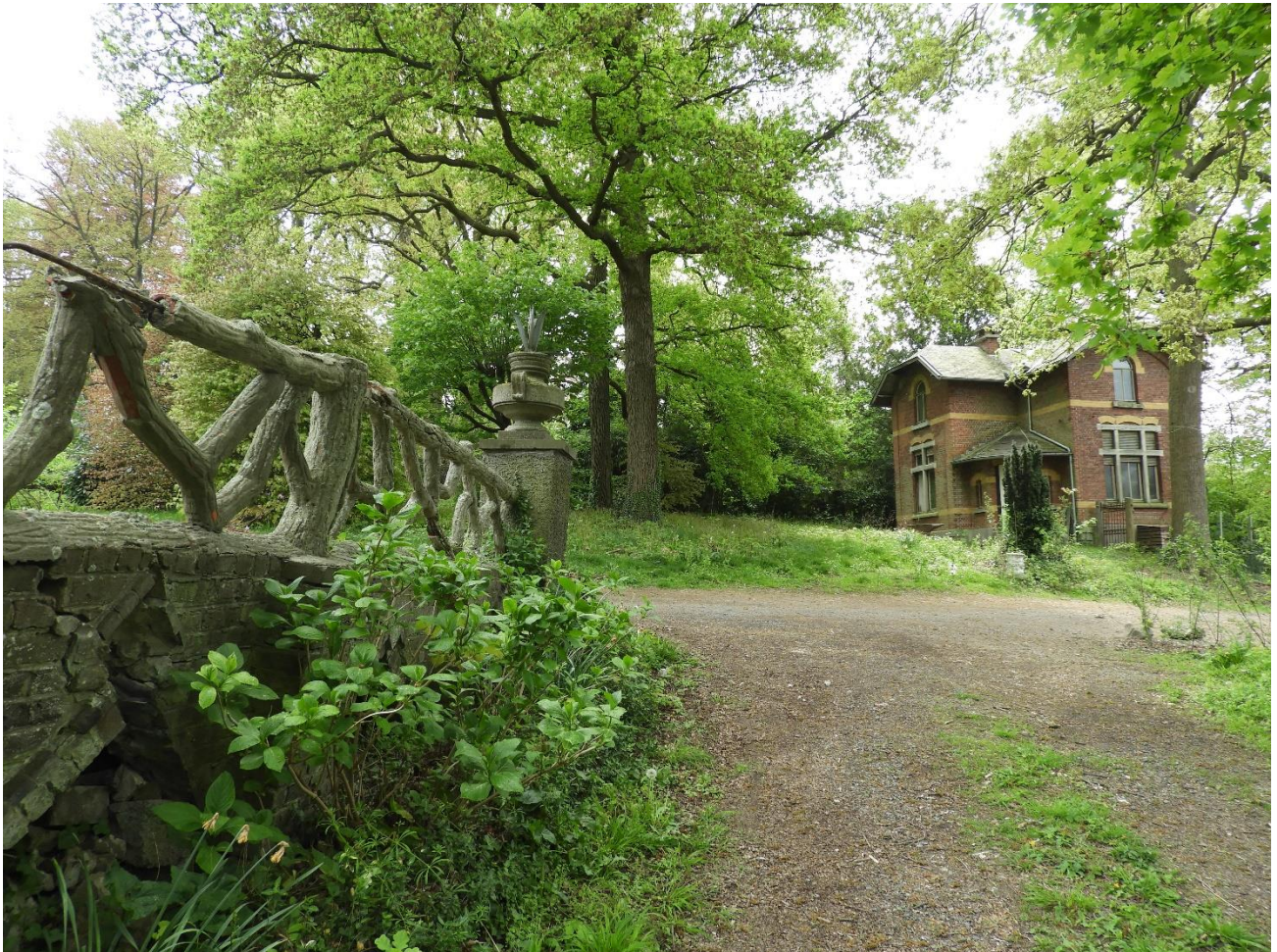
Foto 46: Eindpunt keermuur, balustrade in cementrustiek, H. Verboven, 25 april 2022
