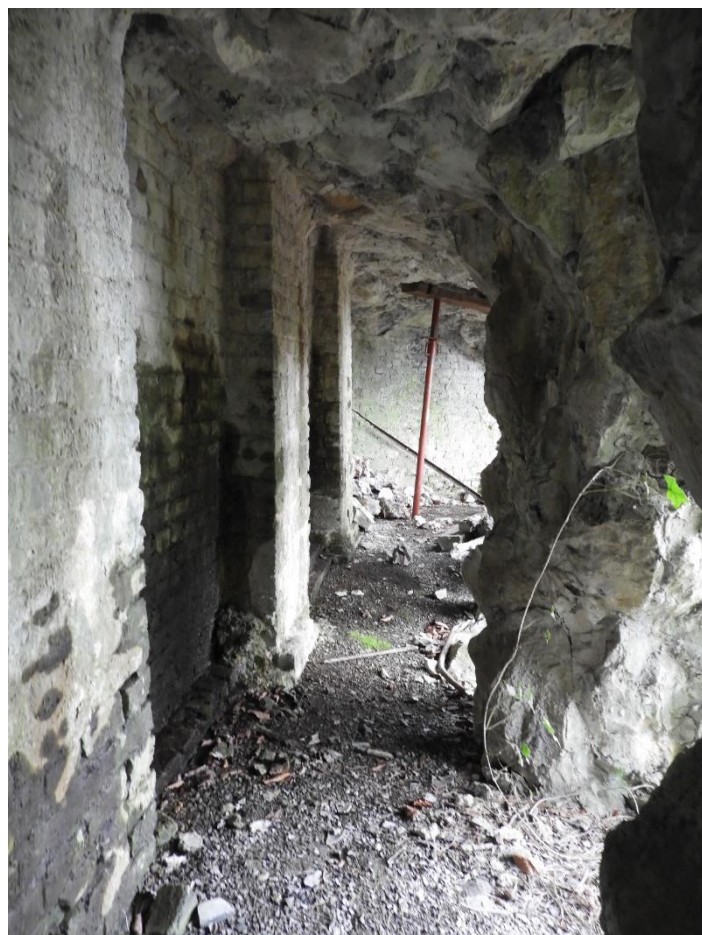
Foto 66: Onderste opvangbekken gestut, T. Pevernagie, 25 april 2022
