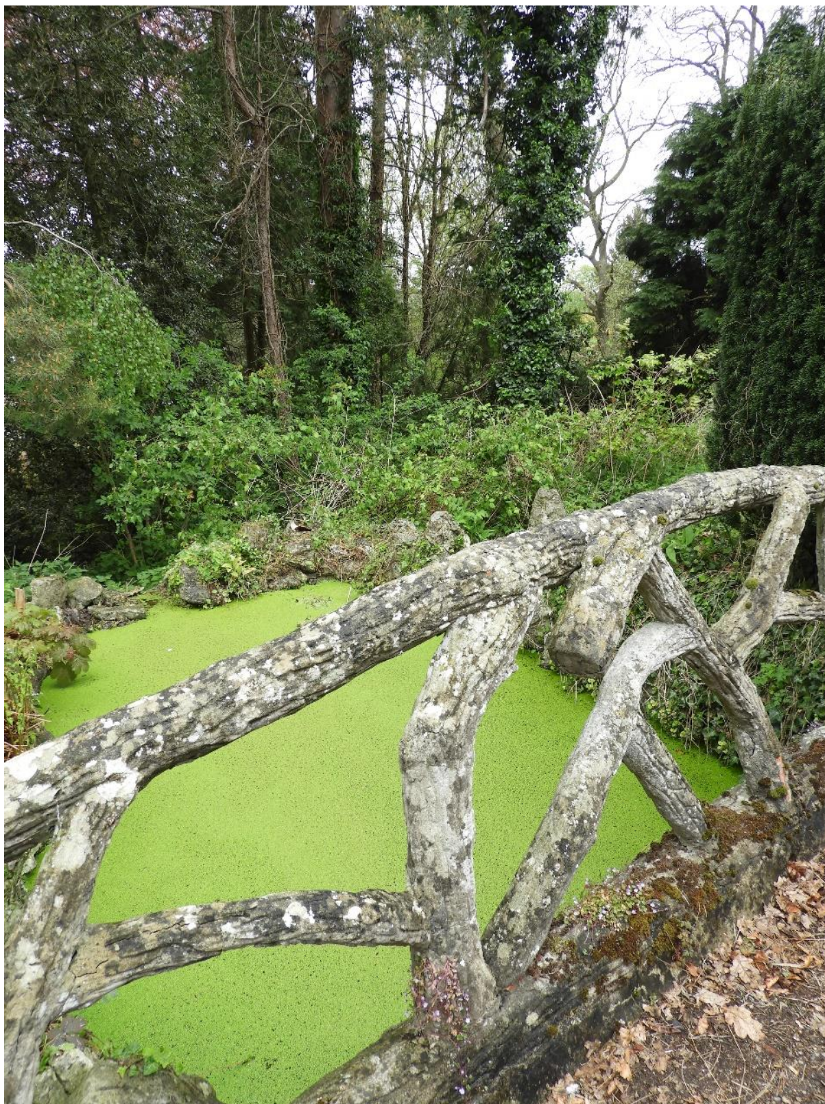
Foto 64: Cascade: bovenste opvangbekken. Balustrade in cementrustieke imitatieboomstammetjes T. Pevernagie, 25 april 2022
