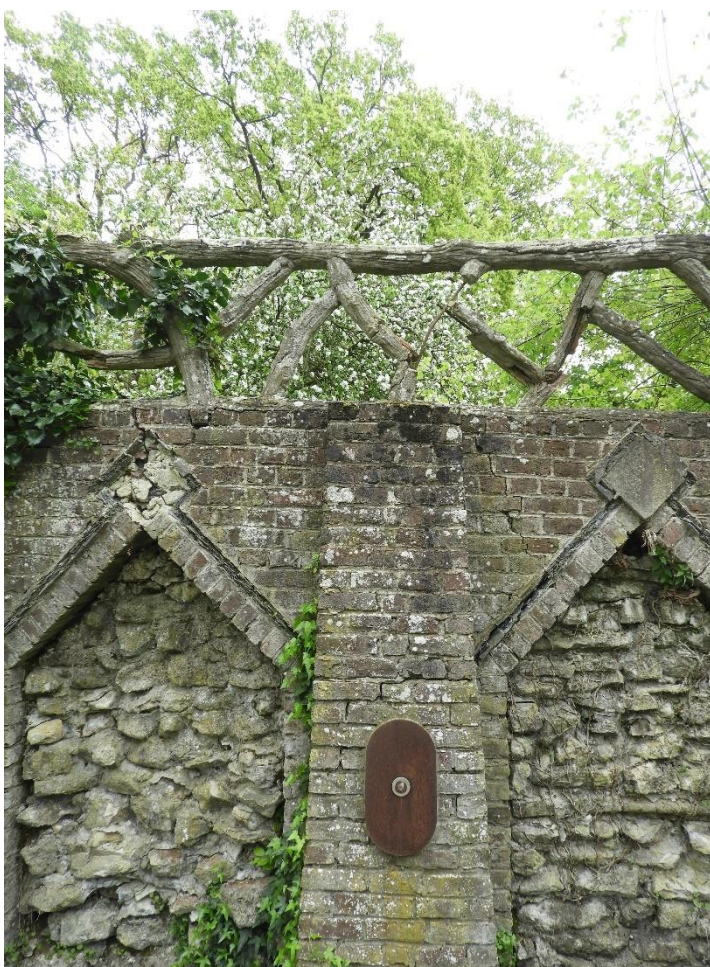
Foto 45: Motief en verankering in de keermuur, T. Pevernagie, 25 april 2022
