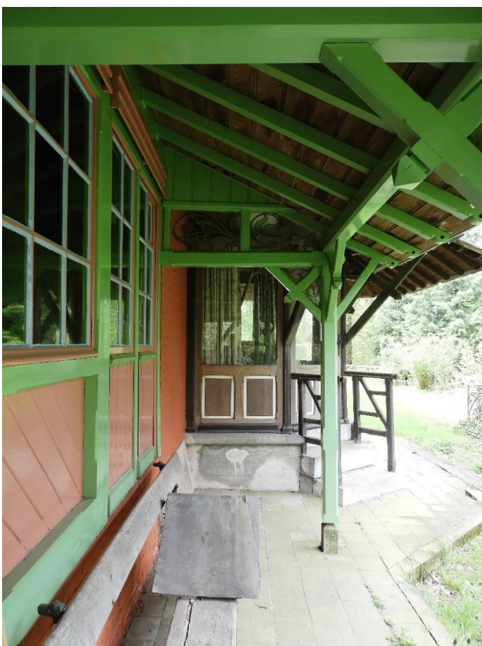
Foto 9: Voorgevel, onder de overkapping, T. Pevernagie, 25 april 2022
