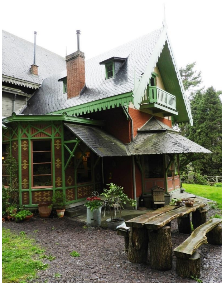
Foto 11: Zijgevel villa Louisa, na restauratie, T. Pevernagie, 25 april 2022
