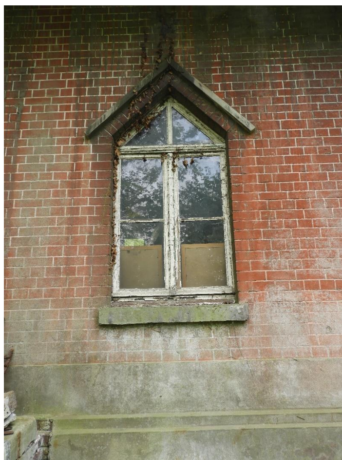
Foto 26: Koetshuis, kepervormig raam, T. Pevernagie, 25 april 2022
