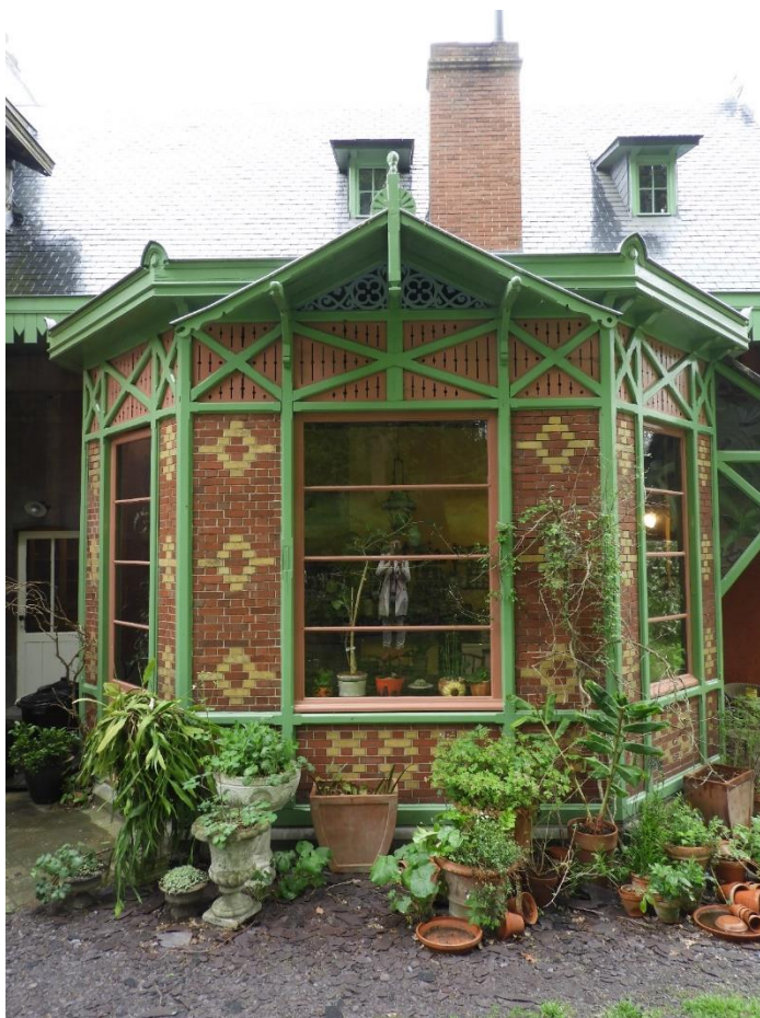
Foto 10: Zijgevel villa Louisa, na restauratie, T. Pevernagie, 25 april 2022
