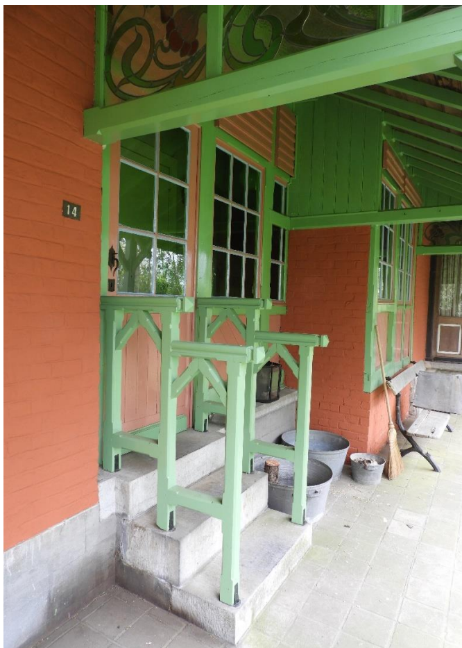
Foto 8: Voorgevel, onder de overkapping, T. Pevernagie, 25 april 2022
