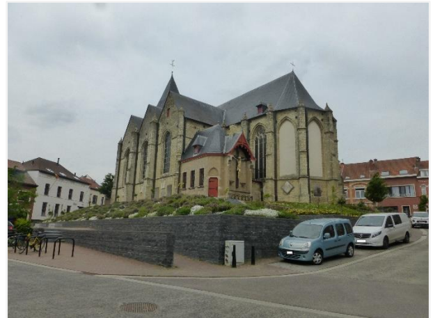
Foto 8: Sint-Servatiuskerk: totaalbeeld zuidkant.
