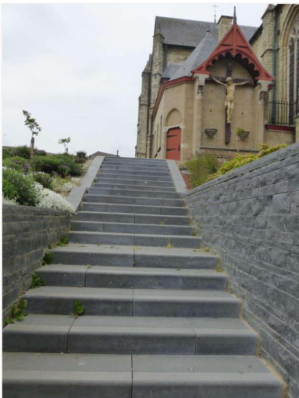
Foto 3: Sint-Servatiuskerk: oostelijke toegang.
