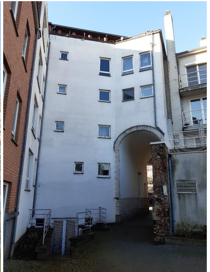
Foto 20: achtergevel van weeshuis met noordelijke doorgang (28 februari 2023).
