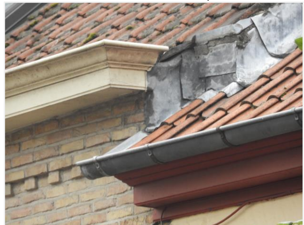
Foto 4: afwerking van het nieuwe gevelparament
