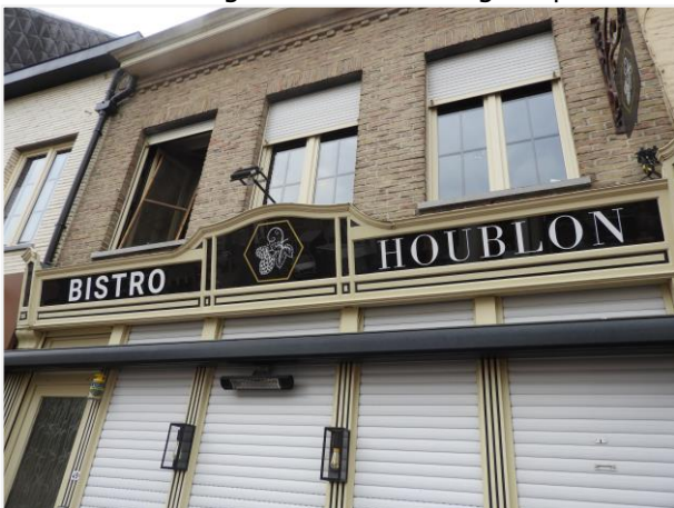
Foto 5: Bovenbouw van de gevel met nieuw schrijnwerk
