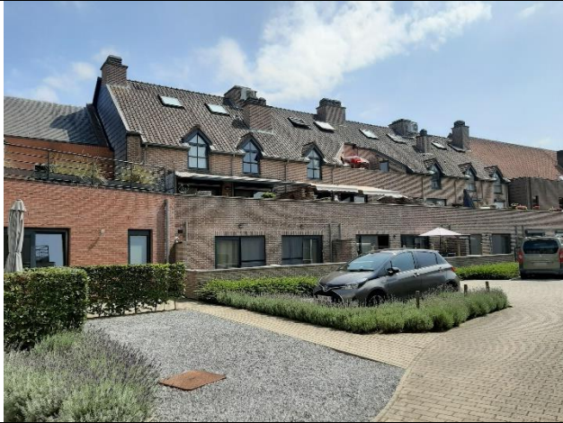
Foto 1: Appartementengebouw en parking
