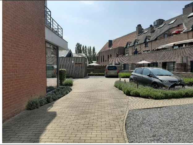
Foto 2: Appartementengebouw en parking
