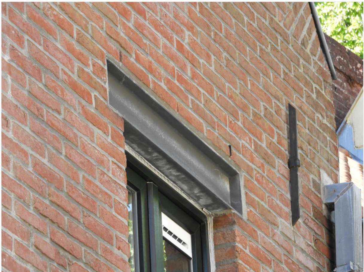
Foto 3: voorgevel, detail vensteropening bovenverdieping en aanzet van de vlechtingen, 22 juni 2022
