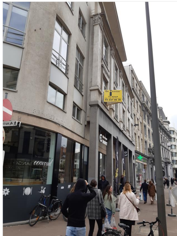
Foto 5: Zijaanzicht geïntegreerd deel noordgevel voormalig Hotel Saint-Antoine Groenplaats 40, 40a (© agentschap Onroerend Erfgoed 30 april 2022)
