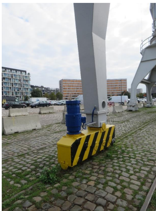
Foto 9: Portaalpoot met bogie met motor (landzijde) (14.10.2021).
