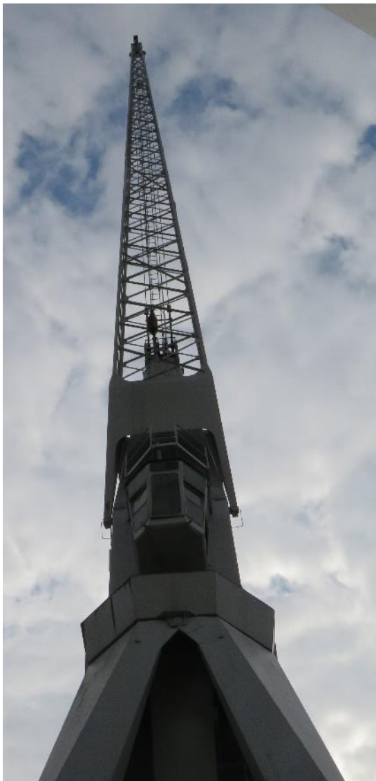
Foto 17: Toren en giek (14.10.2021).
