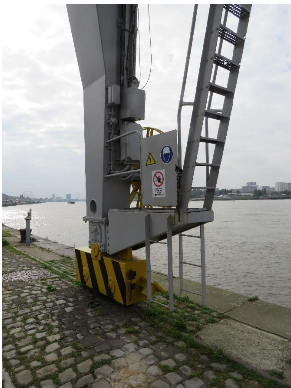
Foto 6: Portaalpoot met bogie en toegangsladder (kaaizijde) (14.10.2021).
