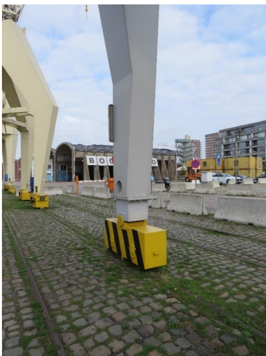
Foto 8: Portaalpoot met bogie (landzijde) (14.10.2021).
