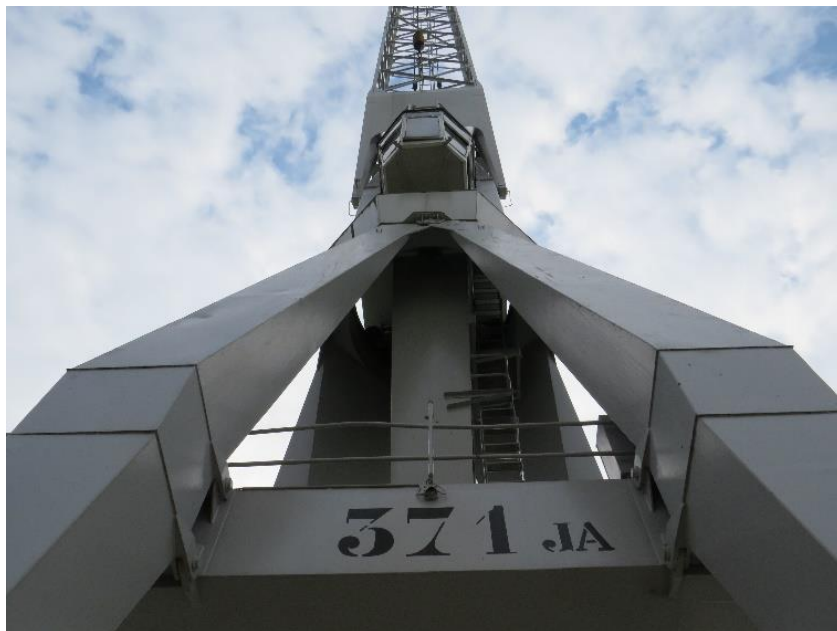
Foto 16: Bovenste deel van het portaal waarin de draaibare bovenbouw van de kraan pivoteert (14.10.2021).
