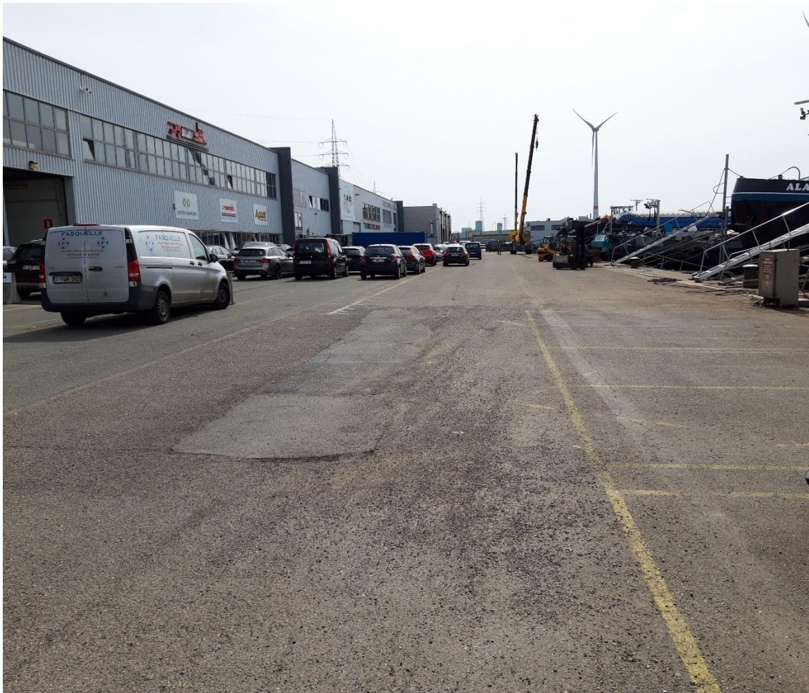
Foto 3: Foto van de geasfalteerde sporen van de (naar de Rijnkaai overgebrachte) elektrische kraan nr. 347 IA aan de Vossesdijnstraat zonder nummer, 12.04.2022 (bron: archief Onroerend Erfgoed, foto genomen door Martijn Kivit)
