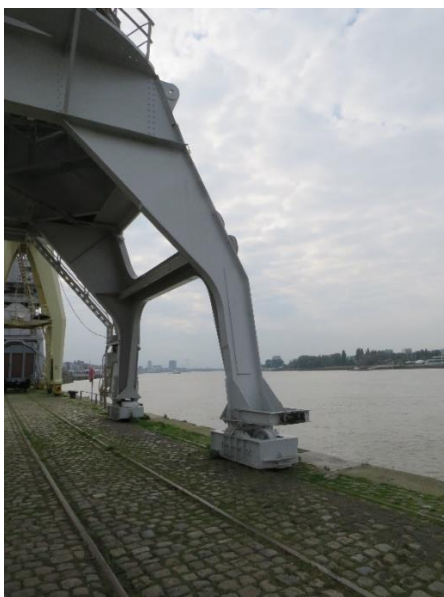
Foto 10: Poten van het portaal aan de kaaizijde (14.10.2021).
