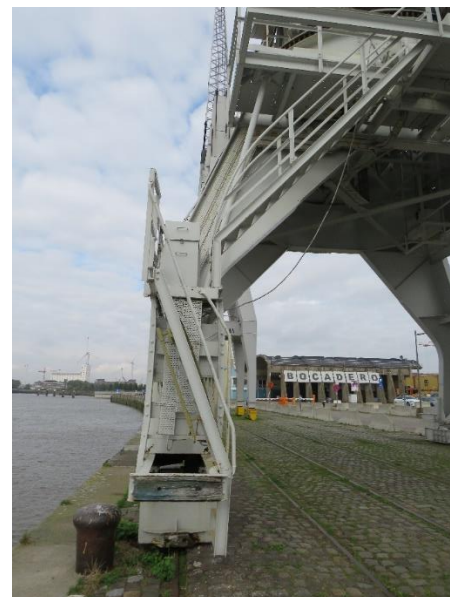
Foto 12: Trap naar de machinekamer (14.10.2021).
