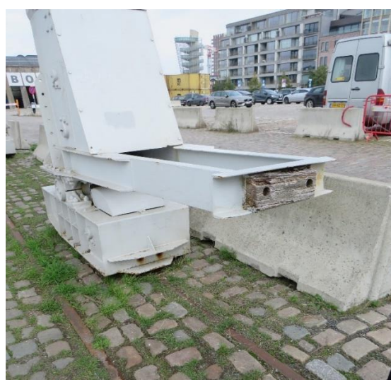
Foto 9: Portaalpoot met bogie (landzijde) (14.10.2021).
