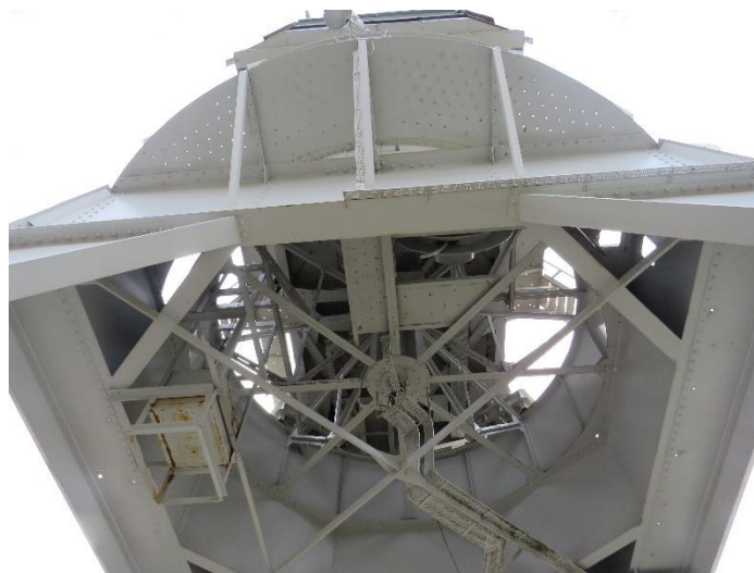
Foto 14: Onderzijde van het bordes: geklonken portaalconstructie (14.10.2021).
