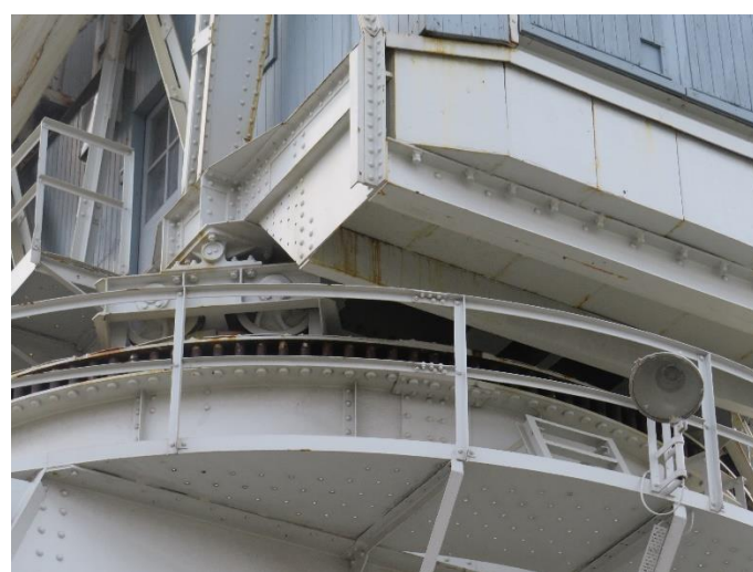
Foto 19: Op koningsas en ringrail draaibare bovenbouw (14.10.2021).
