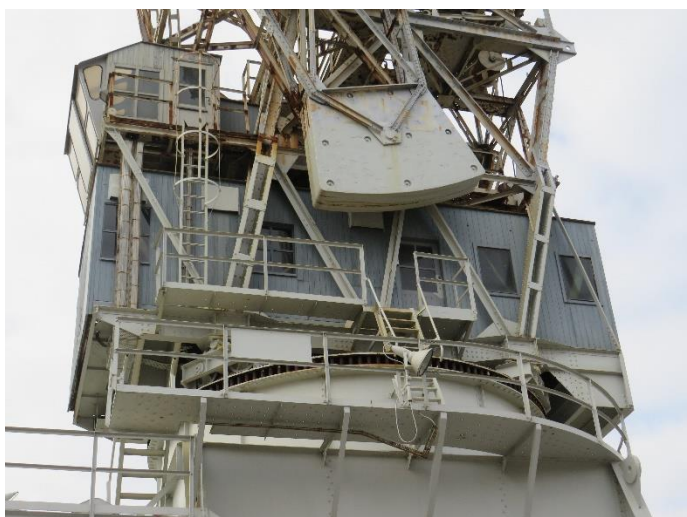
Foto 18: Draaibare bovenbouw met machinekamer en stuurcabine (14.10.2021).
