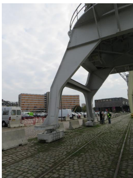
Foto 11: Poten van het portaal aan de landzijde (14.10.2021).
