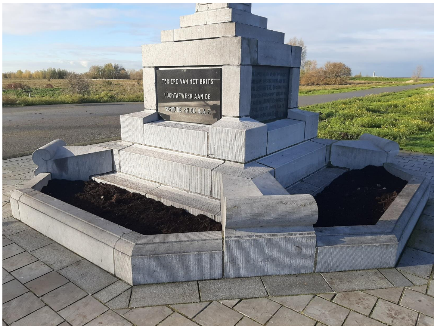
Foto 7: Detail van het basement.
