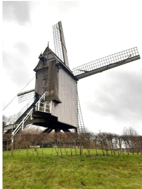
Foto 18: trapweeg en steenrechtzijde
