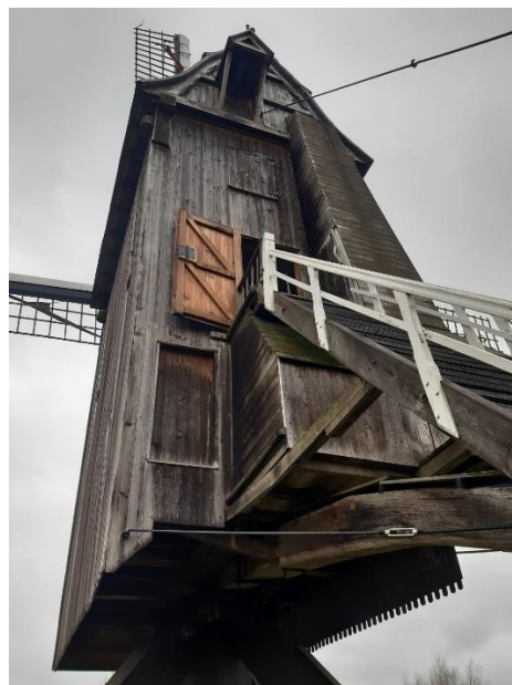
Foto 25: trapweeg met kombuis, Riemenkast, luikapje,...
