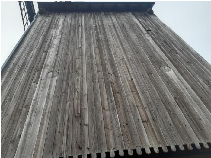
Foto 22: beplanking molenkast (met loergaten en onderaan geschulpt)
