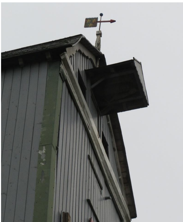
Foto 21 - De Mortiersmolen. Molenkap met luikapje en makelaar met windvaan (met wapenschild 'de Liedekerke'.
