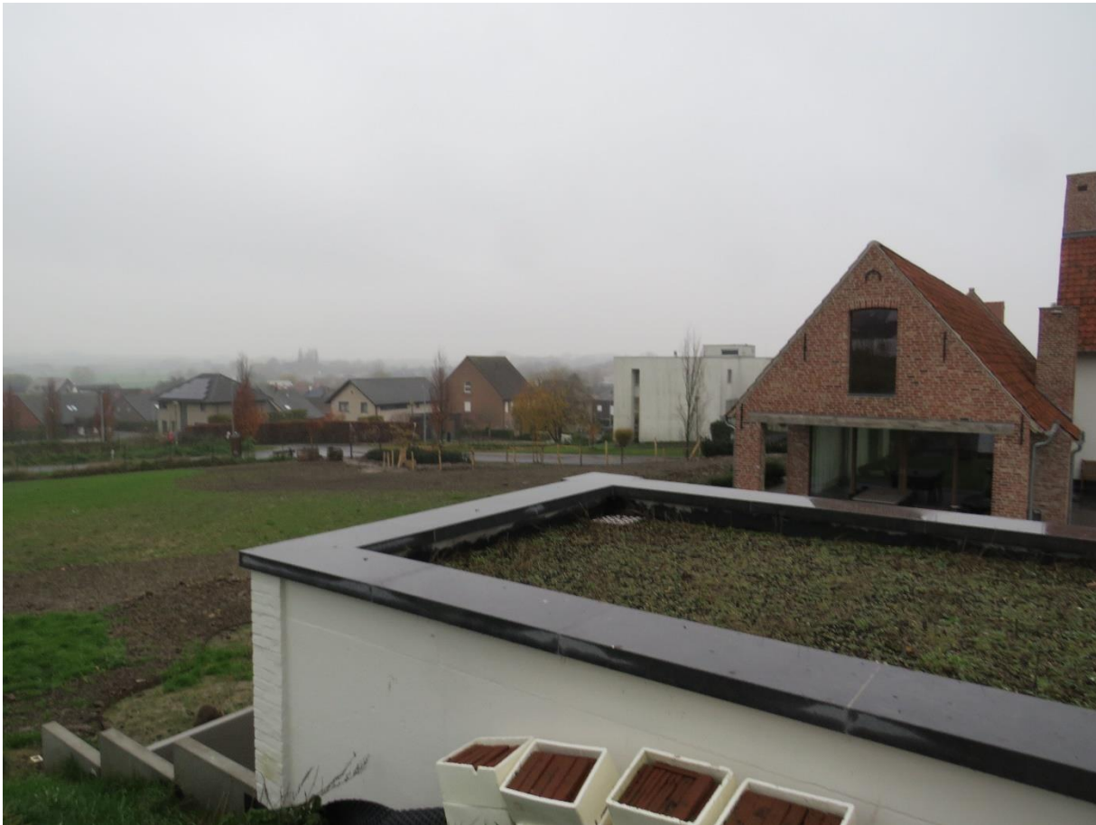
Foto 1 - Zicht vanop de molenbelt in westelijke richting.
