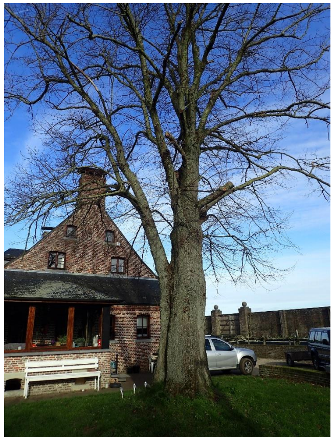
Foto 6: Aanbouw serre tegen de linker of zuidelijke zijgevel (10.02.2023)
