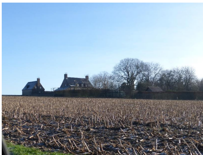
Foto 2: Zicht op de Oude Pastorie en garage vanuit het westen (17.01.2023)
