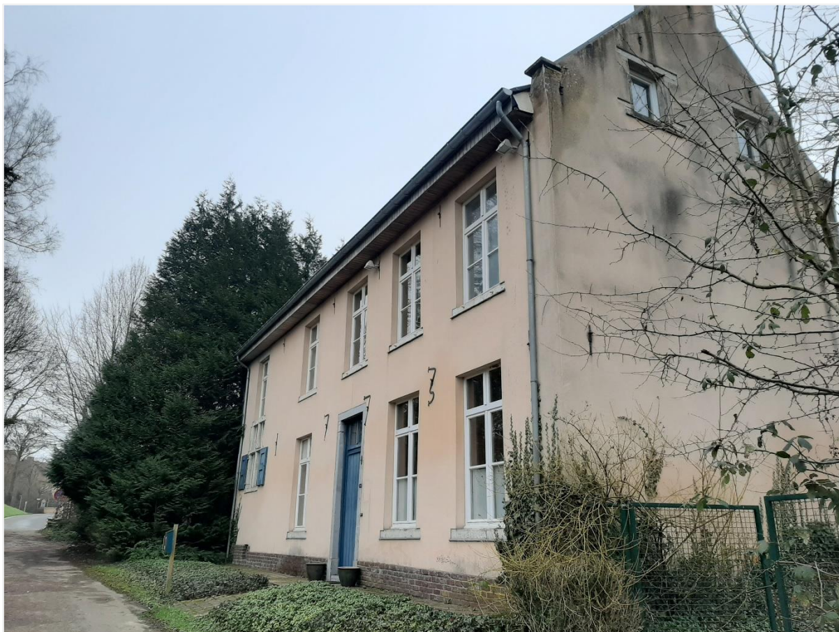
Foto 5: De afgebroken afspanning De Drie Haringhe bevond zich oorspronkelijk aan de linkerzijde van dit woonhuis uit 1773.
