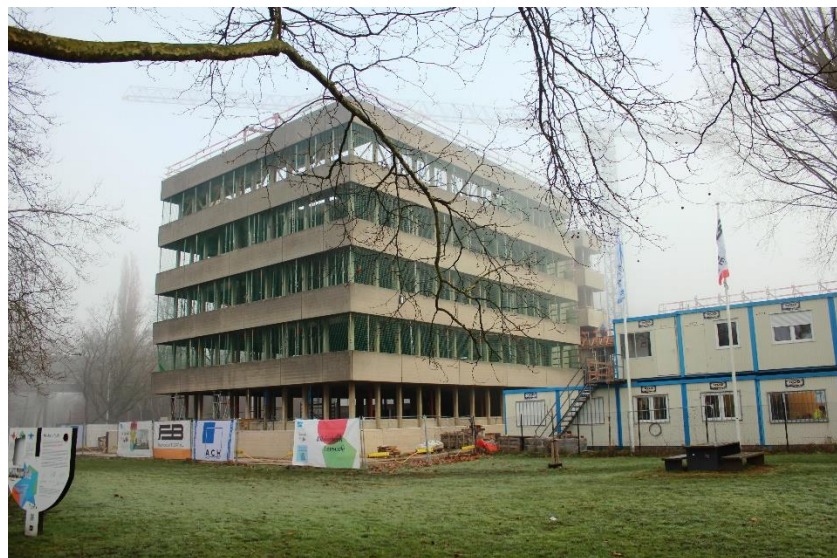
Foto 19: het vroegere administratief centrum van Gentbrugge, momenteel in renovatie
