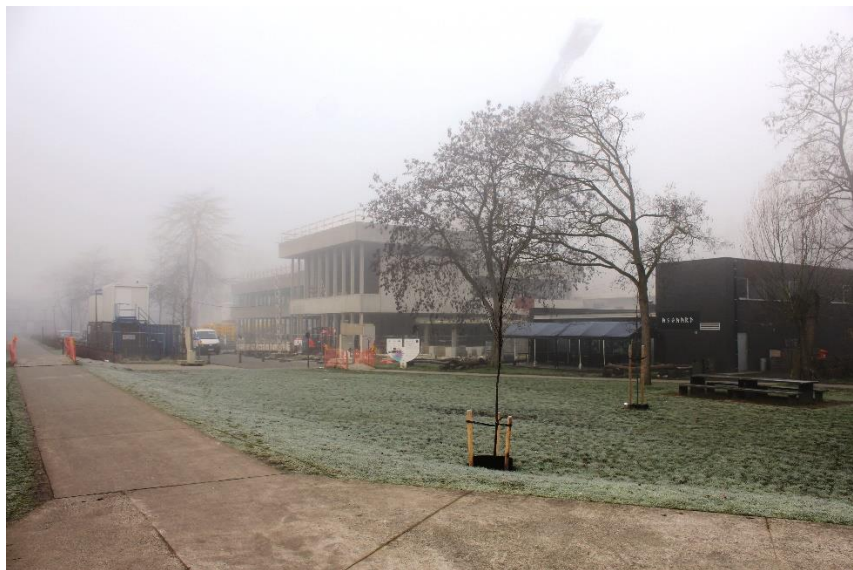
Foto 15: het vroegere administratief centrum van Gentbrugge, momenteel in renovatie
