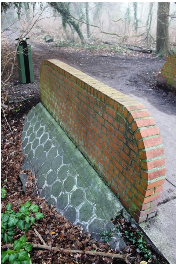
Foto 1: toegangsbrug van het park aan de Braemkasteelstraat
