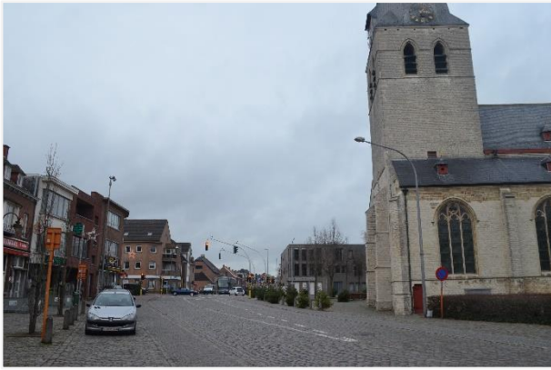
Foto 1: Locatie van de verdwenen afsluitmuur, zuidwest van de kerk
