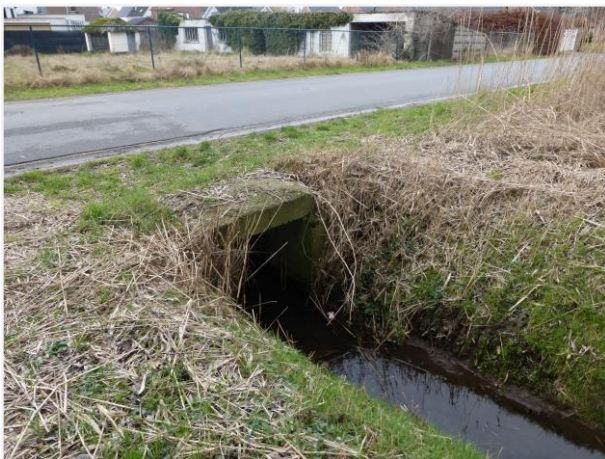
Foto 3: Duiker op bovensloot in overgangszone ten zuidwesten van de watering.
