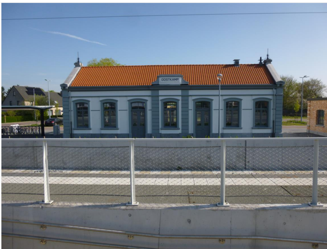
Foto 1: Het station van Oostkamp, oorspronkelijke straatzijde. Het gevelaanzicht verradt de oorspronkelijke binnenindeling met een onderscheid tussen de ingang voor reizigers in eerste en tweede klasse links en derde klasse rechts. Met tussenin een accentuerende middenrisaliet.
