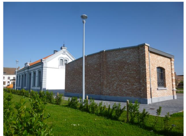
Foto 17: wachthuisje en stationsgebouw vanaf de spoorzijde
