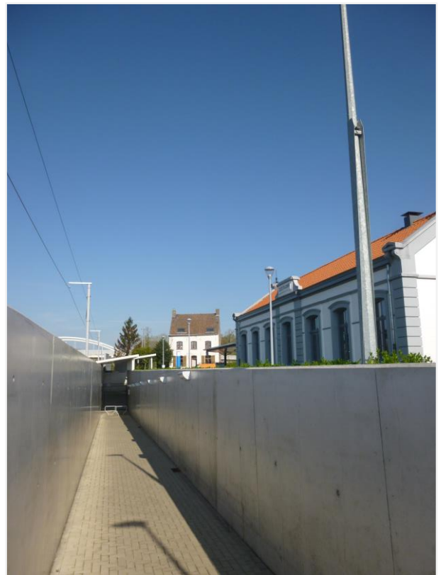
Foto 12: zicht op het station en de toegang tot de tunnel onder de sporen
