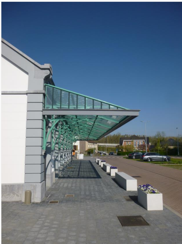
Foto 11: zijaanzicht van de luifel, uitgevend op het nieuw gecreëerde stationsplein
