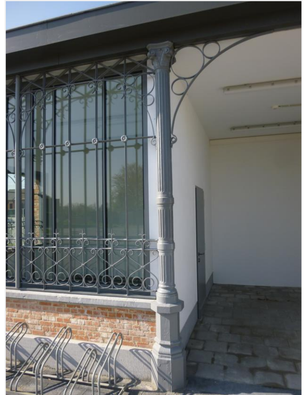
Foto 15: detail van smeedwerk en gietijzeren pilaster
