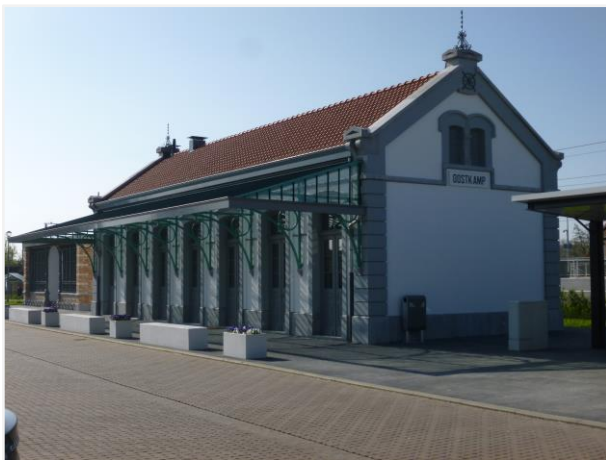
Foto 5: zijdelings zicht op noordgevel
