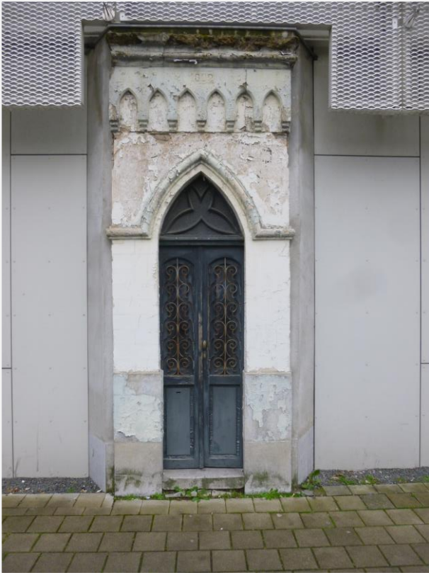
Foto 1: gevel van de kapel (5 mei 2022)
