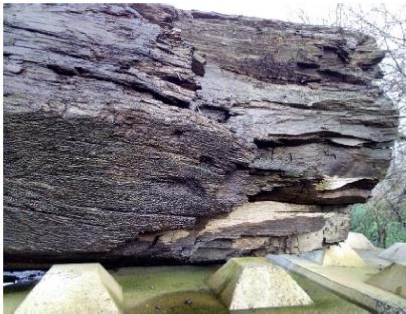
Foto 2: Het in slechte toestand verkerende restant van de standaard, het enige overgebleven molenonderdeel (© Monumentenwacht West-Vlaanderen, 15.01.2020).
