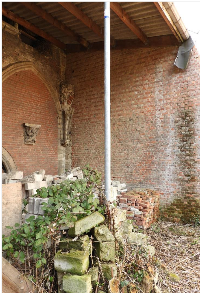
Foto 5: Overgang tussen de westgalerij (blijft beschermd als monument) en de locatie van de verdwenen noordgalerij van de Sint-Geertruiabdij.
