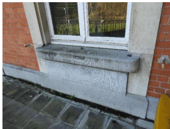
Foto 9: Oostelijke voorgevel. Detail venster met lekdrempel en omlijsting.
