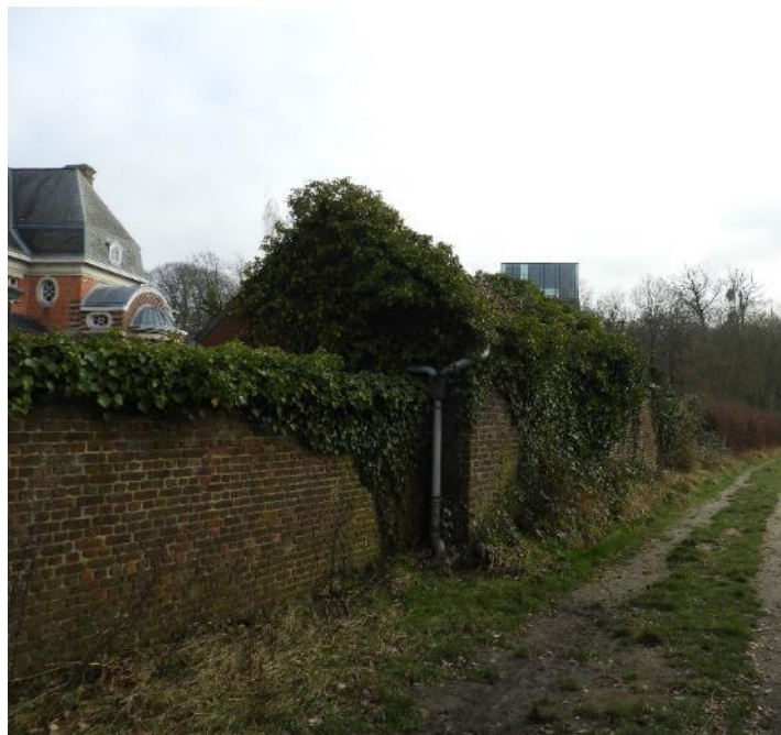
Foto 31: Ten westen. Zicht op noordelijke zij- en westelijke achtergevel van kasteel, in verte toren van ziekenhuis. Afsluiting grenst aan vroegere Buurtweg 18 en verbindingsweg Pellenberg-Lovenjoel, thans voetwegel.
