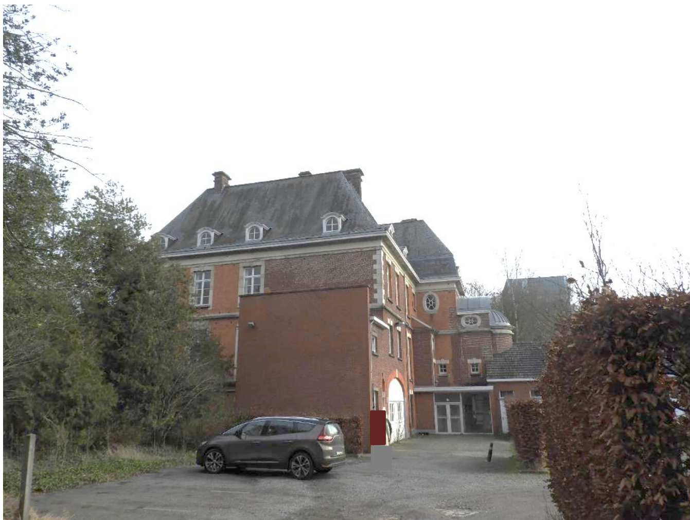
Foto 23: Zicht op noordelijke zij- en westelijke achtergevel. Vooraan ingekorte lagere aanbouw met wachtgevel.
