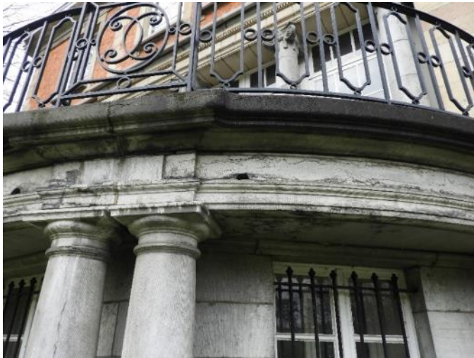
Foto 15: Zuidelijke zijgevel. Details terras.
