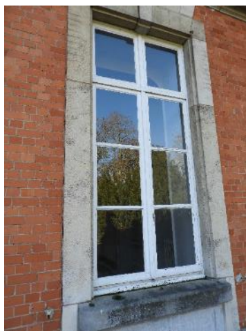
Foto 8: Oostelijke voorgevel. Detail venster met lekdrempel en omlijsting.
