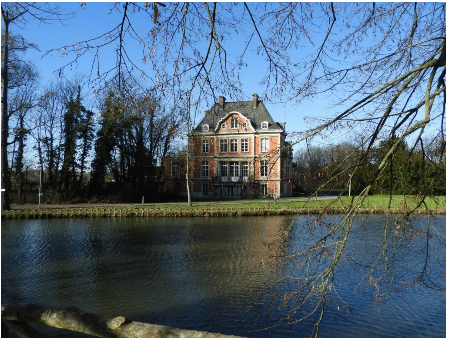
Foto 53: Zicht op zuidelijke zijgevel van kasteel vanop bruggetje in cementrustiek.
