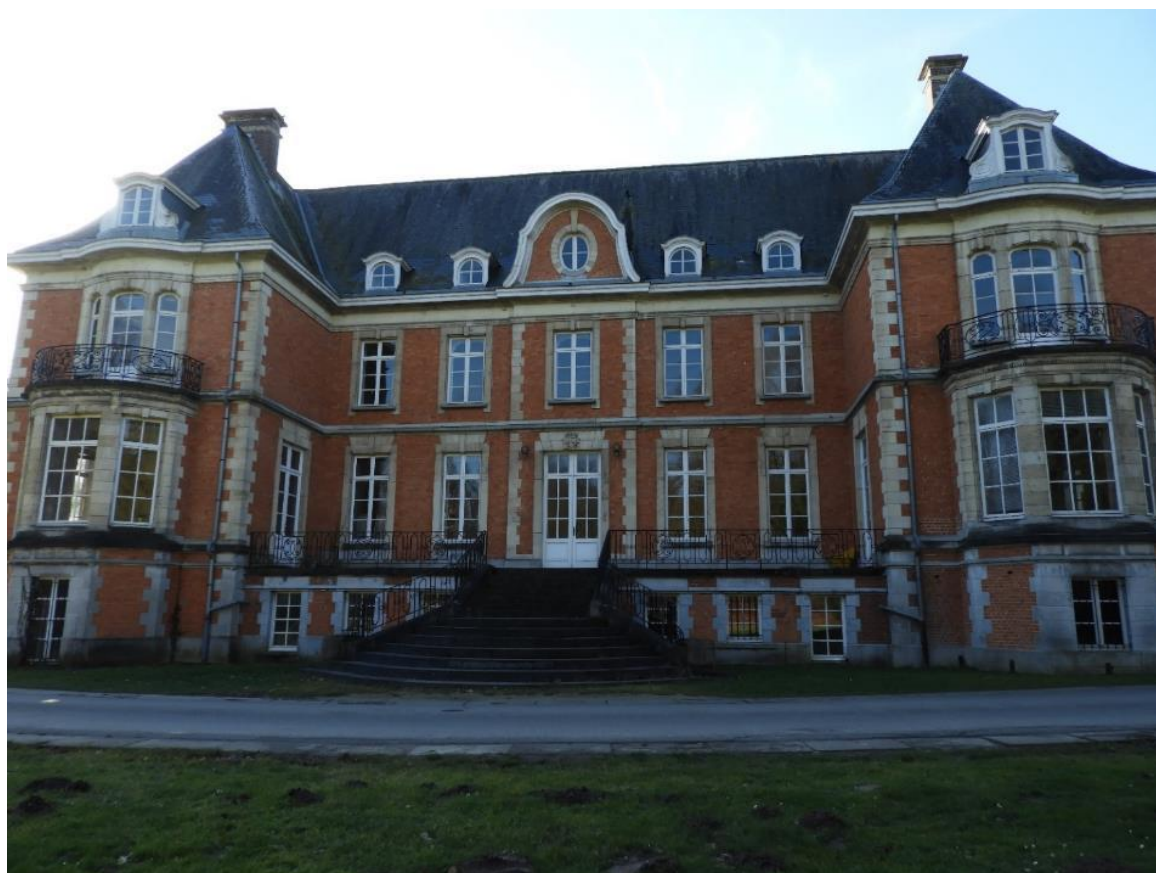
Foto 2: Zicht op oostelijke voorgevel. Kasteel gekenmerkt door U-vormige plattegrond met verdiept middendeel; opbouw van twee bouwlagen en souterrain onder snijdende schild- en zadeldaken; verwerking van blauwe hardsteen, bak- en (simili)natuursteen.
