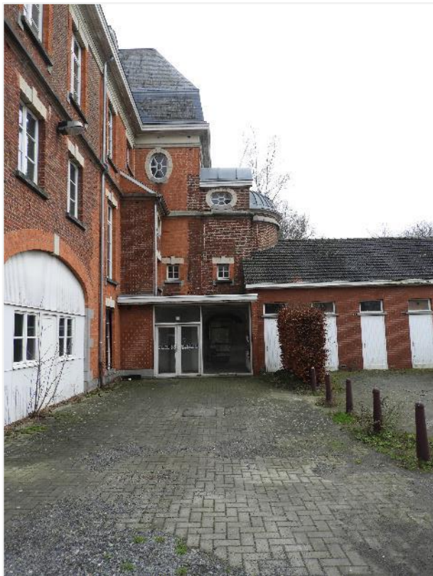
Foto 21: Westelijke achtergevel. Centrale traptravee met halfronde uitbouw onder halve koepel en ovaalvormige vensters.
