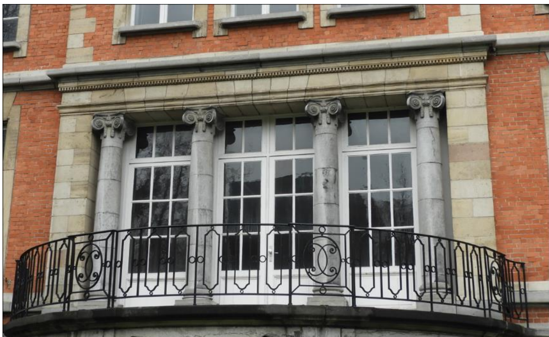
Foto 17: Zuidelijke zijgevel. Verhoogde begane grond. Detail terras en hardstenen halfzuilen met pseudo-Ionisch kapiteel aan drieledige deur- en vensterpartij.
