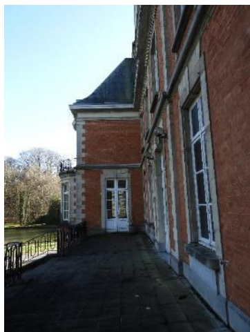
Foto 7: Oostelijke voorgevel. Terras.
