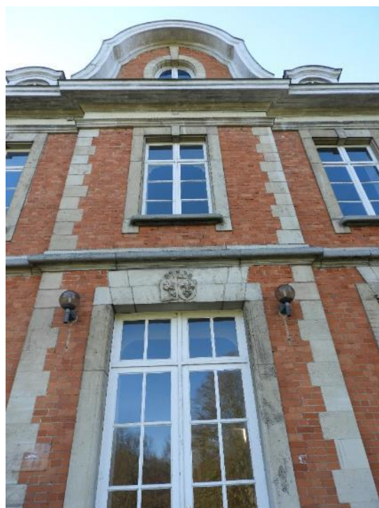
Foto 6: Oostelijke voorgevel. Middentravee.
