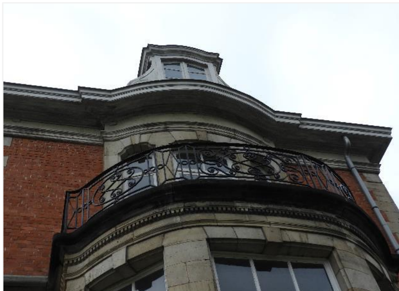
Foto 10: Oostelijke voorgevel. Driezijdige ééntravee-brede zuidoostelijke erker.
