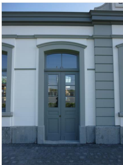
Foto 8: zuidzijde, vleugel deur met identieke omlijsting als de vensters, plint in hardsteen
