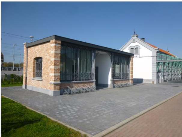
Foto 16: wachthuisje en stationsgebouw vanaf het stationsplein
