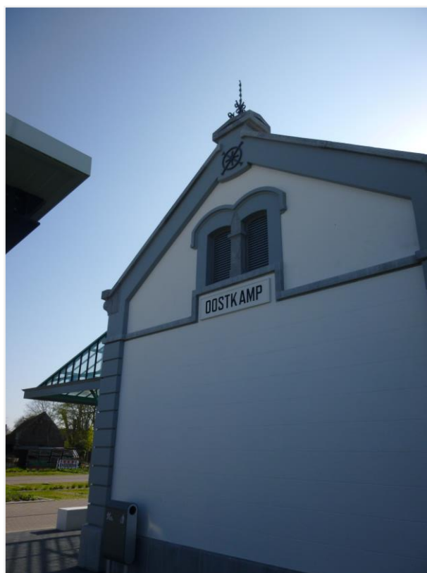
Foto 3: Westgevel met typerend gekoppeld venster met hardstenen tussenstijl. Daarboven het wiel, symbool van de spoorwegen in smeedwerk.
