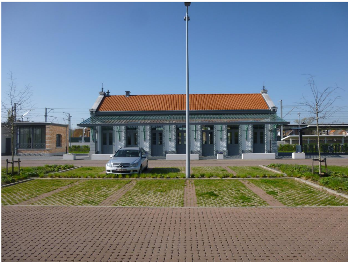
Foto 4: Station van Oostkamp, oorspronkelijk gevel aan de spoorzijde met de glazen luifel die ooit dienst deed als perronoverkapping. Heden perron voor buslijn.
