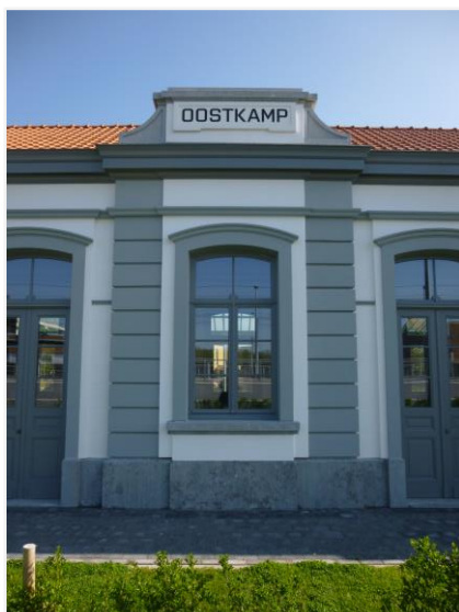
Foto 7: zuidzijde: middenrisaliet met geblokte pilasters, getoogde omlijsting onder geprofileerde waterlijst
