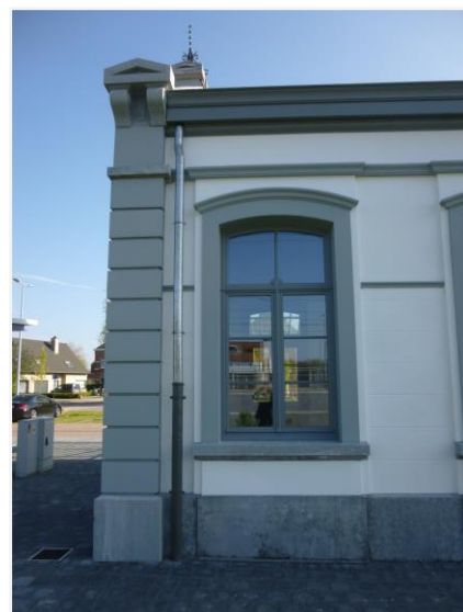
Foto 9: geblokte hoekpilaster, identieke vensteropening en waterlijst
