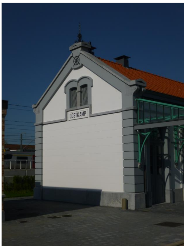
Foto 2: Oostgevel met typerend gekoppeld venster met hardstenen tussenstijl. Daarboven het wiel, symbool van de spoorwegen in smeedwerk.
