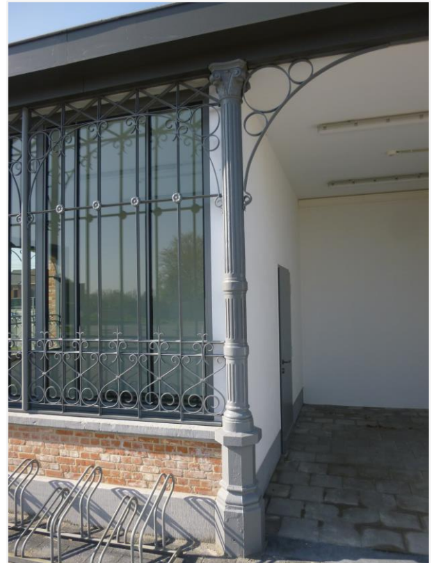
Foto 15: detail van smeedwerk en gietijzeren pilaster
