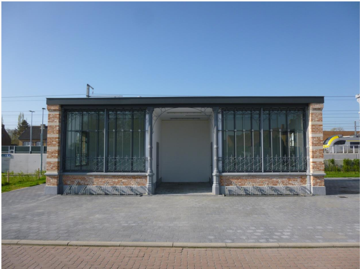
Foto 13: wachthuisje in baksteenmetselwerk. De voorgevel wordt gekenmerkt door de hoekpijlers met speklagen in zandsteen en de grote vensters met smeedwerk tussen gecanneleerde gietijzeren pilasters.
