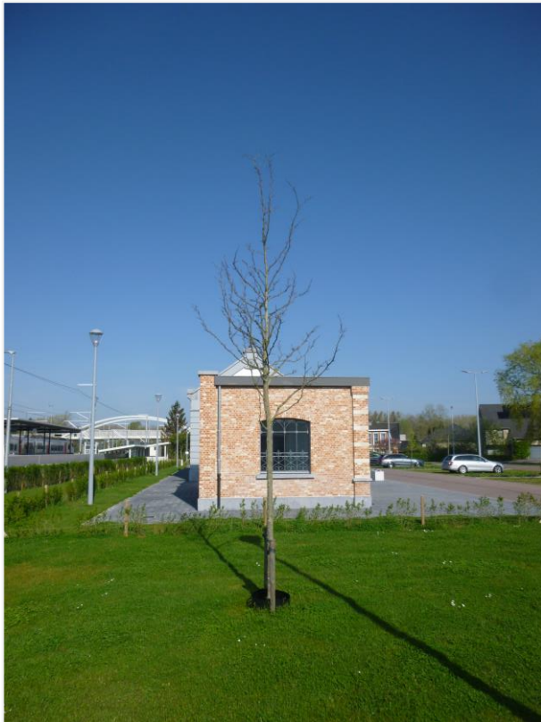
Foto 14: oostelijke zijgevel van het wachthuisje
