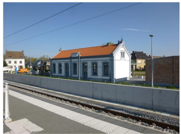
Foto 6: zijdelings zicht op zuidgevel
