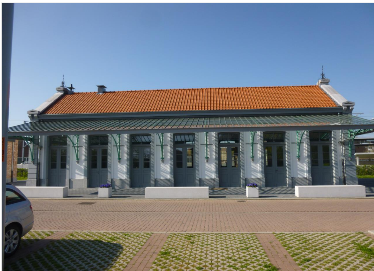
Foto 10: voormalige perronzijde met luifel. De deuropeningen zijn identiek aan deze van de voormalige straatzijde.
