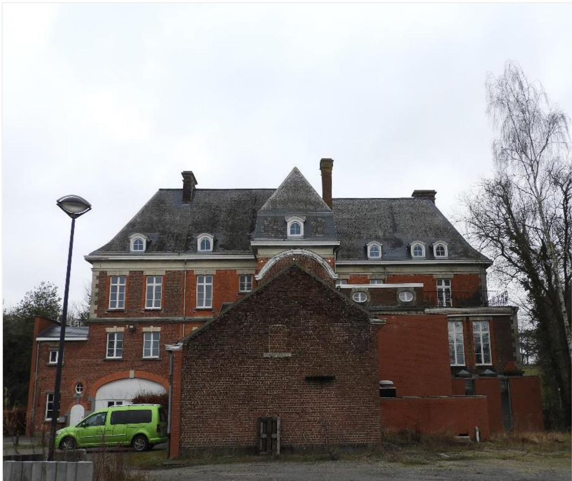
Foto 19: Westelijke achtergevel. Vooraan haaks geplaatste voormalige remise.
