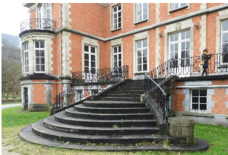
Foto 4: Oostelijke voorgevel met uitwaaiierende trap en terras met balustrade.
