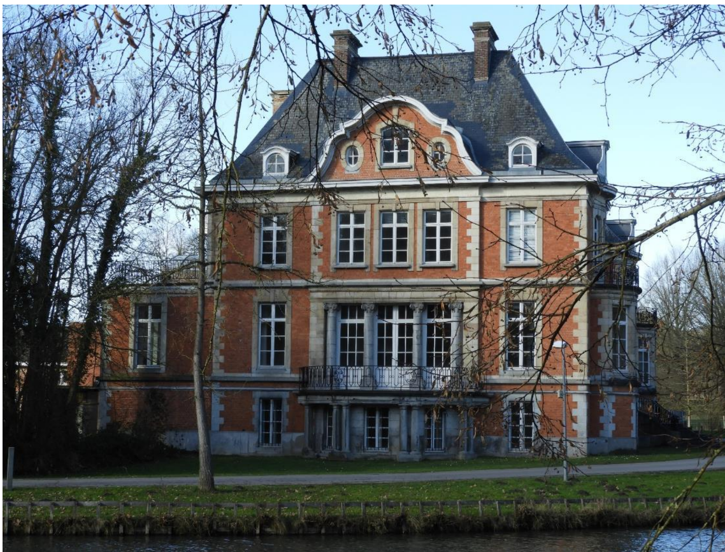
Foto 13: Zicht op zuidelijke zijgevel, gekenmerkt door geprononceerd middenrisaliet met halfcirkelvormig terras op halfzuilen en bekronende accolade- en klokvormige dakkapel.
