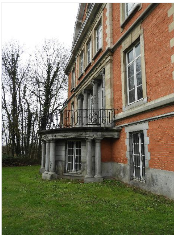
Foto 14: Zuidelijke zijgevel met halfcirkelvormig terras met halfzuilen in blauwe hardsteen en verzorgd siersmeedwerk.
