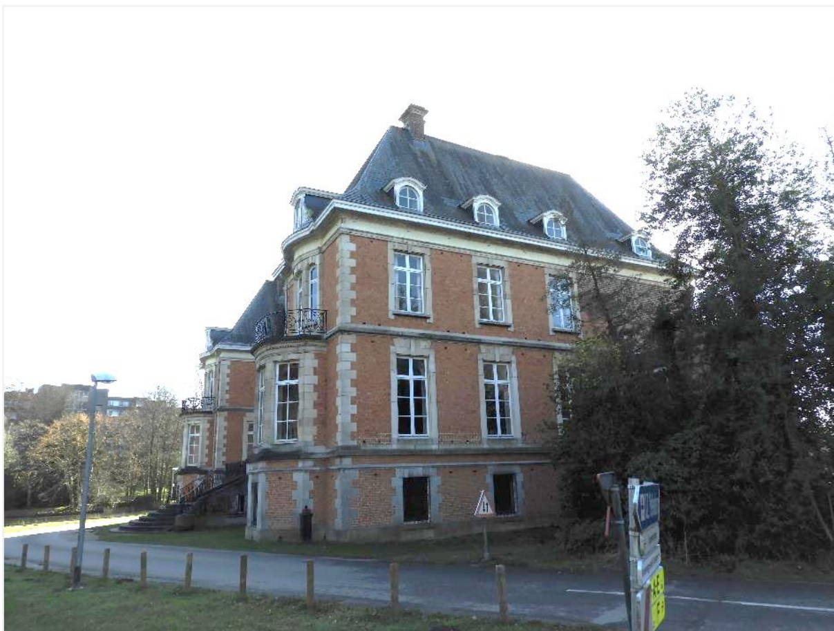
Foto 24: Zicht op oostelijke voorgevel en noordelijke zijgevel.
