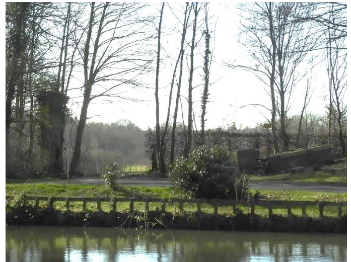
Foto 41: Zicht op de ontmantelde hekpijler (rechts) en de rechtopstaande (links) vanaf de vijver.
