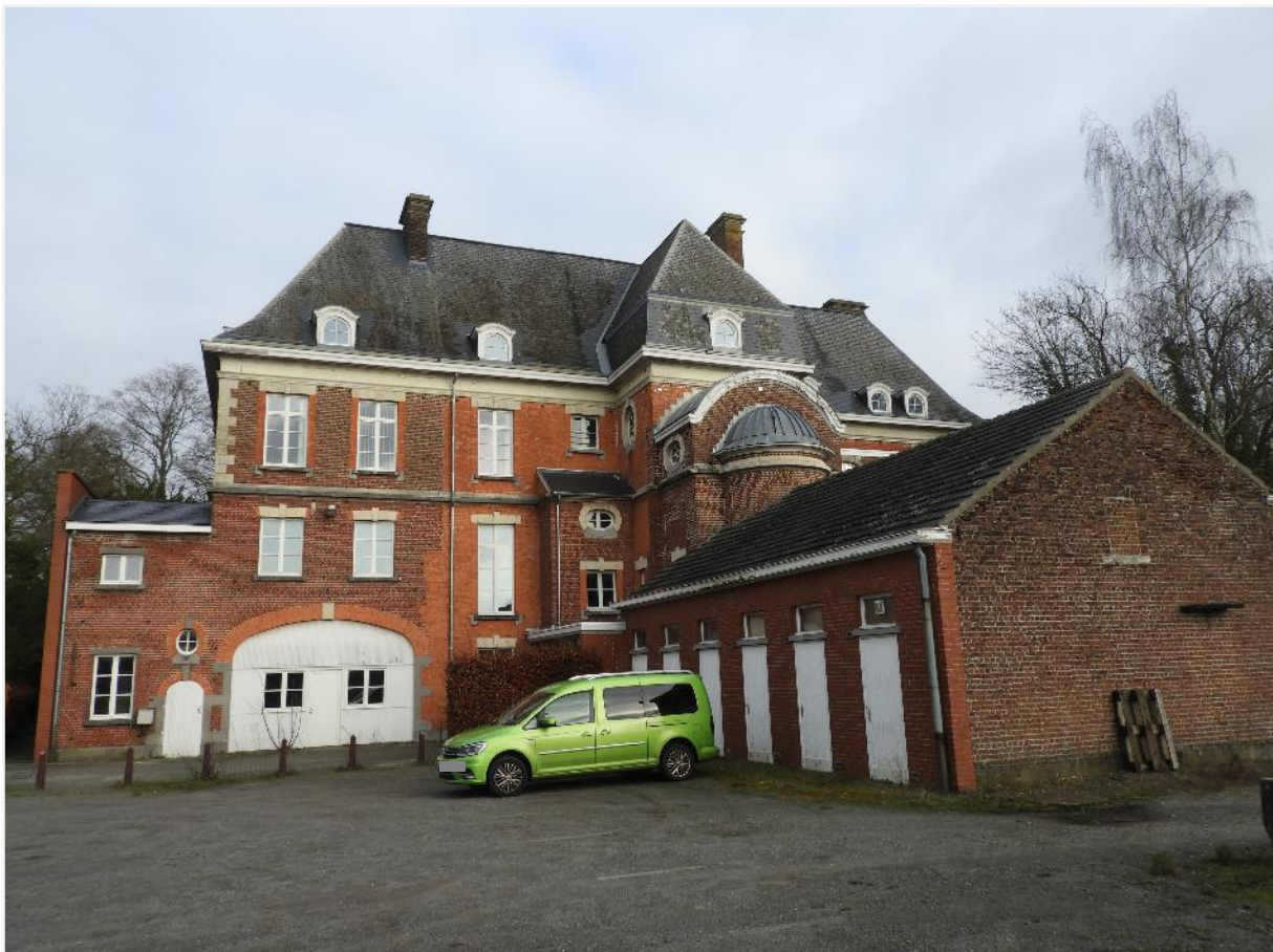
Foto 20: Westelijke achtergevel. Vooraan haaks geplaatste voormalige remise. Centrale traptravee met halfronde uitbouw onder halve koepel. Ten noorden ingekort lager volume.
