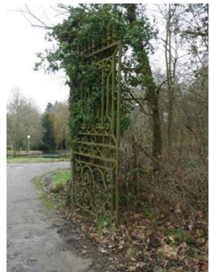
Foto 39: Enige bewaarde poort in de zuidwestelijke hoek. Eén hekpijler met hekken bewaard. Tweede hekpijler ontmanteld.
