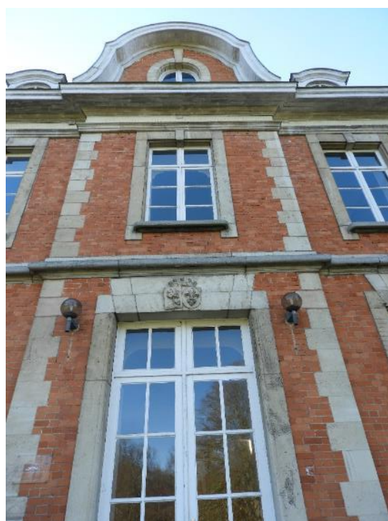
Foto 6: Oostelijke voorgevel. Middentravee.
