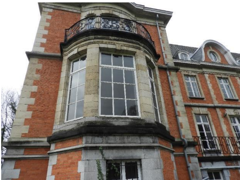
Foto 11: Oostelijke voorgevel. Driezijdige ééntravee-brede zuidoostelijke erker.
