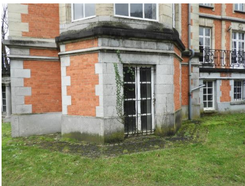
Foto 12: Oostelijke voorgevel. Driezijdige ééntravee-brede zuidoostelijke erker.
