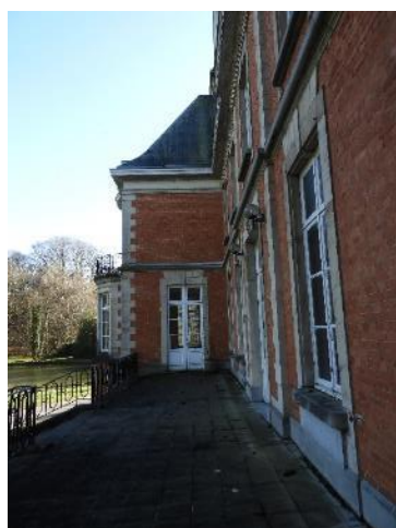
Foto 7: Oostelijke voorgevel. Terras.
