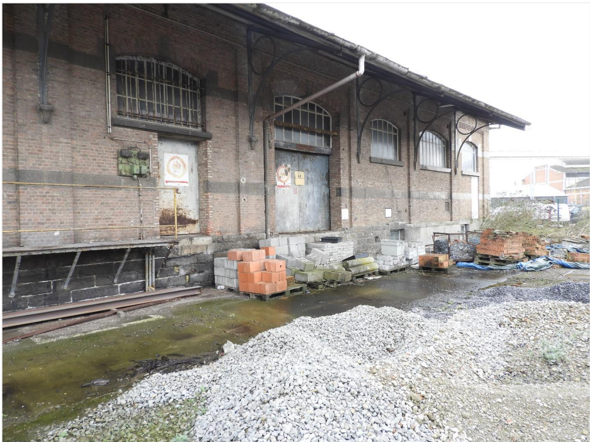
Foto 15: Fuelloods Centrale Werkplaats Mechelen. Zicht op noordelijke langsgevel (agentschap Onroerend Erfgoed 16 februari 2022)
