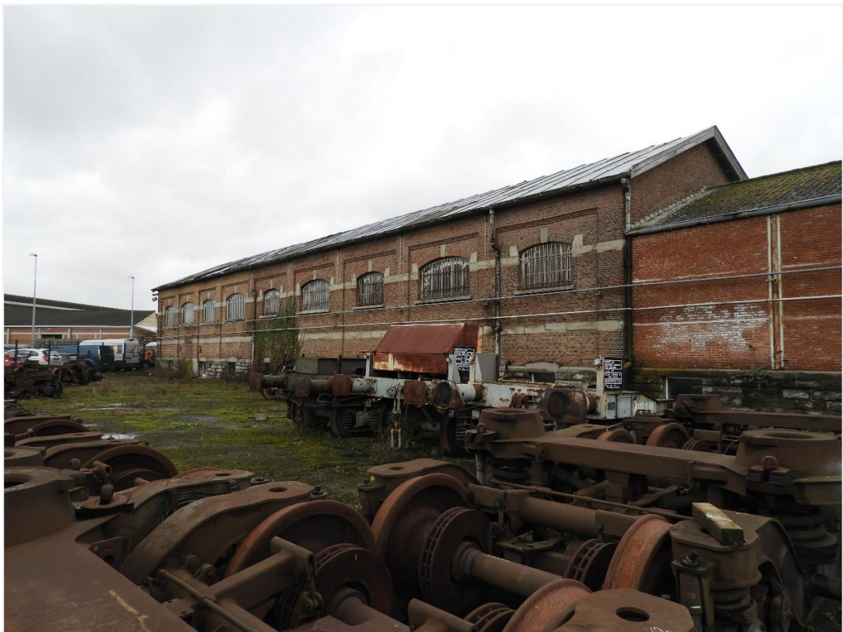
Foto 3: Fuelloods Centrale Werkplaats Mechelen. Zicht zuidelijke langsgevel vanuit het zuidoosten (agentschap Onroerend Erfgoed 16 februari 2022)
