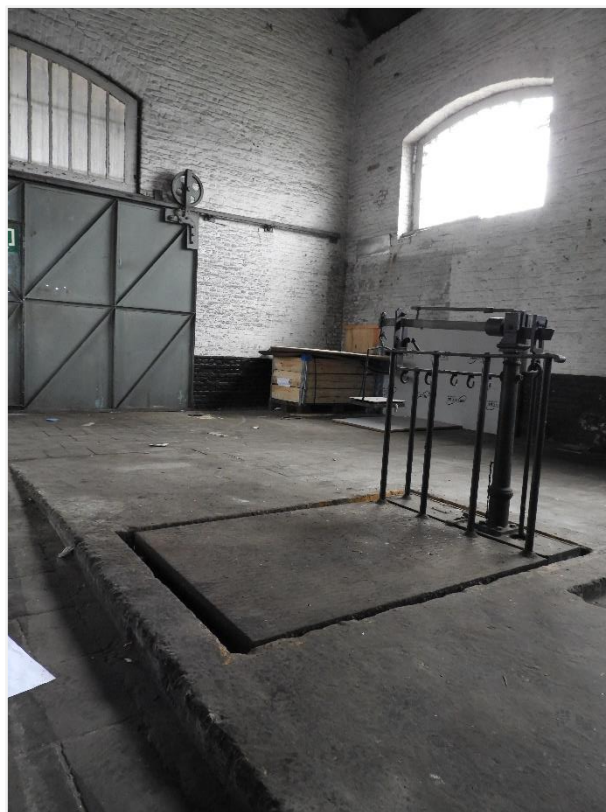
Foto 22: Fuelloods Centrale Werkplaats Mechelen. Detail poort oostelijke kopgevel (agentschap Onroerend Erfgoed 16 februari 2022)
