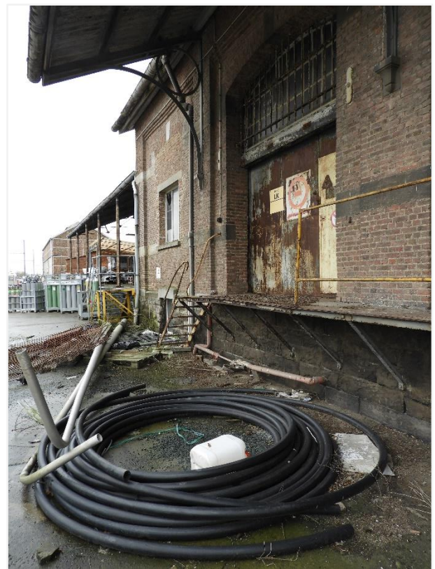
Foto 14: Fuelloods Centrale Werkplaats Mechelen. Detail noordelijke langsgevel (agentschap Onroerend Erfgoed 16 februari 2022)
