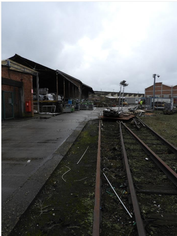
Foto 16: Fuelloods Centrale Werkplaats Mechelen. Zicht op fuelloods vanuit het oosten met oostelijke spoorafkapping (agentschap Onroerend Erfgoed 16 februari 2022)
