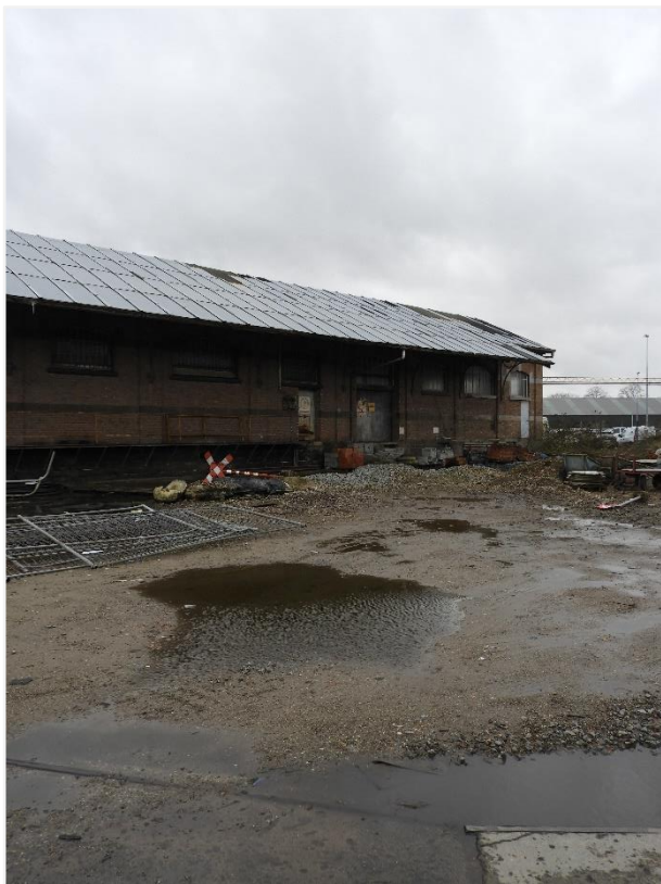
Foto 13: Fuelloods Centrale Werkplaats Mechelen. Zicht op noordelijke langsgevel vanuit het noordoosten (agentschap Onroerend Erfgoed 16 februari 2022)
