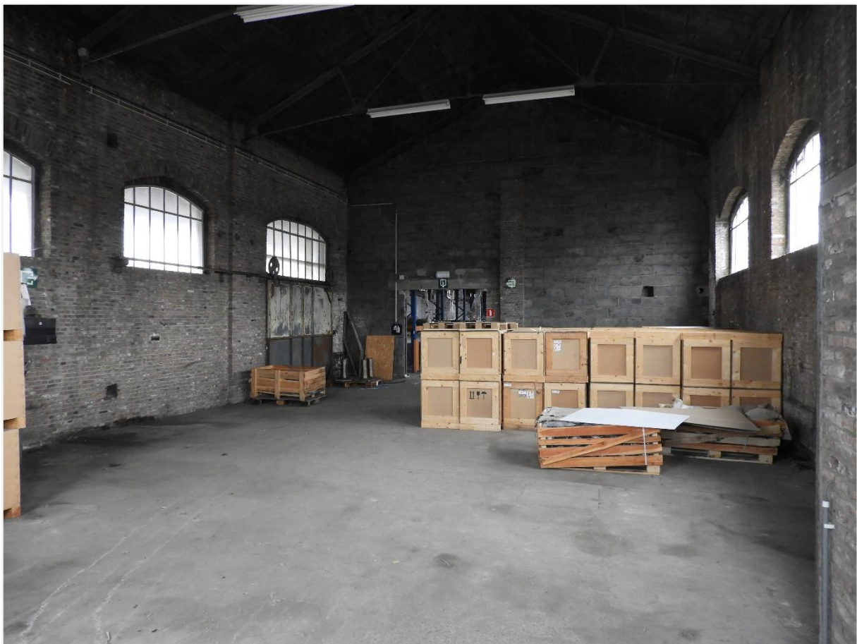
Foto 25: Fuelloods Centrale Werkplaats Mechelen. Overzicht opslagruimte gelijkvloerse verdieping deel west (agentschap Onroerend Erfgoed 16 februari 2022)
