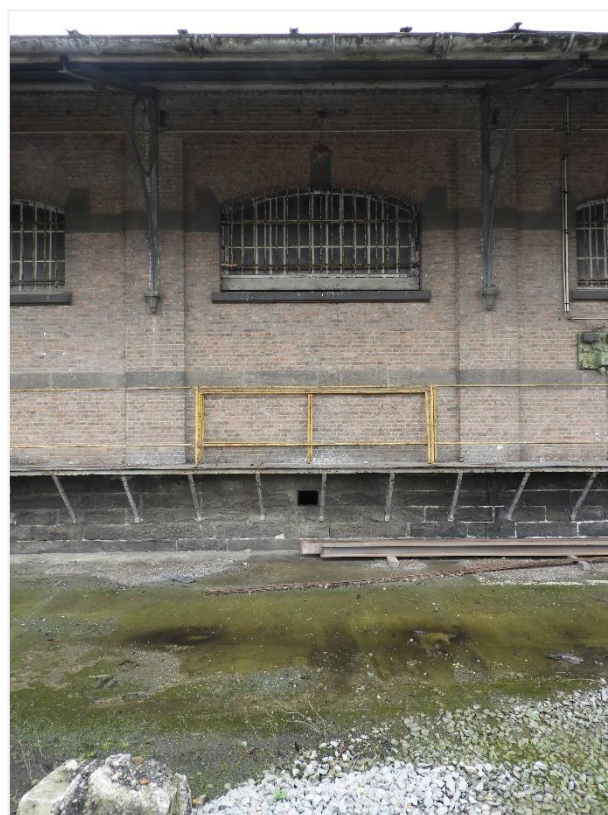
Foto 12: Fuelloods Centrale Werkplaats Mechelen. Detail travee noordelijke langsgevel met getraliede getoogde vensteropeningen (agentschap Onroerend Erfgoed 16 februari 2022)
