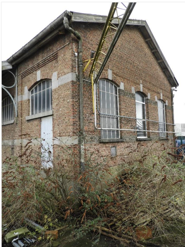
Foto 7: Fuelloods Centrale Werkplaats Mechelen. Zicht op westelijke kopgevel (agentschap Onroerend Erfgoed 16 februari 2022)
