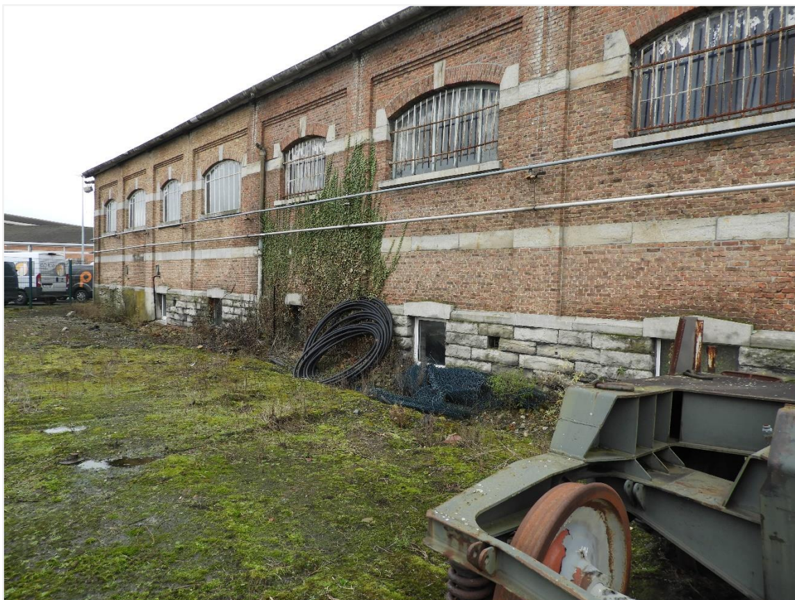
Foto 4: Fuelloods Centrale Werkplaats Mechelen. Zicht zuidelijke langsgevel vanuit het zuidoosten (agentschap Onroerend Erfgoed 16 februari 2022)
