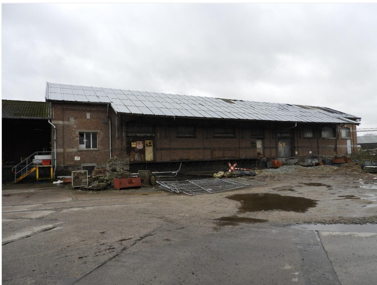
Foto 10: Fuelloods Centrale Werkplaats Mechelen. Zicht op noordelijke langsgevel (agentschap Onroerend Erfgoed 16 februari 2022)
