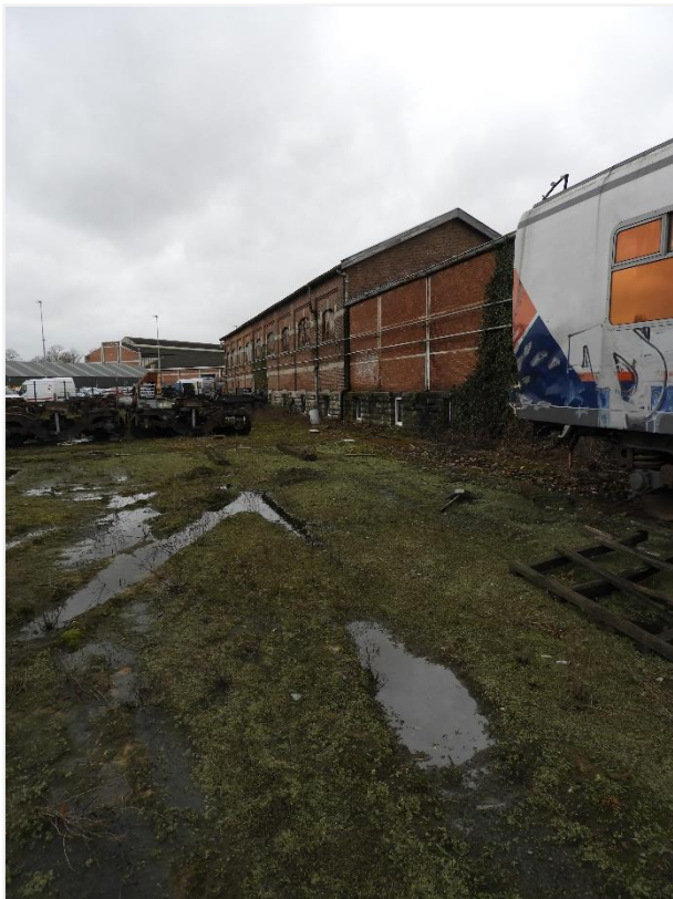
Foto 1: Fuelloods Centrale Werkplaats Mechelen. Zicht zuidelijke langsgevel vanuit het zuidoosten (agentschap Onroerend Erfgoed 16 februari 2022)
