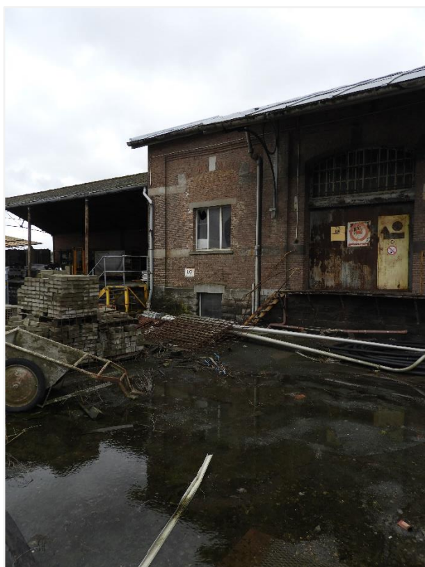
Foto 11: Fuelloods Centrale Werkplaats Mechelen. Detail noordelijke langsgevel (agentschap Onroerend Erfgoed 16 februari 2022)
