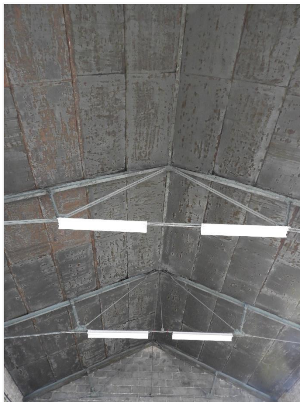
Foto 24: Fuelloods Centrale Werkplaats Mechelen. Detail polonceau-spanten zadeldak opslagruimte deel west (agentschap Onroerend Erfgoed 16 februari 2022)
