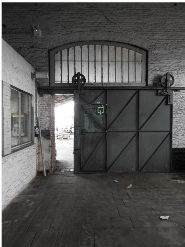
Foto 21: Fuelloods Centrale Werkplaats Mechelen. Detail poort oostelijke kopgevel (agentschap Onroerend Erfgoed 16 februari 2022)
