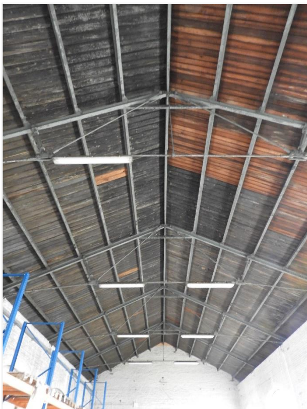
Foto 23: Fuelloods Centrale Werkplaats Mechelen. Detail polonceau-spanten en houten bebording zadeldak opslagruimte deel oost (agentschap Onroerend Erfgoed 16 februari 2022)
