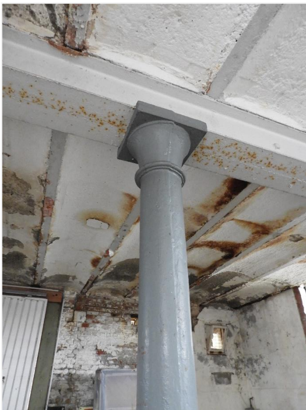
Foto 30: Fuelloods Centrale Werkplaats Mechelen. Detail kapiteel gietijzeren zuil opslagruimte kelder (agentschap Onroerend Erfgoed 16 februari 2022)
