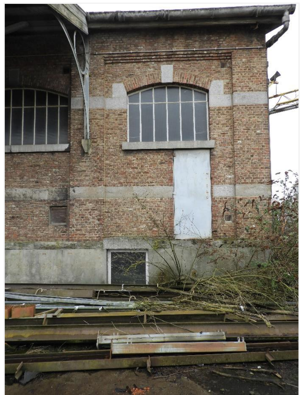
Foto 8: Fuelloods Centrale Werkplaats Mechelen. Detail travee noordelijke langsgevel (agentschap Onroerend Erfgoed 16 februari 2022)
