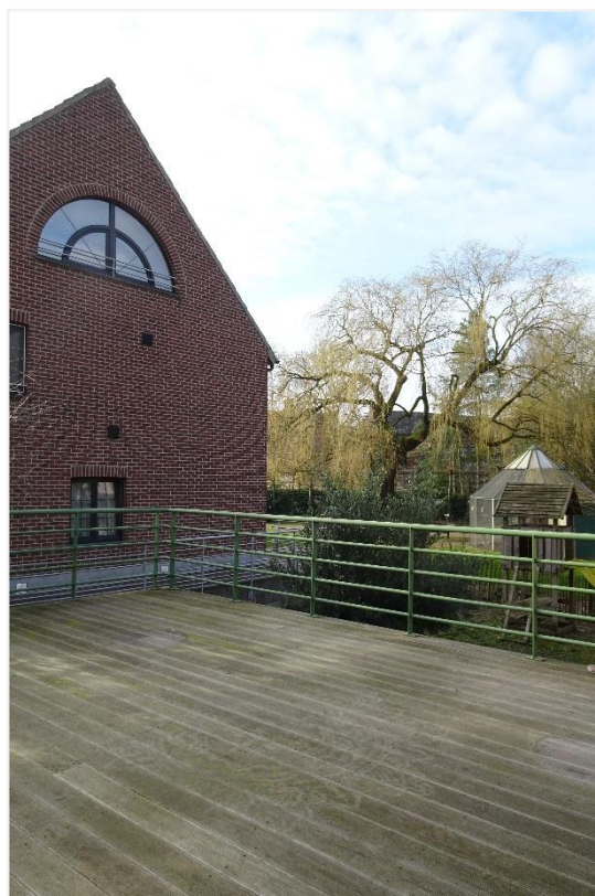
Foto 2: Noordgevel van de bedrijfsgebouwen van de brouwerij nabij de vroegere plantlocatie van de zwarte walnoot vanaf de noordoostzijde.
