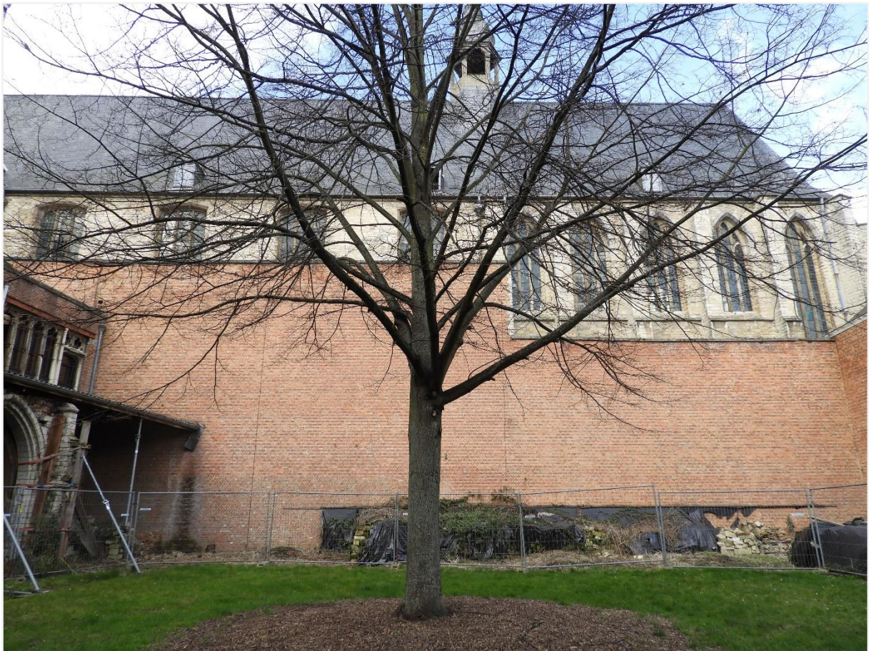
Foto 3: Zicht op de locatie van de noordgalerij van de Sint-Geertruiabdij. Vandaag is tegenaan de zijbeuk van de Sint-Geertruikerkerk een recente bakstenen muur gebouwd.
