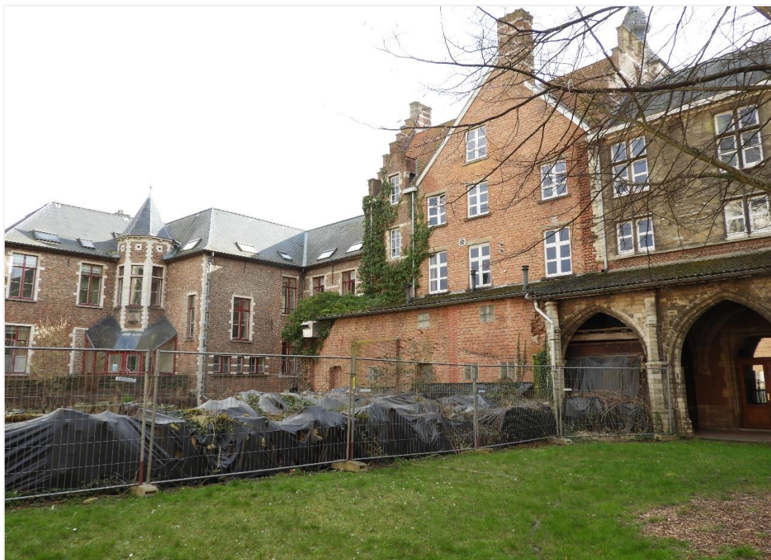
Foto 8: Zicht op de locatie van de verdwenen oostgalerij (dranghekkens) van de abdij. Rechts aansluiting met de zuidgalerij (blijft beschermd als monument). Aan de andere kant van de Dijle het abstkwartier (blijft beschermd als monument).
