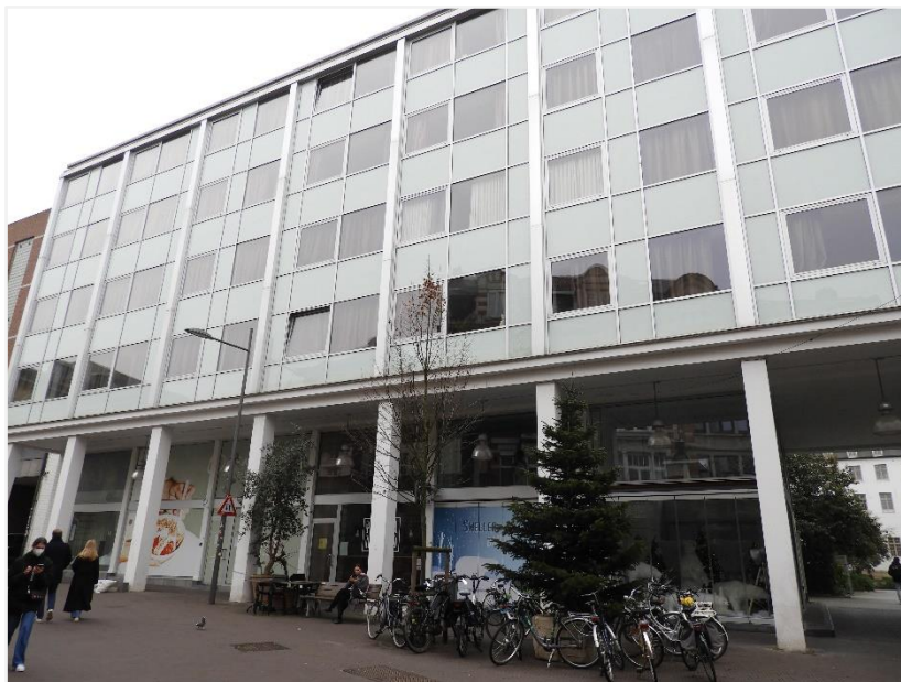
Foto 2: Op de locatie van de bescherming van 1942 is een recent gebouw opgetrokken. Van de poort en de omheiningmuur zijn op deze plaats geen spoor meer.
