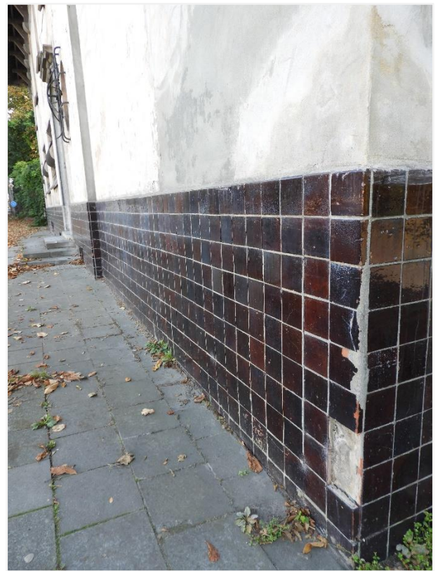
Foto 8: Villa Limpens, detail gevel Brusselsesteenweg plint met tegels.
