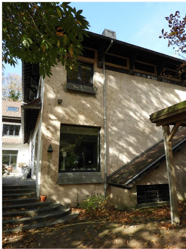
Foto 16: Villa Limpens, oostgevel.
