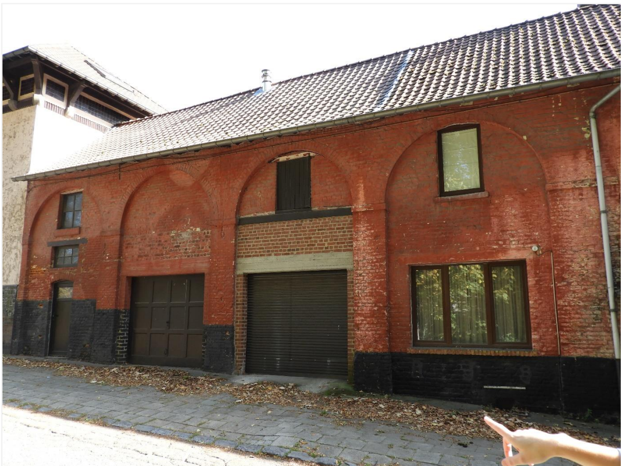
Foto 19: Koetshuis, westgevel aan de Brabandtlaan.
