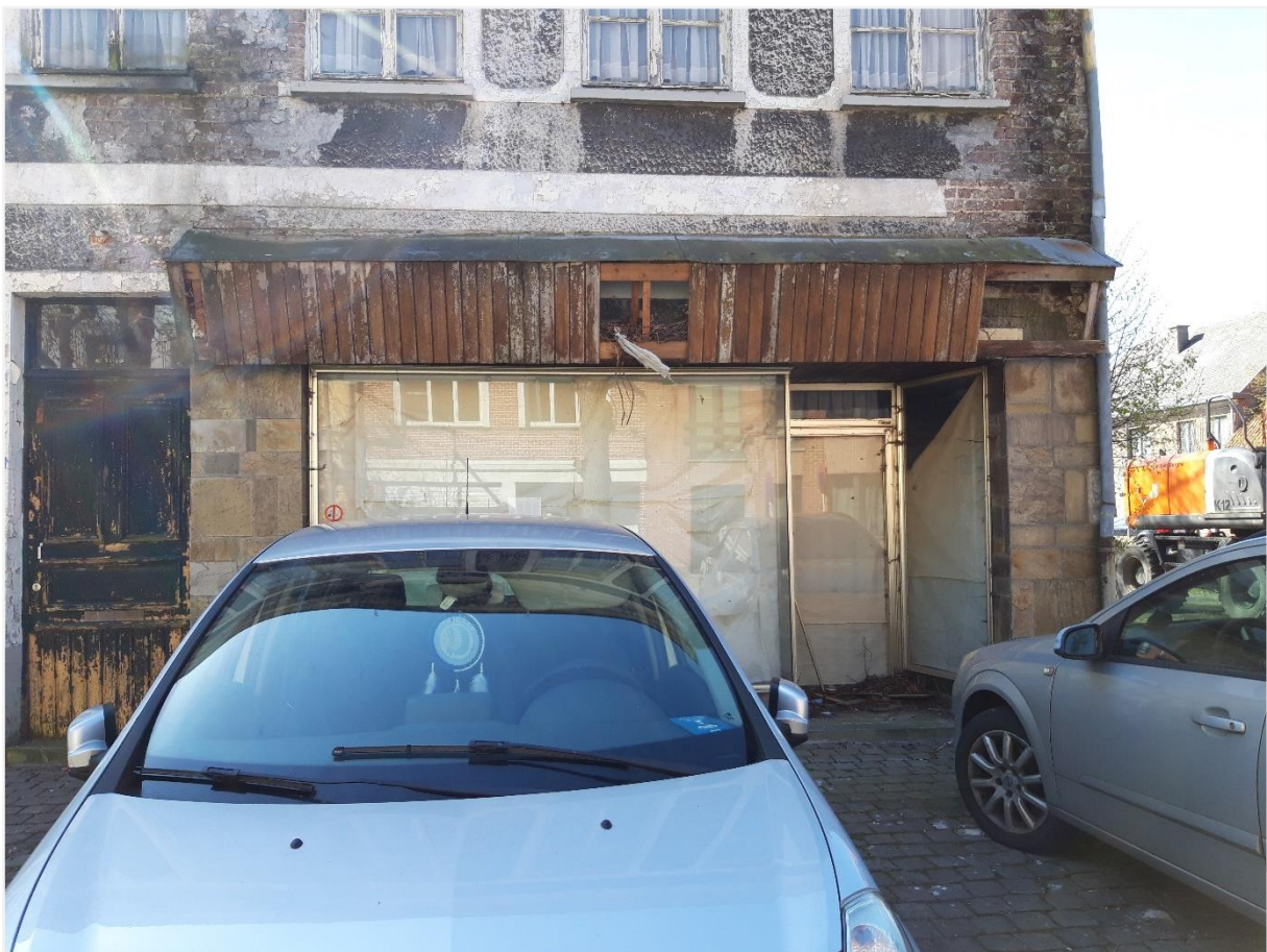
Foto 4: Detail benedenverdieping rechts winkelpui
