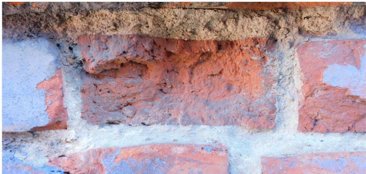
Foto 13: Detail beschadigingen bakstenen parement en verflaag Reclamemuurschildering Cigarettes Marouf Prinses Clementinalaan 205-213 (Monumentenwacht Vlaanderen 23 april 2021)
