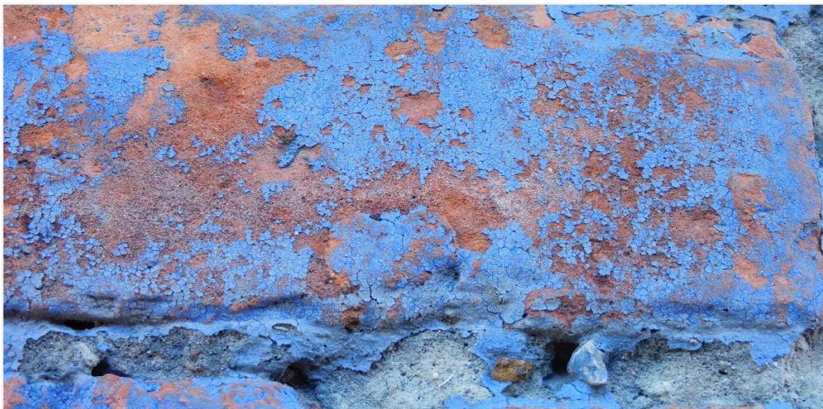
Foto 12: Detail verpulverde verflaag Reclamemuurschildering Cigarettes Marouf Prinses Clementinalaan 205-213 (Monumentenwacht Vlaanderen 23 april 2021)
