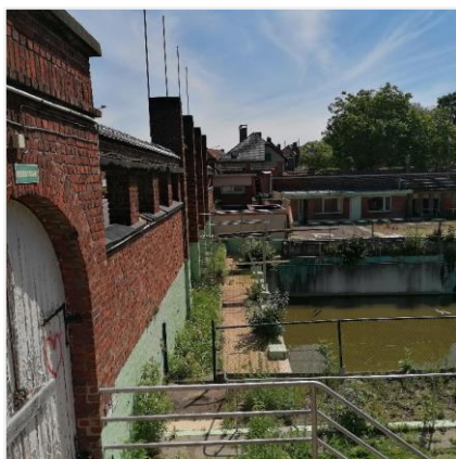
Foto 55: Noordelijke afsluitingsmuur openluchtwembad Ieper (Stad Ieper 8 juni 2021).
