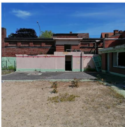
Foto 56: Noordelijke afsluitingsmuur openluchtwembad Ieper (Stad Ieper 8 juni 2021).
