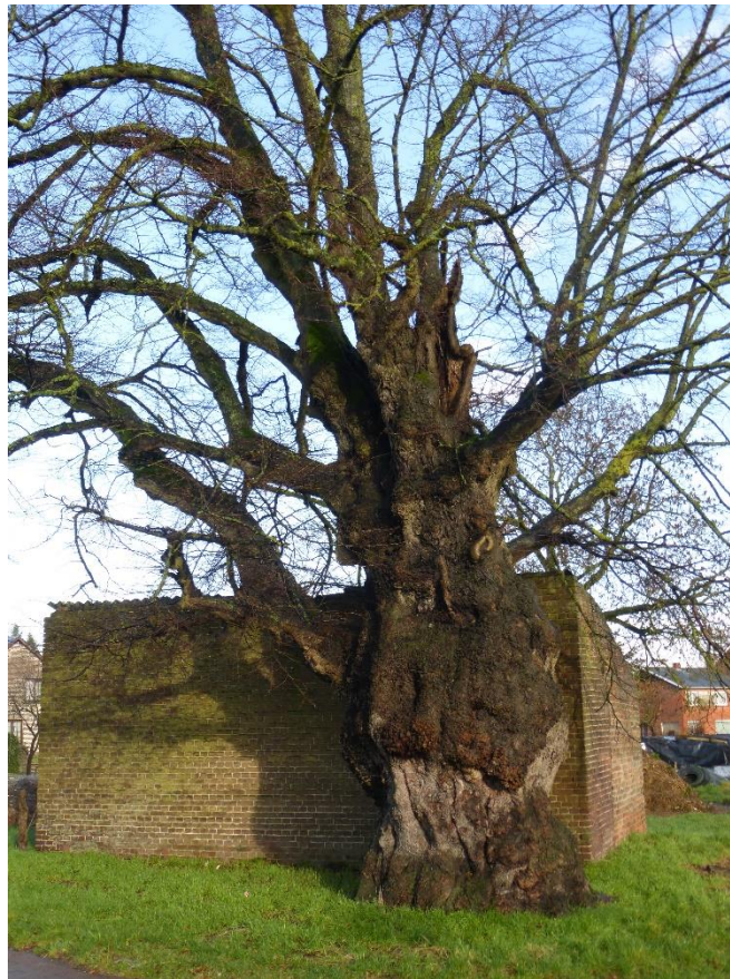
Foto 3: Gekandelaarde winterlinde met detail van de stam en gesteltakken (1 februari 2018).
