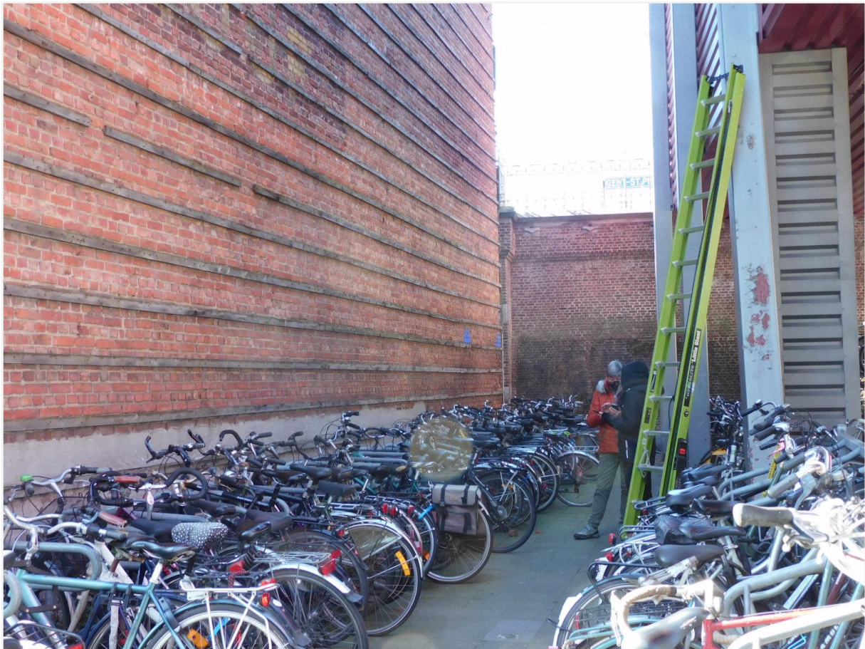
Foto 5: Zicht op wachtgevel en fietsstalling bij Infopunt Project Gent-Sint-Pieters Prinses Clementinalaan (Monumentenwacht Vlaanderen 24 april 2021)
