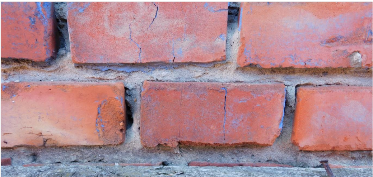
Foto 14: Detail uitgespoeld voegwerk en volledig verpulverd en verdwenen verflaag Reclamemuurschildering Cigarettes Marouf Prinses Clementinalaan 205-213 (Monumentenwacht Vlaanderen 23 april 2021)
