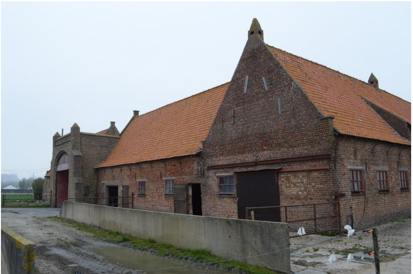
Foto 14. De zuidwestzijde van de westvleugel, ten zuiden van de toegangspoort. Westvleugel vormt samen met de zuidvleugel een L-vormig stalvolume. Zuidwesthoek: tuitgevel met aandaken (12.04.2018).
