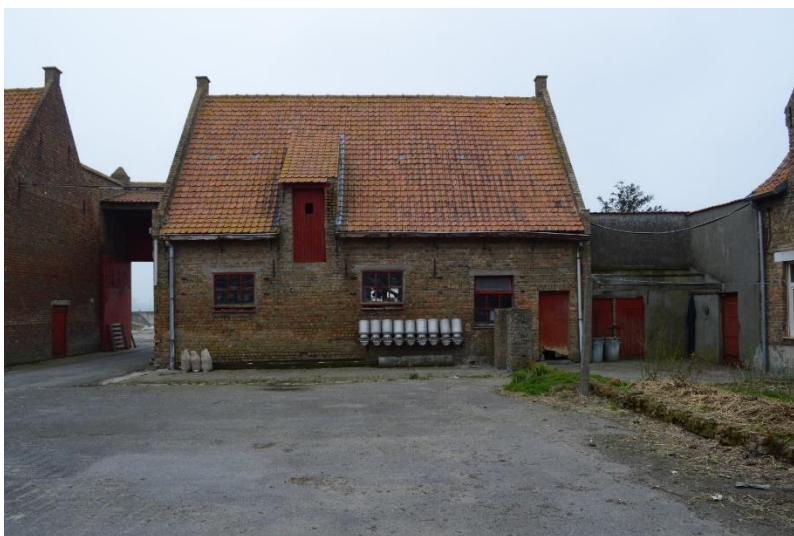
Foto's 17. Stal ten noorden van de toegangspoort. Bewaarde bakgoot op in de muur verankerde ijzeren haken. Klimmende dakkapel met laadvensters. Hekpijlers met deels bewaard muurtje voor het huis (12.04.2018).
