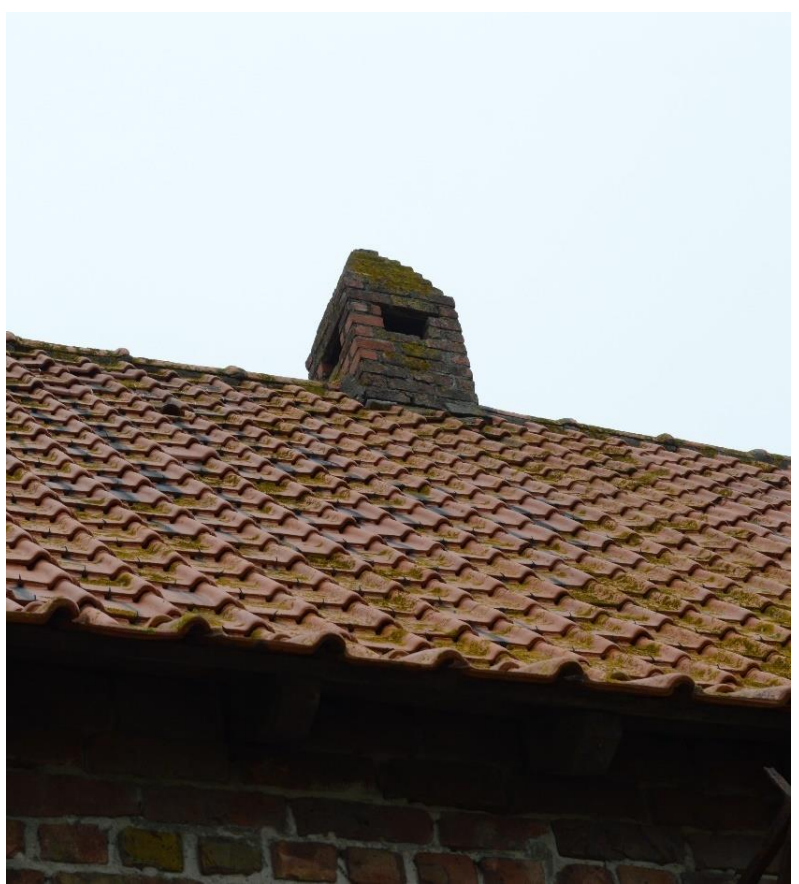
Foto's 23. Verluchtingsschoorsteen op de zuidwestelijke zijgevel van de L-vormige stalvleugel. De gevel is recent verankerd, en onderaan en aan de top hervoege - Verluchtingsschoorsteen op de nok van het zadeldak (12.04.2018).
