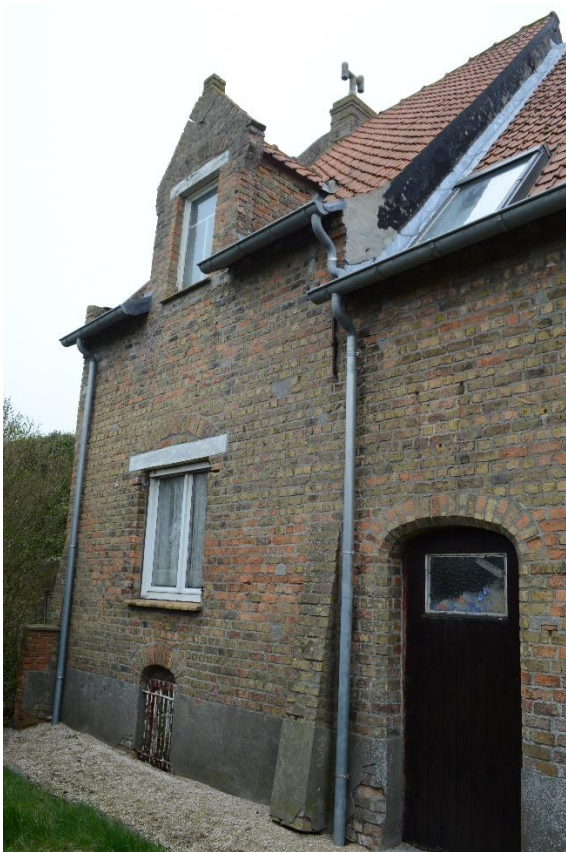
Foto 29. Boerenwoning. Noordgevel links: korfboogvormige deuropening met links de opkamer met korfboogvormig kelderraam, opkamervenster en dakvenster met tuitgevel en schouderstukken (12.04.2018).
