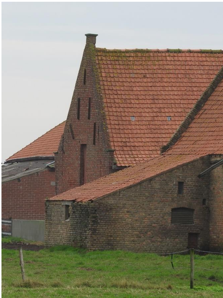
Foto 24. De zuidoostelijke zijtuitgevel (met muurvlechtingen, aandaken en schouderstukken) van de zuidelijke stalvleugel (29.08.2018).
