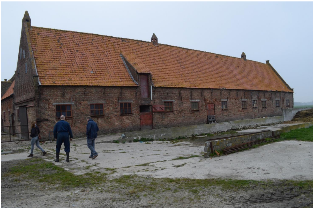
Foto 21. Zicht op de zuidzijde van de zuidvleugel. Tuitgevels met aandaken en drie verluchtingsschoorstenen. Lang volume van 13 traveeën. Laadvenster ter hoogte van tiende travee verdwenen (12.04.2018).
