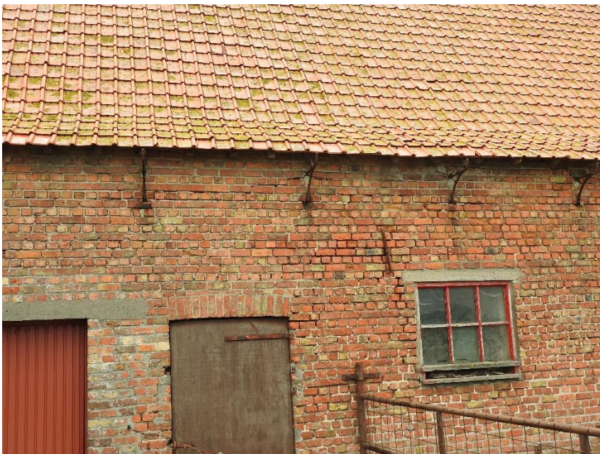
Foto's 15. De zuidwestzijde van de westvleugel, ten zuiden van de toegangspoort. Nog bewaarde bakgootijzers, verankerd in het metselwerk (29.08.2018).
