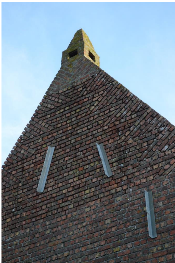
Foto's 23. Verluchtingsschoorsteen op de zuidwestelijke zijgevel van de L-vormige stalvleugel. De gevel is recent verankerd, en onderaan en aan de top hervoege - Verluchtingsschoorsteen op de nok van het zadeldak (12.04.2018).
