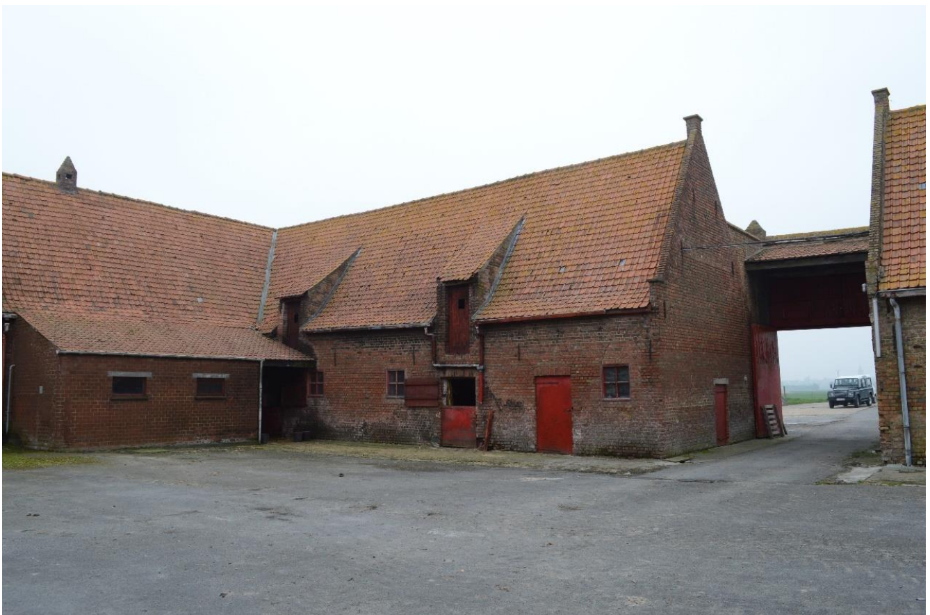
Foto 19. Stal ten zuiden van de toegangspoort, inhakend in de zuidelijke stalvleugel. De oorspronkelijke goot is er vervangen door een hanggoot. Ook de ijzeren haken zijn verwijderd. De recentere aanbouw onder lessenaarsdak heeft geen erfgoedwaarde (12.04.2018).
