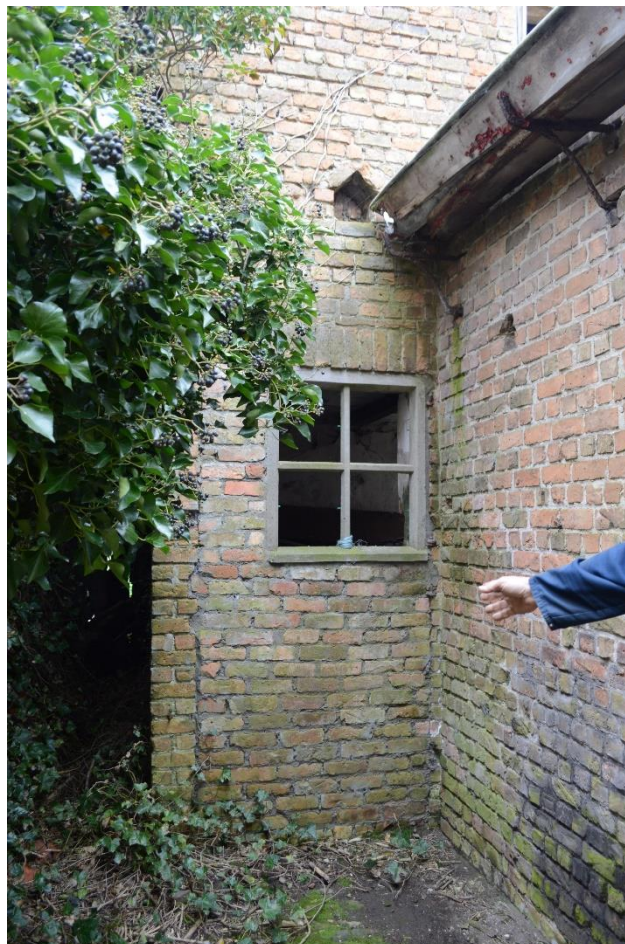
Foto 37. Zijgevel van de stierenstal met betonnen venstertje onder strek (ofschoon op wederopbouwplan geen venster voorzien). Erboven mijterboognisje (12.04.2018).
