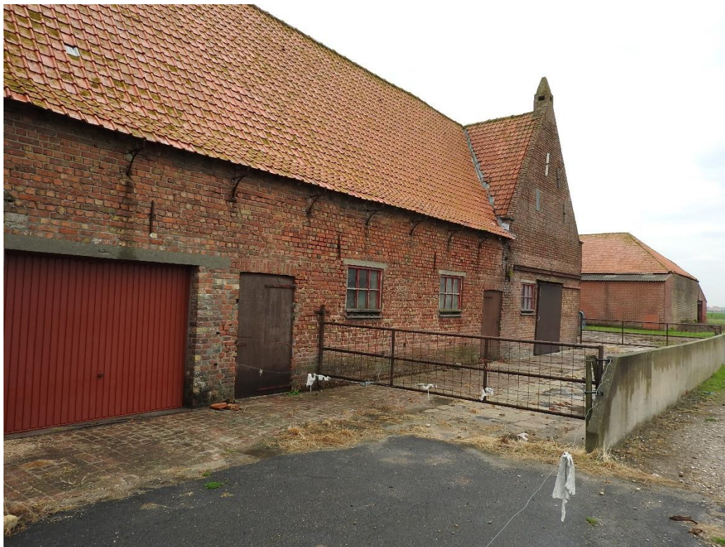
Foto 13. De zuidwestzijde van de westvleugel, ten zuiden van de toegangspoort. Aangepaste westgevel door integratie van garagepoort. Zuidwesthoek: tuitgevel met aandaken (29.08.2018).
