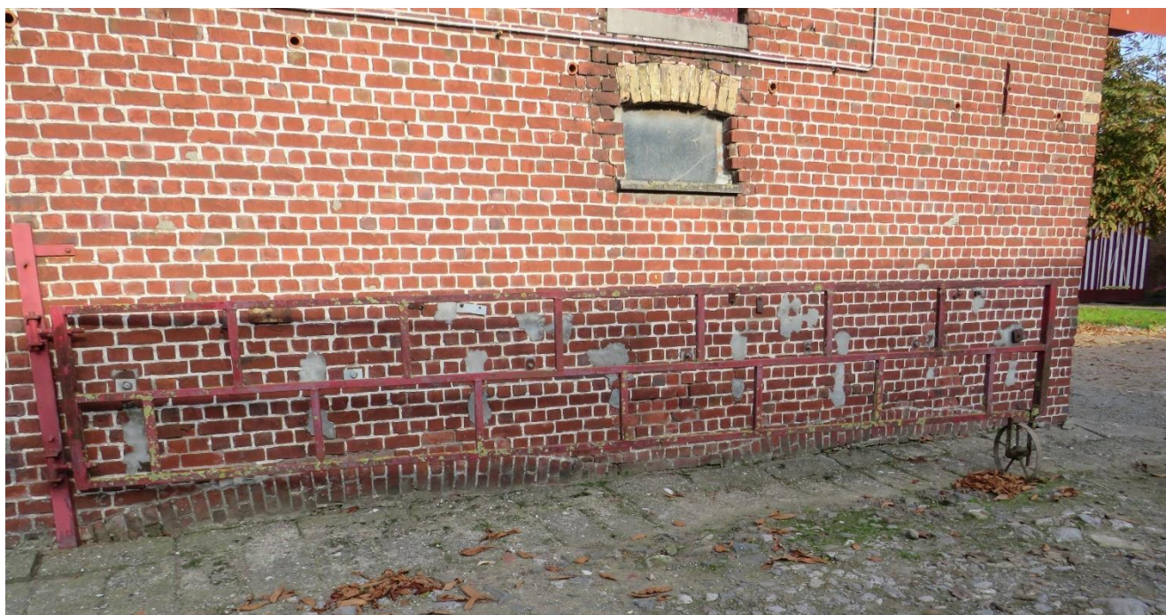
Foto 35: de linker of westelijke zijgevel van de stalvleugel is één of twee decennia jonger – tegen het maaiveld, twee getoogde bogen onder strek (31.10.2019).
