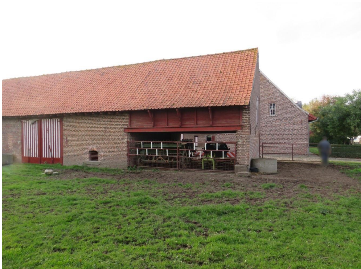
Foto 53: meer gesloten achtergevel van de schuur – tussen de schuurpoort en het wagenhuis, getoogd keldervenstertje (31.10.2019).
