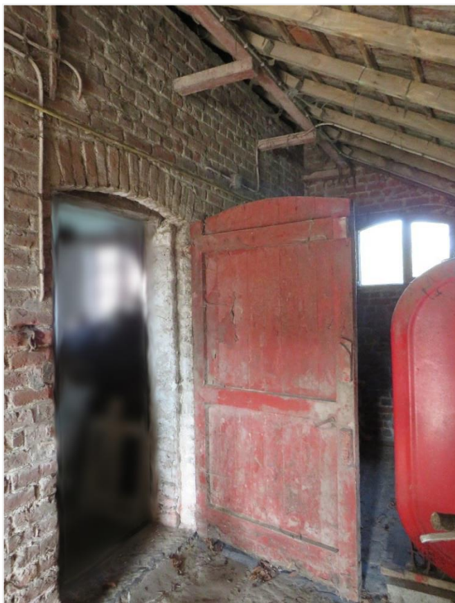
Foto 40: overdekte gang tussen de stalvleugel en de boerenwoning – deur naar bakhuis met opgeklampt houten kader en houten beplanking (31.10.2019).
