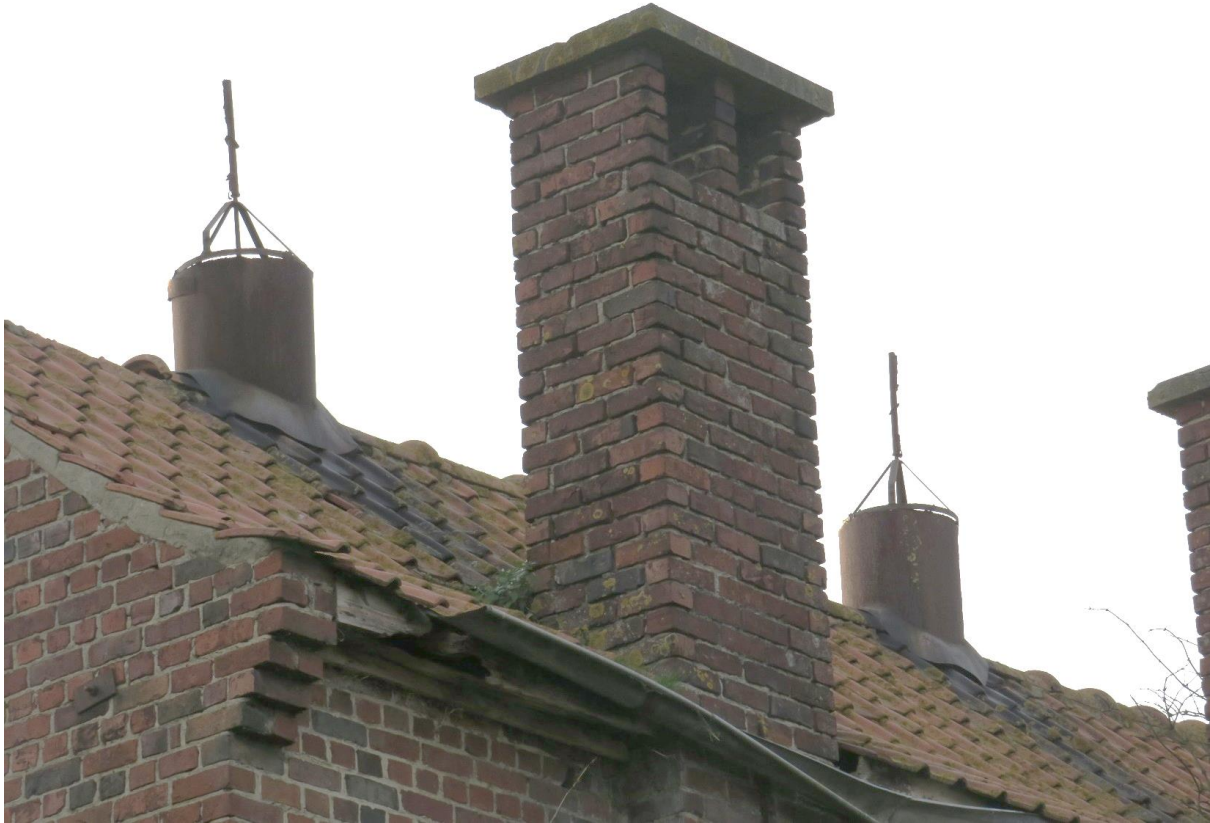
Foto 60: de nok van de hoger opgetrokken tabaksast is voorzien van twee ronde, metalen windschouwen met een vaste eestmuts – bovenkant van één van de uitkragende bakstenen rookkanalen – de bovenkant is tweeledig uitgewerkt en afgedekt met similstenen plaat – geknikte dakoverstek en getrapt bakstenen schouderstuk (31.10.2019).
