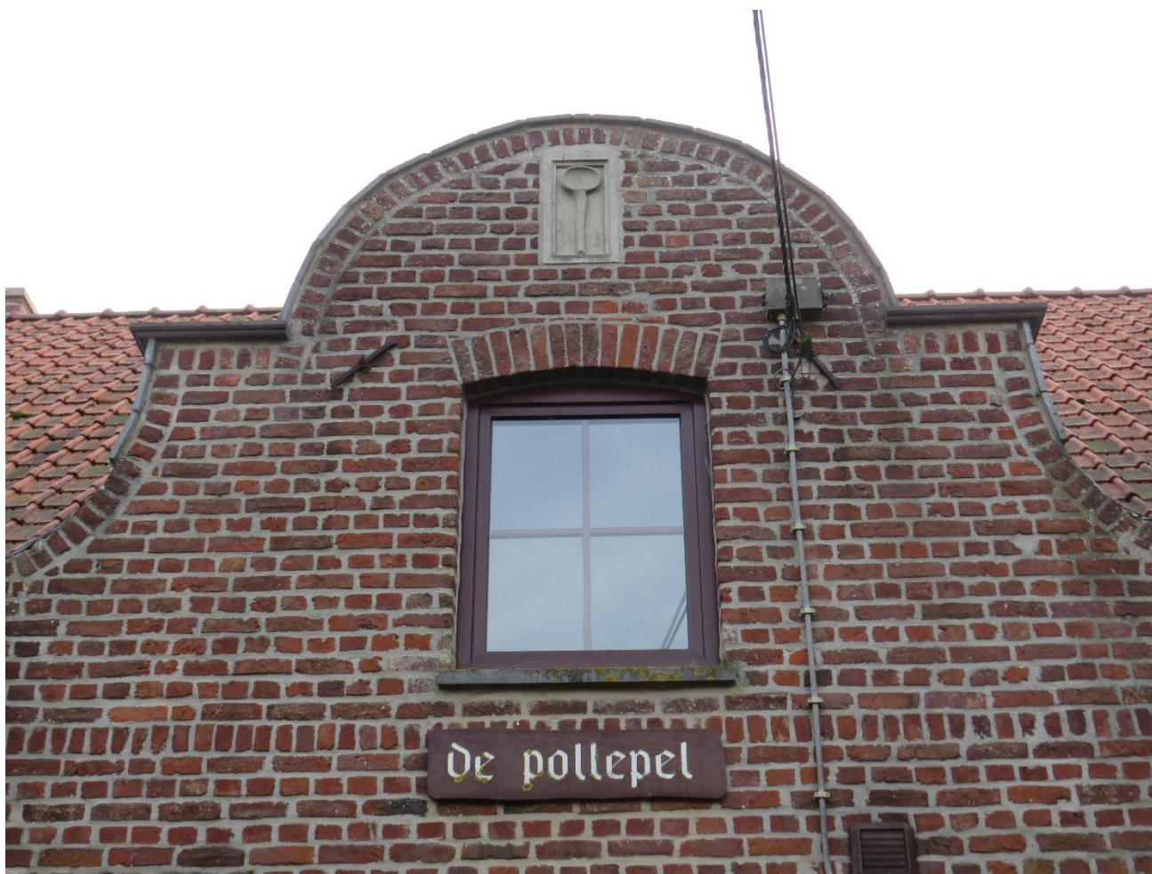
Foto 27: voorgevel van de boerenwoning met breed dakvenster met klokgevel – in de top, gebeeldhouwd bas-reliëf van rechtopstaande pollepel (31.10.2019).
