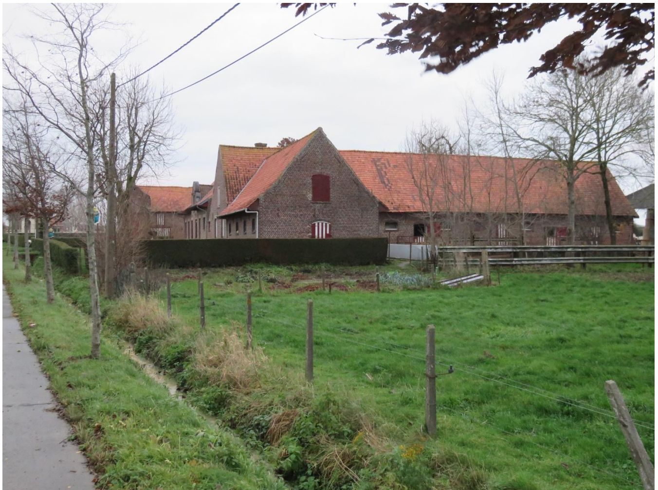
Foto 3: algemeen beeld op de hoeve vanaf de Komenseweg, vanuit het noorden - rechts de L-vormige stalvleugel – in de verte, zicht op de hogere daken van de cichorei- en tabaksast (13.12.2019).
