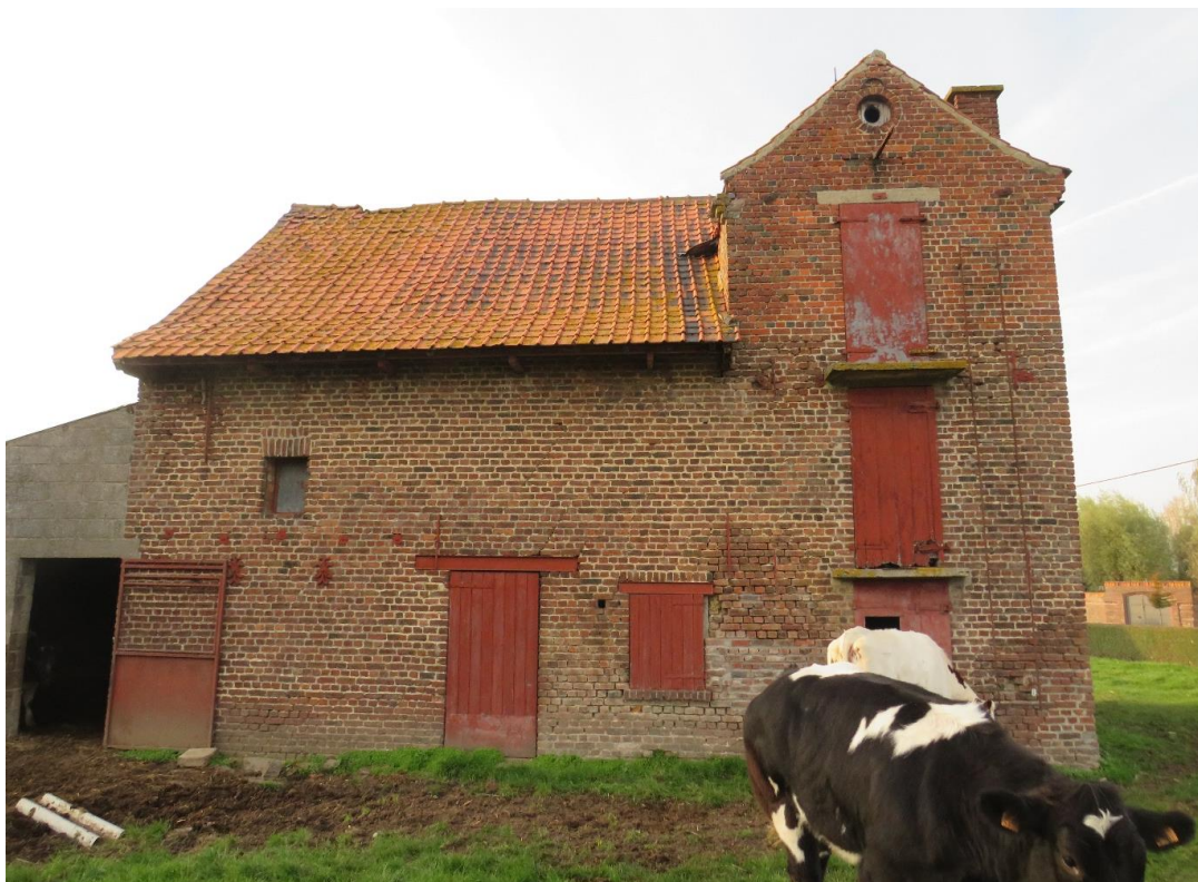
Foto 55: zuidelijke langsgevel van de ast (naar de begraafplaats gericht) - links (ten westen) geven gietijzeren muurankers in stervorm de chicorei-ast aan - rechts (ten oosten) situeert zich de hogere tabaksast (31.10.2019).
