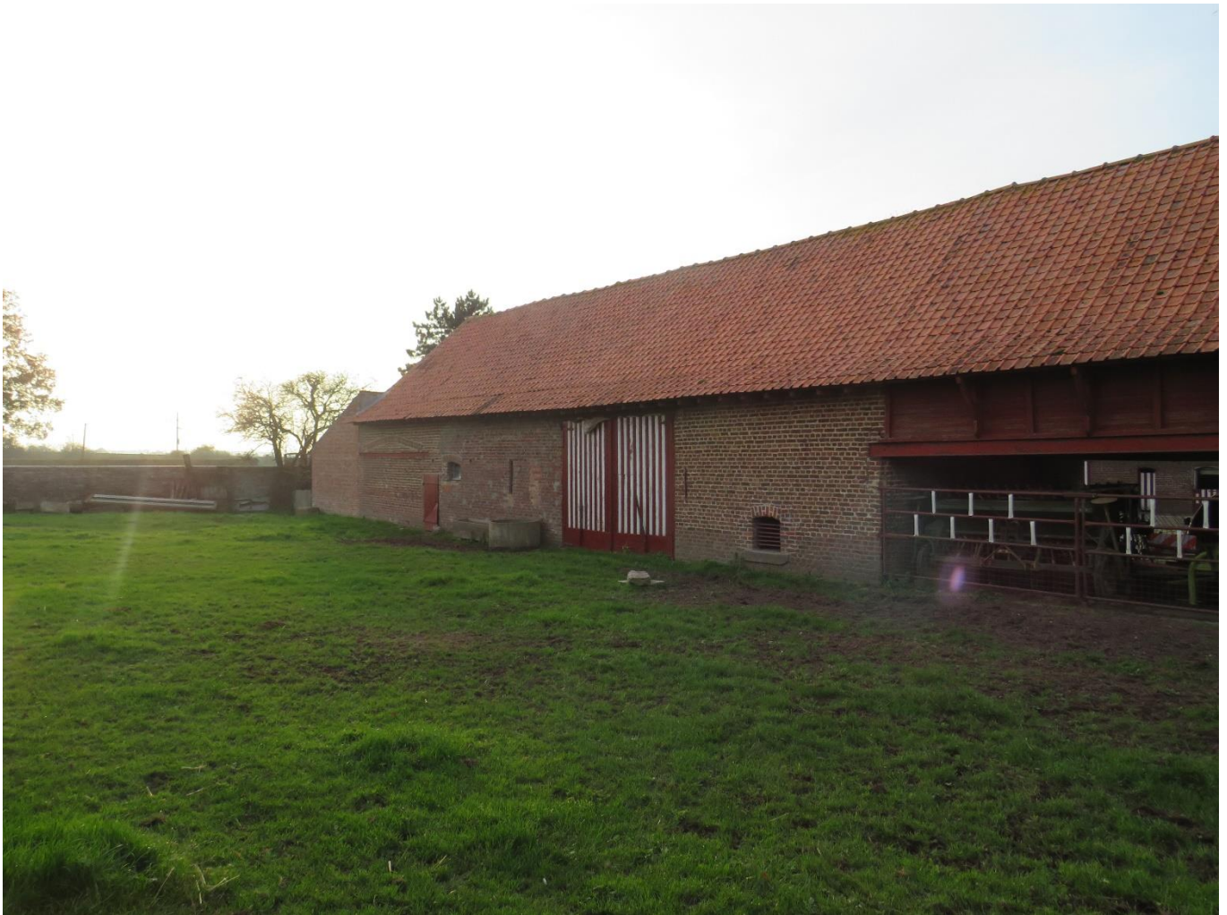
Foto 52: meer gesloten achtergevel – wagenhuis en schuurpoort, getoogd keldervenstertje (31.10.2019).
