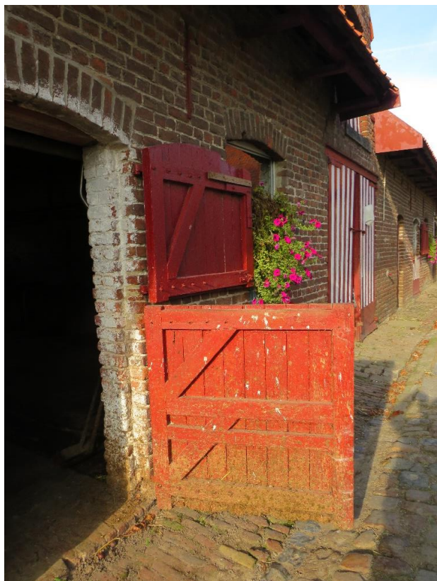
Foto 38: erfgevel van de stalvleugel – tweedelige staldeur van koestal (ten westen van voederkeuken) - opgeklampt houten kader met houten beplanking – bewaard hang- en sluitwerk (31.10.2019).
