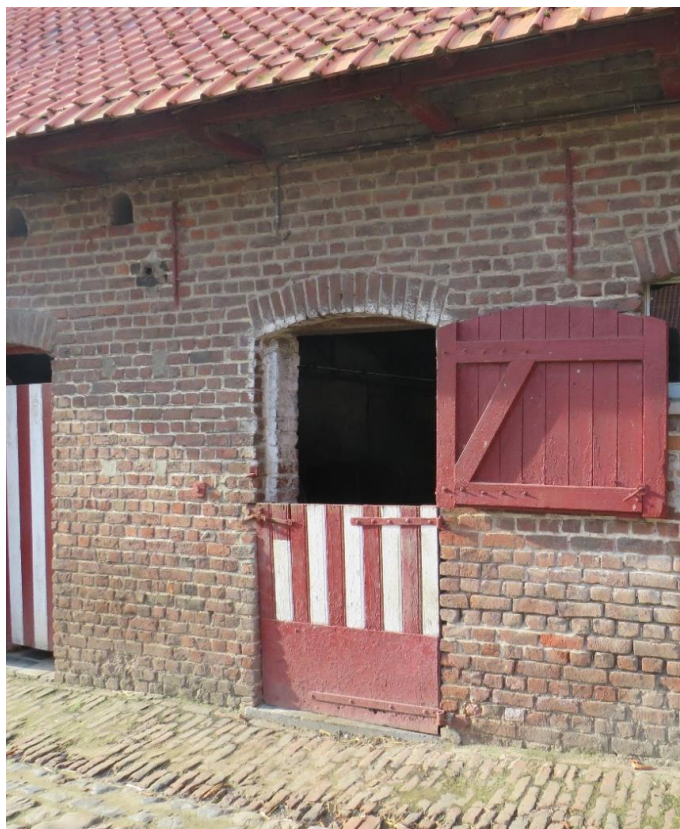
Foto 39: erfgevel van de stalvleugel – tweedelige staldeur van de koestal (ten oosten van voederkeuken) - opgeklampt houten kader met houten beplanking - bewaard hang- en sluitwerk – trottoir van bakstenen op hun kant (31.10.2019).
