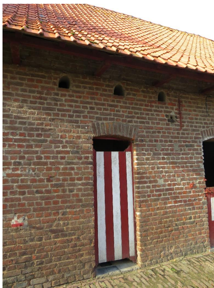
Foto 37: erfgevel van de stalvleugel – deur van het buitentoilet – erboven drie gaten voor duivenhok (31.10.2019).
