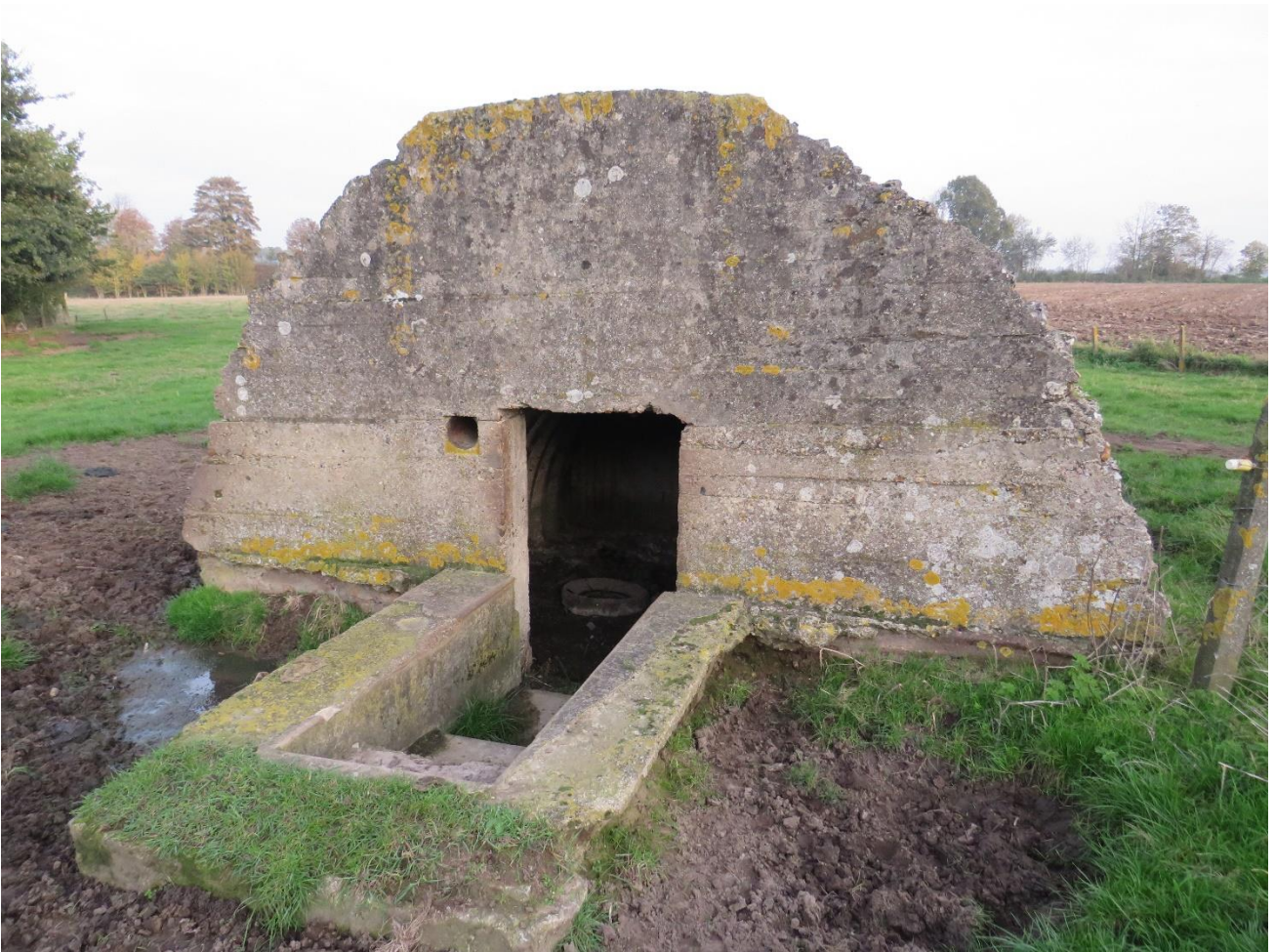
Foto 72: de achtermuur met toegang is naar de straat en de 'Pollepelhoeve' gericht (weg van het front) - betonnen trapjes, omgeven door lage muurtjes, leiden naar de deur (31.10.2019).
