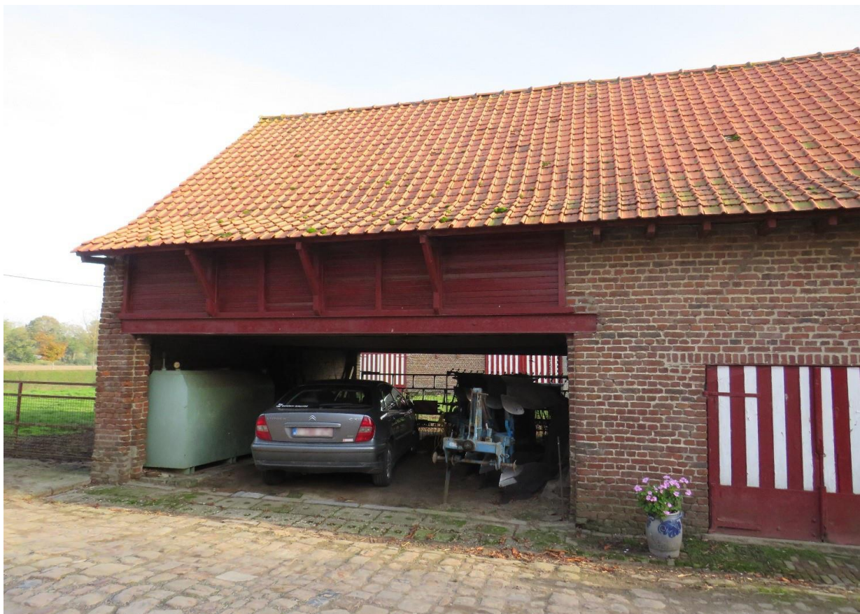
Foto 46: erfgevel van de vleugel – wagenhuis onder metalen I-profiel - daarboven houten vakwerk met plankenbebording en dakoverstek op houten korbelen – kasseien en gerecupereerde natuursteen – abrisstenen voor het wagenhuis (31.10.2019).
