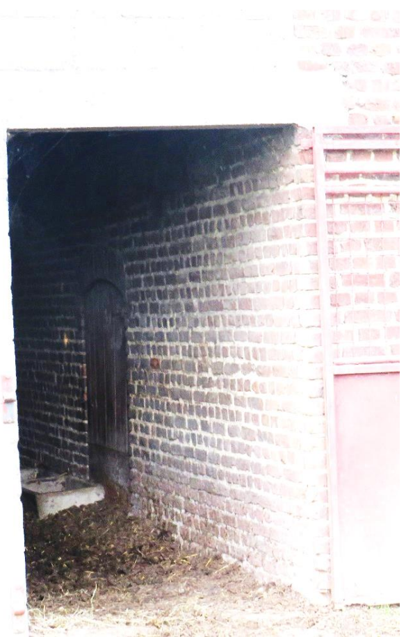
Foto 66: de westelijke zijgevel van de chicorei-ast – later ingebouwde getoogde deur (31.10.2019).
