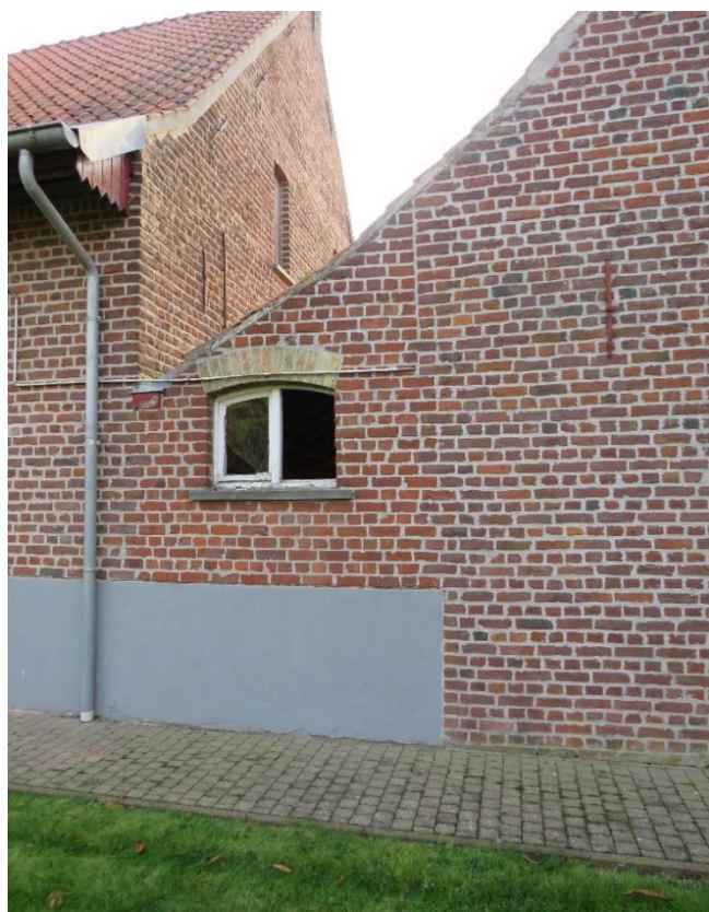
Foto 28: de stalvleugel in de voortuin, in het verlengde van de boerenwoning – overgang tussen huis en stal onder lessenaarsdak, klein getoogd venster (31.10.2019).
