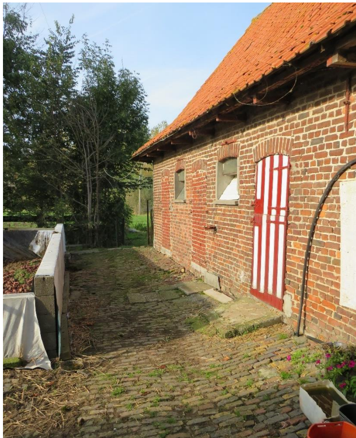
Foto 43: achtergevel van de stalvleugel op L-vormige plattegrond – haakse uitbouw met de varkensstal - trottoir van bakstenen op hun kant (31.10.2019).
