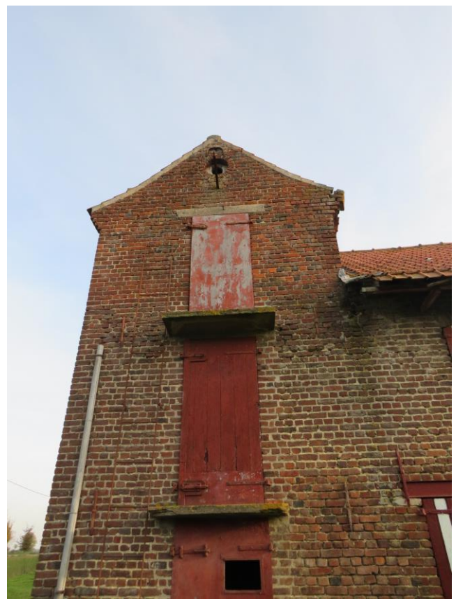
Foto 57: tabaksast - zicht op de noordgevel (naar de schuur gericht) - boven de laaddeur ijzeren staaf, waaraan een katrol hing om de tabaksranken binnen te halen - oculus zijn ingevuld met een houten luikje met kleine cirkelvormige opening – getrapt bakstenen schouderstuk (31.10.2019).
