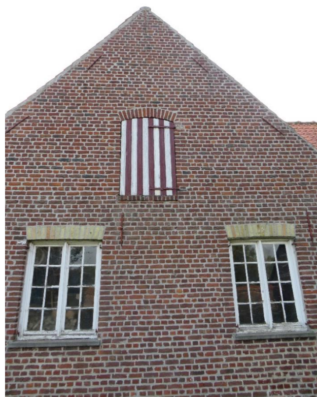
Foto 29: de rechter zijgevel van stalvleugel in de voortuin, in het verlengde van de boerenwoning – twee oorspronkelijke houten ramen met kleine roedeverdeling en het laadluik (kenmerkende rood-witte kleurencombinatie) zijn bewaard (31.10.2019).
