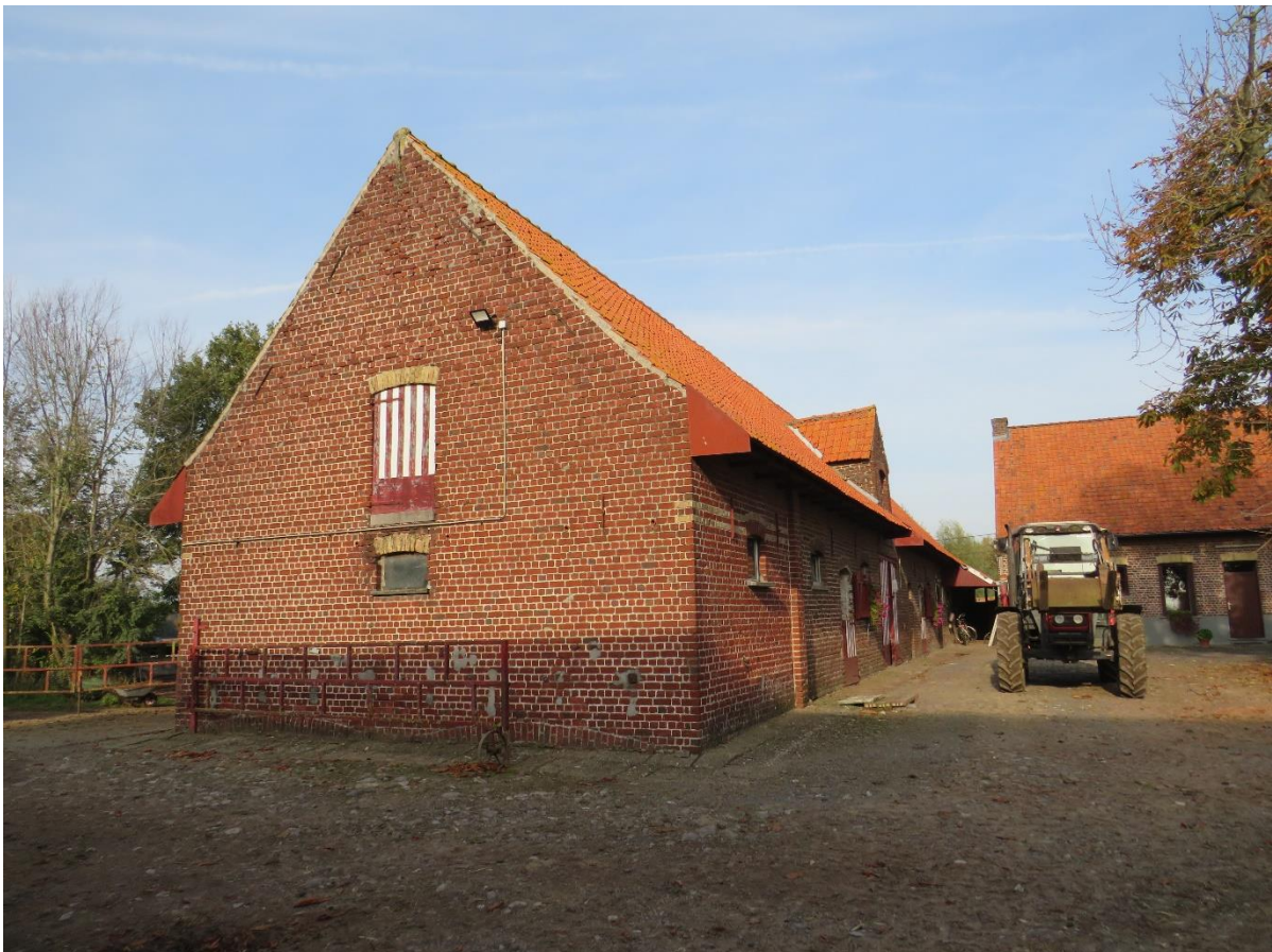
Foto 33: erfgevel en linker zijgevel van de stalvleugel – de linker of westelijke eindtravee is één of twee decennia jonger – stalvenstertje en laadluik onder geelbakstenen strek in de zijgevel (31.10.2019).
