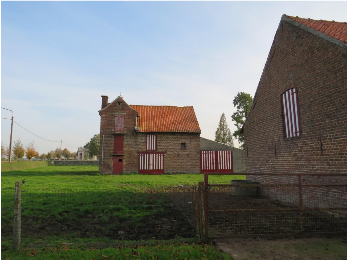
Foto 54: zicht op de noordelijke langsgevel van de chicorei- en tabaksast (naar de schuur gericht) vanaf de erfoprit – ook het houtwerk van de ast is geschilderd in de kenmerkende rood-witte kleurencombinatie – linker of oostelijke zijgevel van de schuur met laadluik met dito kleuren (31.10.2019).
