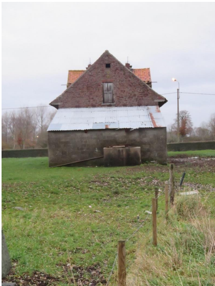
Foto 65: de westelijke zijgevel van de chicorei-ast – laaddeur in het gevelveld – aanbouw onder lessenaarsdak zonder erfgoedwaarde (13.12.2019).
