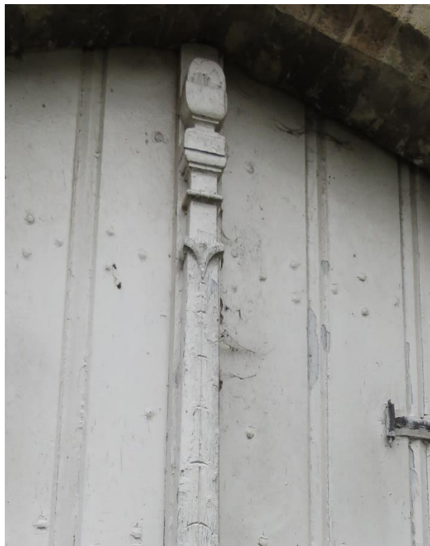
Foto 54: vleugelpoort - detail sierlijk gesculpteerde makelaar met geleding en topstuk (14.11.2019).
