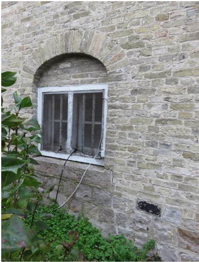
Foto 61: zuidelijke langsgevel van de hogere woon- of voutekamer- kelder: keldervenster verdiept in korfboognis (links) – houten bolkozijn en diefijzers (14.11.2019).
