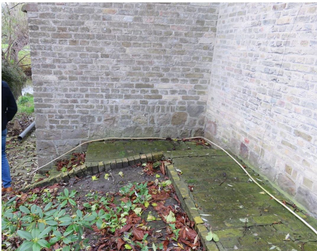
Foto 70: korte noordelijke langsgevel van de hogere woon- of voutekamer- plint in Artesiche zandsteen – omlopend bakstenen pad en dito trapje – overgang naar oostelijke langsgevel van keuken (14.11.2019).
