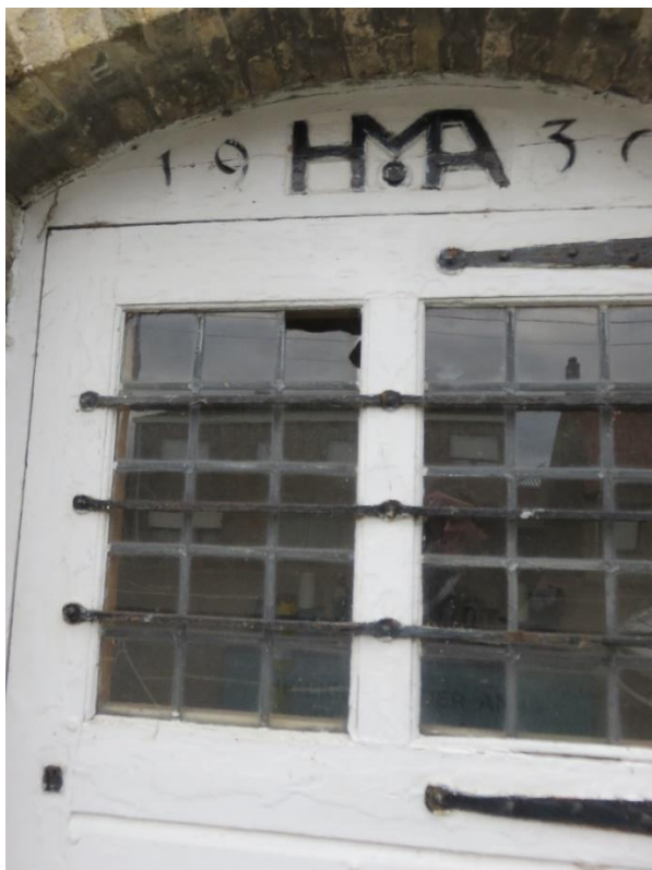
Foto 12: de Sint-Annakapel – straatgevel - detail van de deur met glas in lood en smeedijzeren tralies – boven de deur, sierlijk monogram "19 HMA 30" (14.11.2019).
