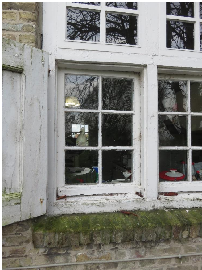
Foto 77: oostelijke langsgevel van de kook- & bakplaats – houten kruiskozijn met beluikte benedenvakken – kleine roedeverdeling (14.11.2019).
