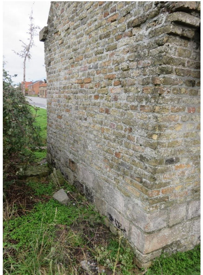
Foto 11: de Sint-Annakapel – hoek linker zijgevel en achtergevel – plint in Artesische zandsteen (14.11.2019).
