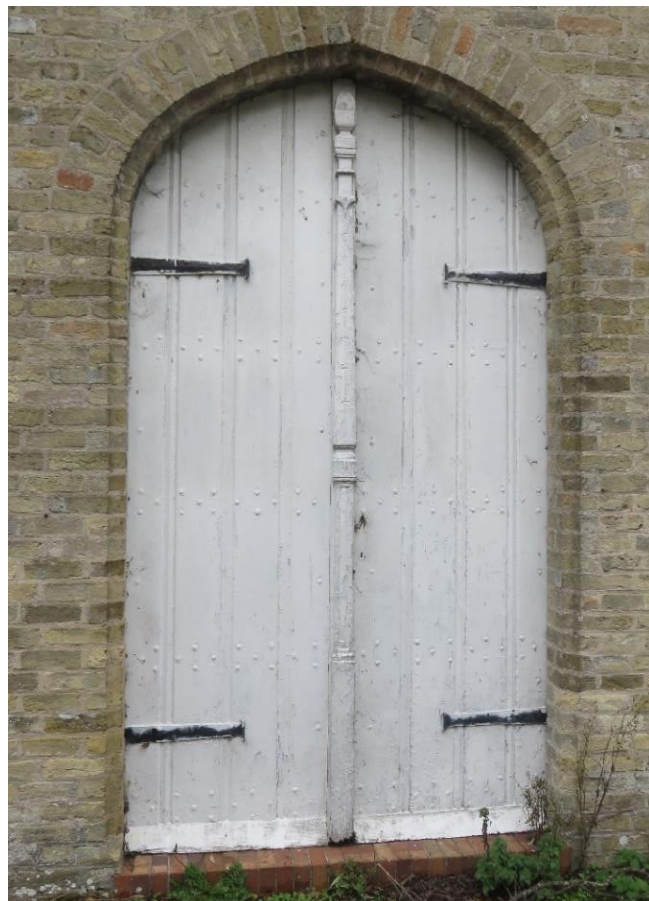
Foto 52: de hogere zuidvleugel met hall (zuidwesten) - zuidelijke langsgevel - vleugelpoort met gesculpteerde makelaar en smeedijzeren hengsels - smeedijzeren spijkers met sierlijke kop geven vijf horizontale banden aan (14.11.2019).
