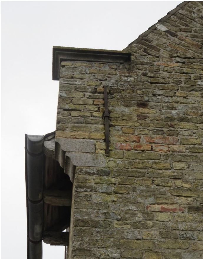
Foto 47: de hogere zuidvleugel met hall (zuidwesten) - westelijke zijgevel met tuitgevel met aandaken en vlechtingen – schouderstuk met natuur- of simillistenen kraagstenen (14.11.2019).
