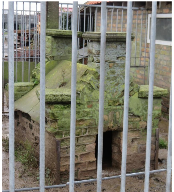
Foto 22: het bakstenen hondenhok – rechthoekige plattegrond – zijgevels als tuitgevels met aandaken en vlechtingen – rechthoekige opening (14.11.2019).
