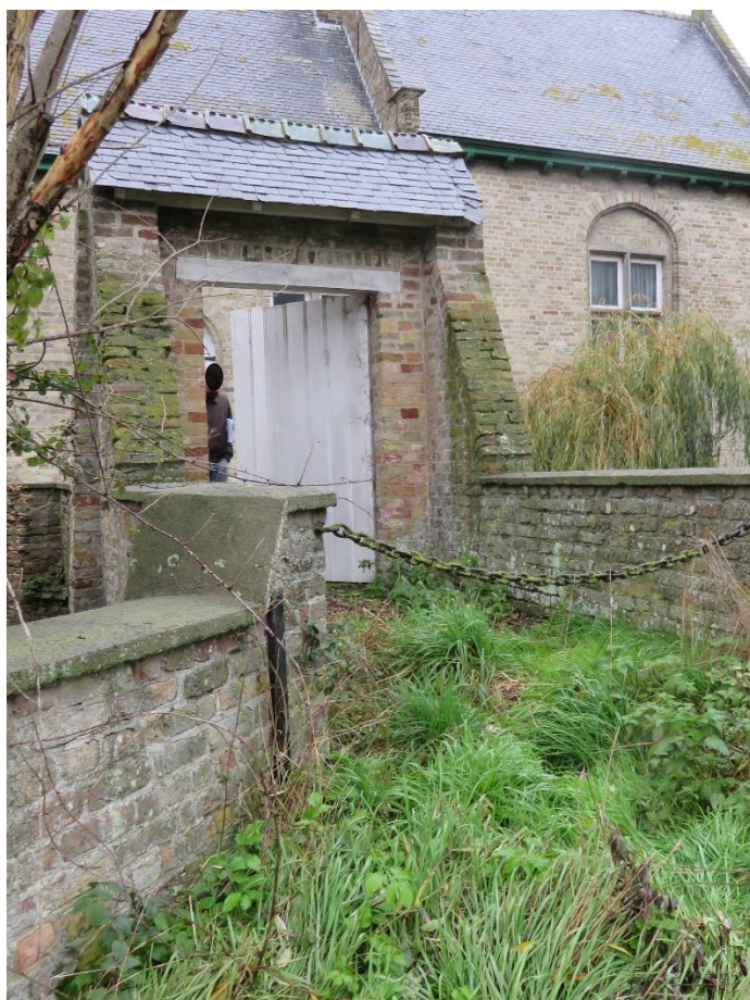
Foto 26: de omwalling rond het landhuis (zuidzijde) – lage muurtjes naar de toegangspoort, simillistenen dekplaten – poort onder leien zadeldak (14.11.2019).
