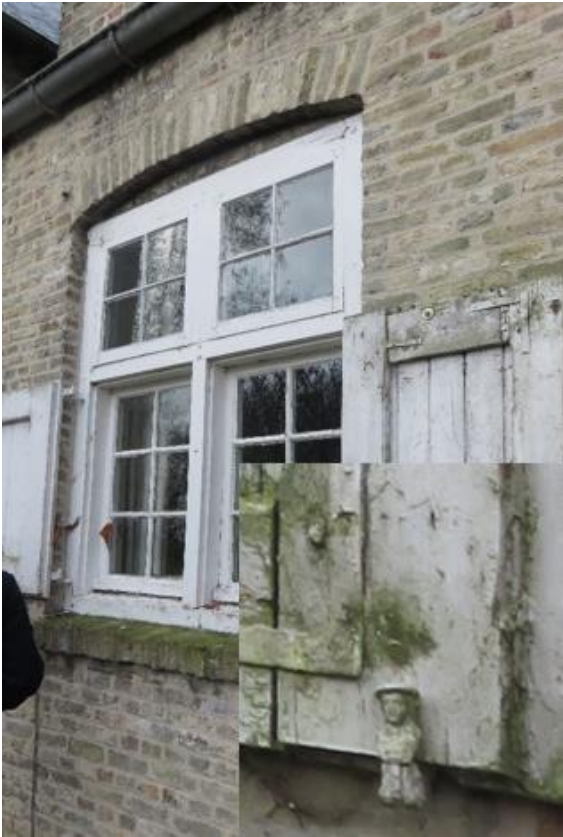
Foto 71: oostelijke langsgewel van de keuken - houten kruiskozijn met kleine roedeverdeling en beluikte benedenvakken - inzet: detail gietijzeren luikvasthouder met mannetje met baret (14.11.2019).
