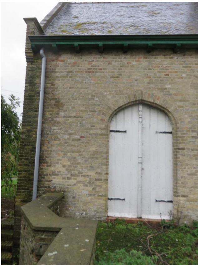
Foto 51: de hogere zuidvleugel met hall (zuidwesten) - zuidelijke langsgevel - het tudorboogportaal in profielbaksteen - dit portaal is toegankelijk via de brug met poort en het ommuurde pad (14.11.2019).
