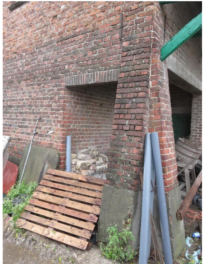
Foto 90: hoek langse erfgevel/ linker of zuidelijke zijgevel – haaks op elkaar gestelde steunberen - overdekte werkruimte, rechthoekige muuropening onder strek (14.11.2019).
