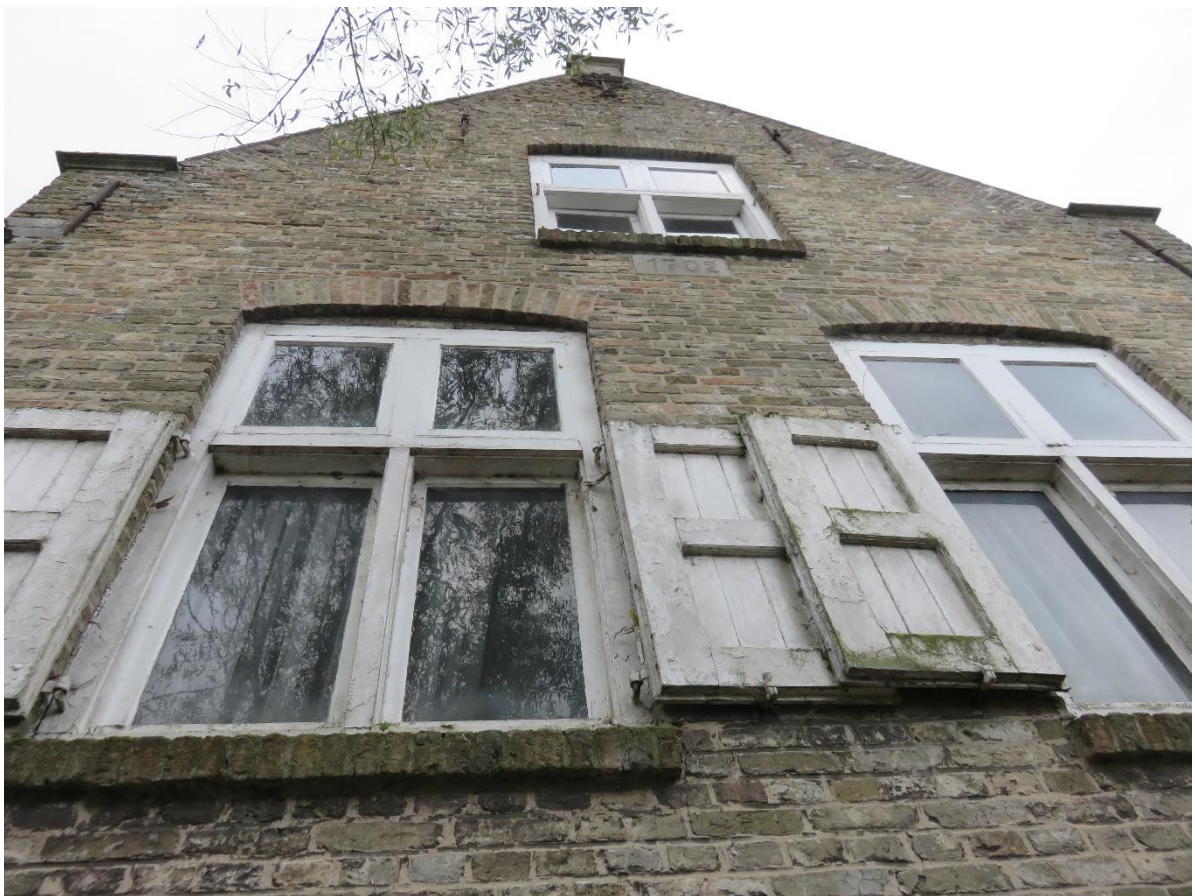
Foto 63: oostelijke zijgevel van de hogere woon- of voutekamer- tuitgevel met aandaken en vlechtingen – houten kruiskozijnen op bakstenen afzaat, beluikte benedenvakken (14.11.2019).
