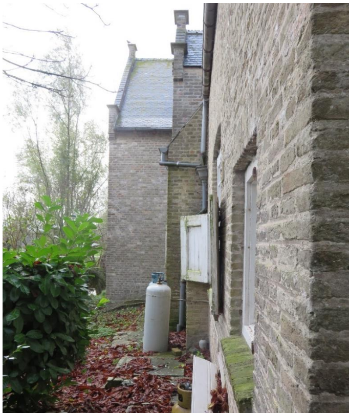
Foto 73: de oostelijke langsgewels van de kook- & bakplaats en de keuken - zicht op de korte noordelijke langsgewel van de voutekamer- getrapt grondplan (14.11.2019).
