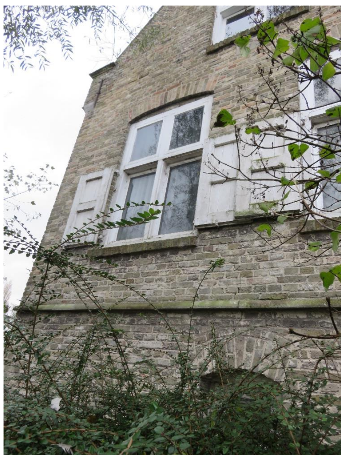
Foto 67: oostelijke zijgevel van de hogere woon- of voutekamer- tuitgevel met aandaken en vlechtingen- kelder met getoogd keldervenster (14.11.2019).
