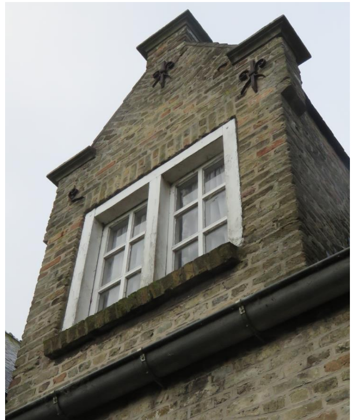
Foto 72: oostelijke langsgewel van de keuken - dakvenster met tuitgevel, aandaken en vlechtingen sierlijke muurankers - houten bolkozijn met kleine roedeverdeling (14.11.2019).
