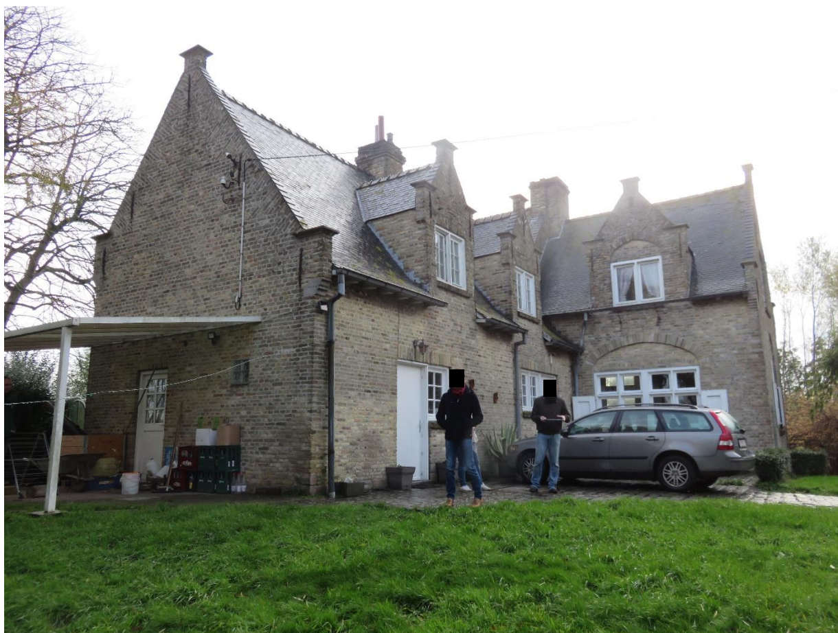
Foto 42: het omwalde landhuis - de lagere noordvleugel met kook- & bakplaats en keuken: noordelijke zijgevel en westelijke langsgevel - hoek met de hogere zuidvleugel met hall (zuidwesten) - noordelijke langsgevel van de hall (14.11.2019).
