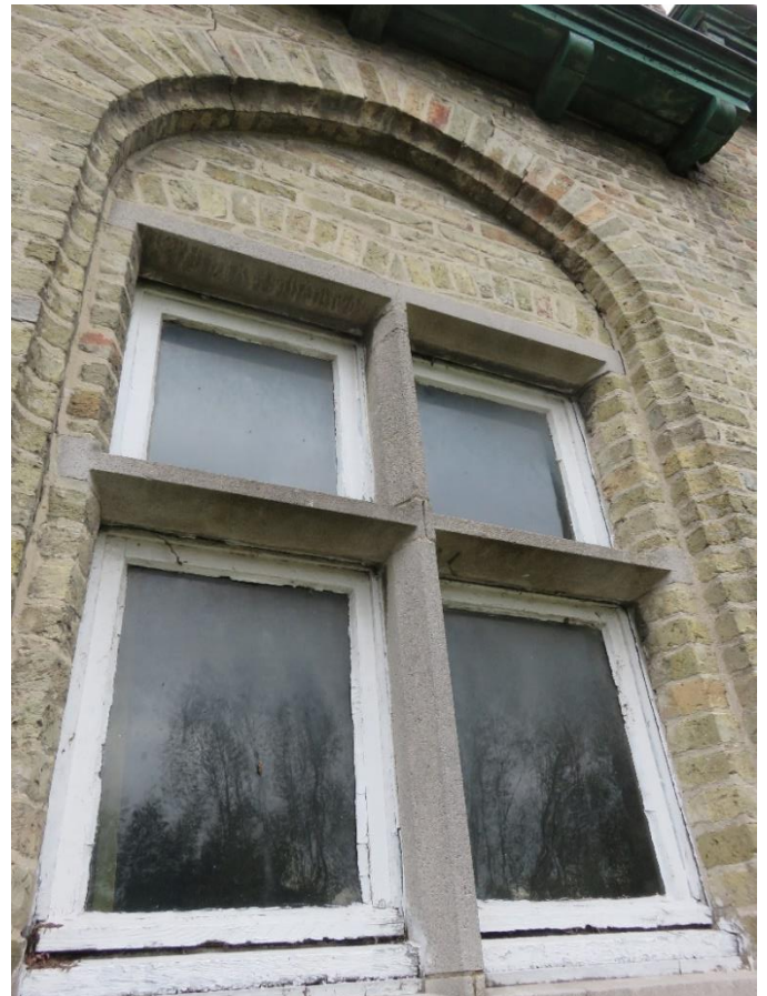
Foto 56: de hogere zuidvleugel met hall (zuidwesten) – zuidelijke langsgevel – rechts van het portaal: stenen kruiskozijn in korfboogomlijsting in profielbaksteen - ingevuld met geschilderd houten raam (14.11.2019).
