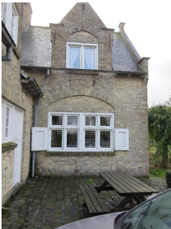
Foto 45: de hogere zuidvleugel met hall (zuidwesten) - noordelijke langsgevel – brede vensterpartij met houten kruiskozijnen, gevat in korbboognis – dakvenster met tuitgevel en vlechtingen (14.11.2019).
