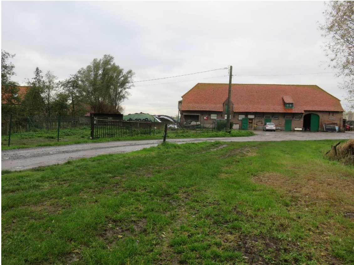
Foto 79: zicht op de imposante stal- en schuurvleugel vanaf de erfoprit en de huisweides. Het recente houten stalletje dat links in beeld komt heeft geen erfgoedwaarde (14.11.2019).
