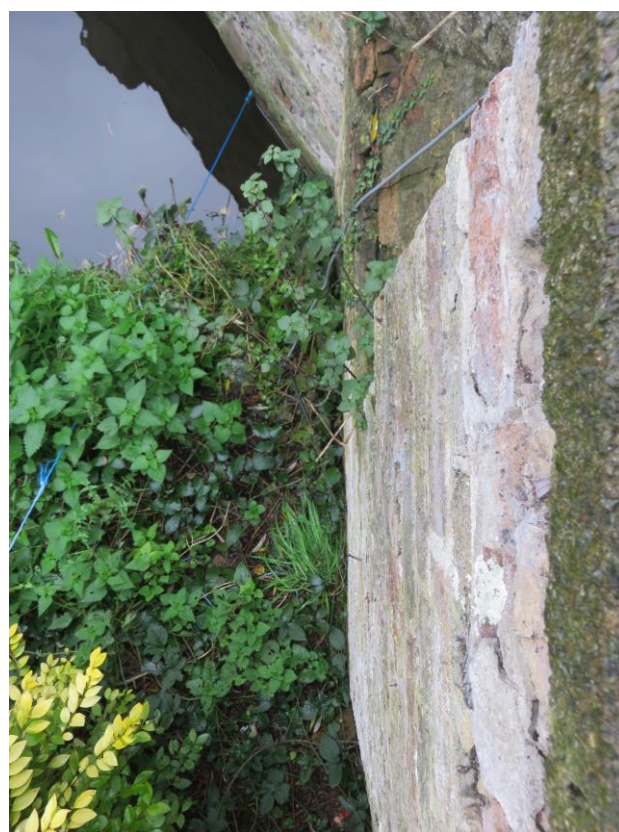
Foto 32: bij de overgang van het water naar de oever (oostzijde, kant van het portaal) is de hoek tussen de brug en de verbreding van de borstwering versterkt met een schuinoplopende bakstenen muurdam. (14.11.2019).
