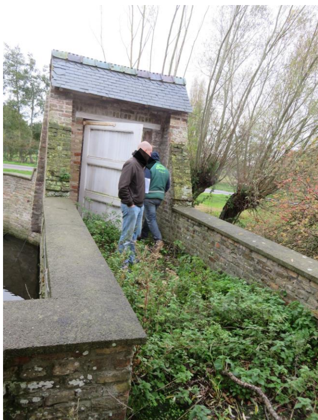
Foto 31: omwalling (zuidzijde) – poort onder leien zadeldak – de borstwering van het brugdek verbreedt naar het portaal toe (14.11.2019).
