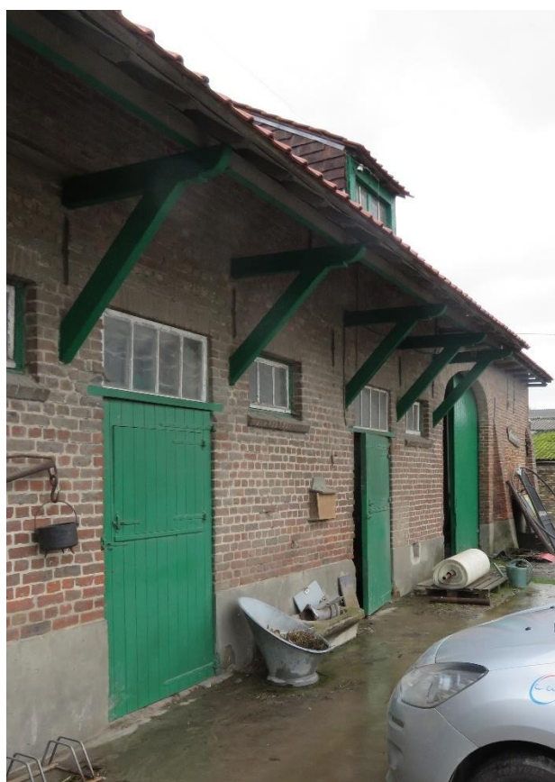
Foto 85: de oostelijke langsgevel of de erfgevel van de stal- en schuurvleugel – rechthoekige staldeuren onder bakstenen strek – opgeklampte deuren met openklapbaar luik in de bovenkant en geleed bovenlicht (14.11.2019).
