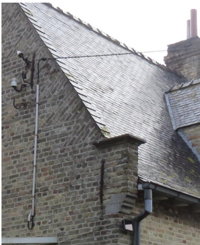
Foto 43: de lagere noordvleugel met kook- & bakplaats – noordelijke zijgevel - tuitgevel met aandaken en vlechtingen - schouderstuk met natuur- of simillistenen kraagstenen en deksteen (14.11.2019).
