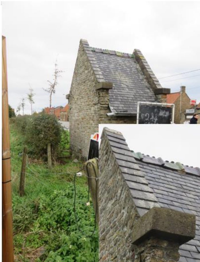
Foto 10: de Sint-Annakapel – linker zijgevel en achtergevel – leien zadeldak - inzet: detail aandak en sierlijke keramische nokpannen (14.11.2019).
