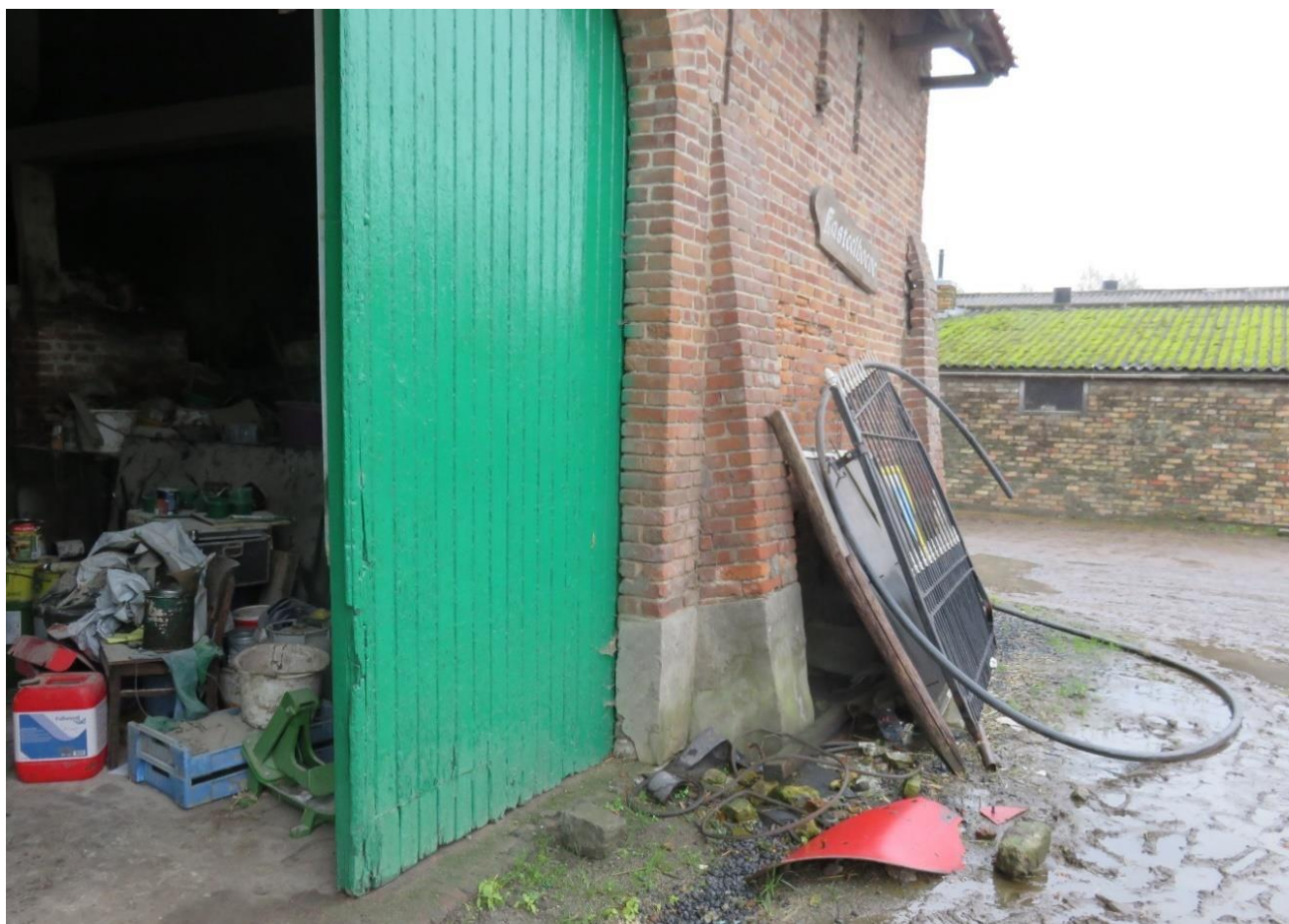
Foto 88: bewaarde schuurpoort met twee vleugels – schuinoplopende steunberen rechts van de schuurpoort met twee vleugels – verticale verluchtungspleuven (14.11.2019).
