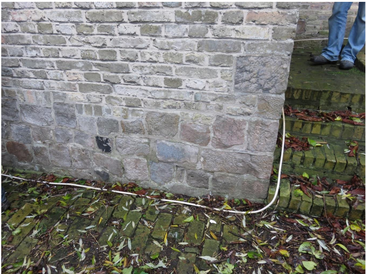
Foto 69: oostelijke zijgevel van de hogere woon- of voutekamer- plint in Artesiche zandsteen – dito hoeksteen op hoek met de korte noordelijke langsgevel - omlopend bakstenen pad en dito trapje (14.11.2019).
