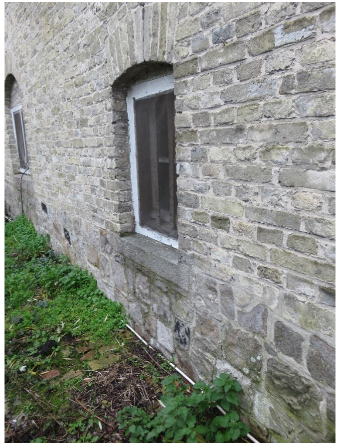
Foto 62: zuidelijke langsgevel van de hogere woon- of voutekamer- kelder: getoogd keldervenster (rechts) met houten kozijn en diefijzers - plint in Artesische zandsteen (14.11.2019).
