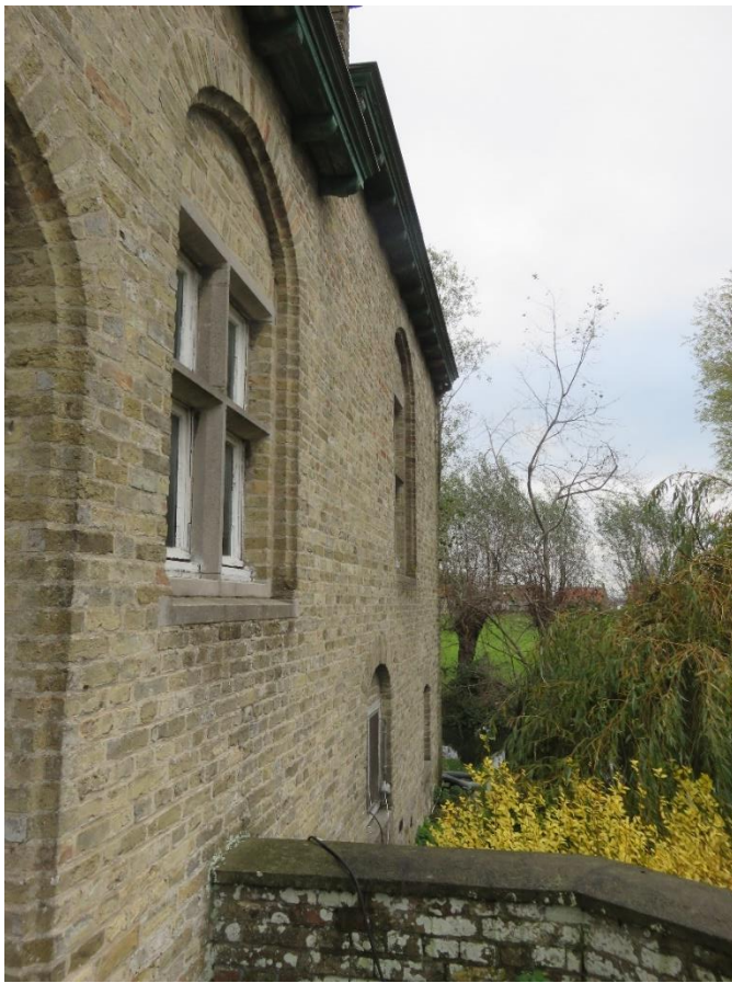
Foto 55: de hogere zuidvleugel met hall (zuidwesten) – zuidelijke langsgevel – rechts van het portaal: stenen kruiskozijn – achter het muurtje: zicht op de hogere zuidvleugel (zuidoosten) met kelder en woon- of voutekamer(14.11.2019).
