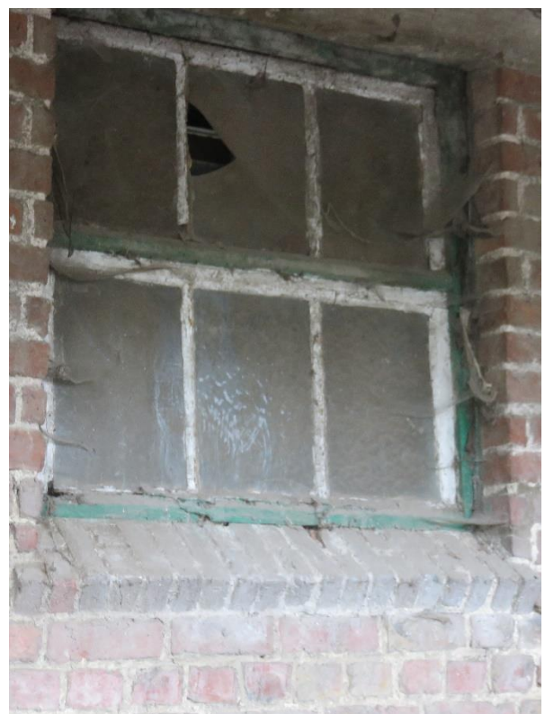
Foto 83: uitsparing in de gevel met overdekte werkruimte – bewaard stalvenster met kleine roedeverdeling – bakstenen afzaat (14.11.2019).
