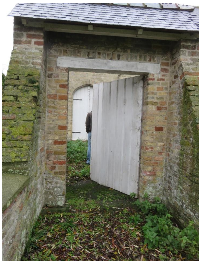
Foto 27: omwalling (zuidzijde) – houten rechthoekige poort onder leien zadeldak, overstek op houten modillons – doorkijk vanop de brug op het portaal in de hall van het landhuis (14.11.2019).
