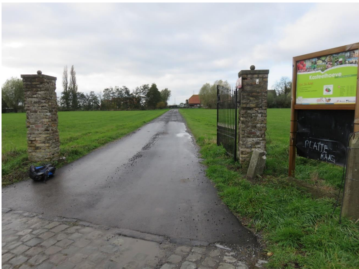
Foto 6: erfoprit aan de straatzijde – bakstenen hekpijlers met natuur- of similistenen dekplaat met bolbekroning – donker geschilderd gietijzeren vleugelhek met twee vleugels (14.11.2019).
