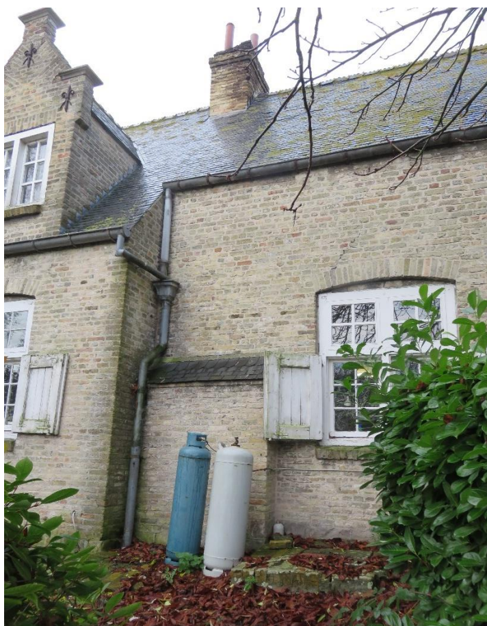
Foto 75: overgang van kook- & bakplaats naar keuken (oostelijke langsgevels) – getrapt grondplan – uitbuiking ter hoogte van bakoven (14.11.2019).
