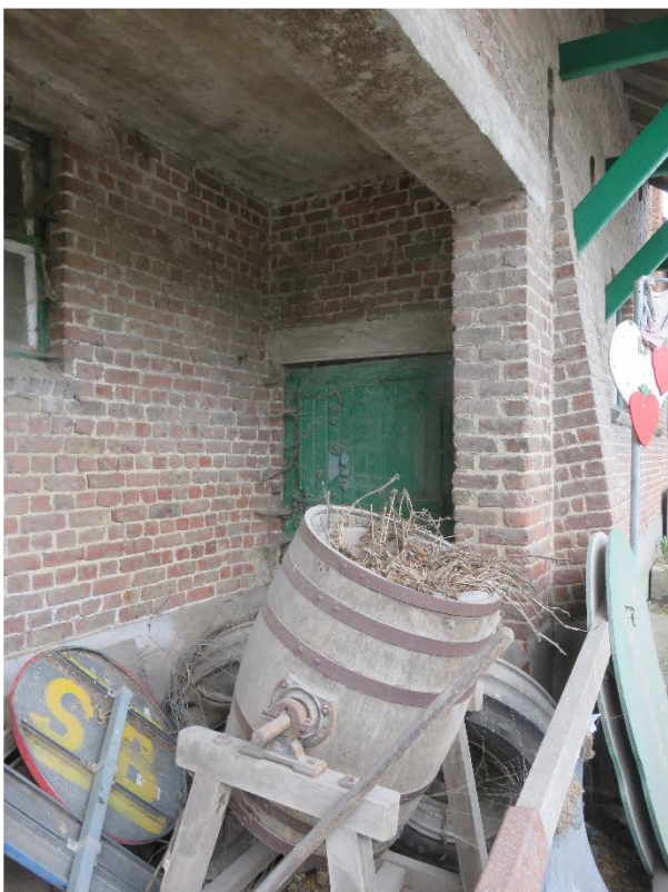
Foto 82: de oostelijke langsgevel van de stal- en schuurvleugel – uitsparing in de gevel met overdekte werkruimte – betonnen latei en plafond – staldeur en -venster onder dito lateien – steunbeer rechts (14.11.2019).
