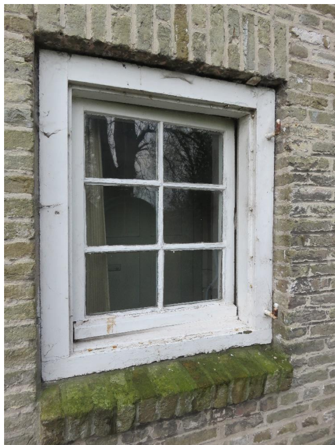
Foto 78: oostelijke langsgevel van de kook- & bakplaats – houten kozijn met luikhengsels - kleine roedeverdeling (14.11.2019).
