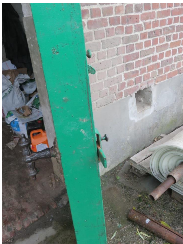
Foto 86: de oostelijke langsgevel of de erfgevel van de stal- en schuurvleugel – opgeklampte staldeuren met bewaard ijzeren hang en sluitwerk (14.11.2019).
