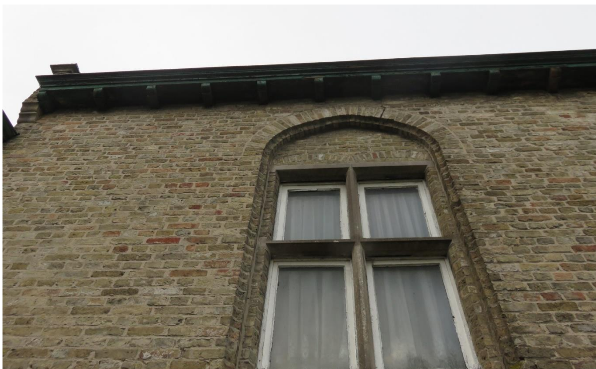
Foto 60: zuidelijke langsgevel van de hogere woon- of voutekamer- opkamervenster: stenen kruiskozijn in korfboogomlijsting in profielbaksteen - ingevuld met geschilderd houten raam (14.11.2019).
