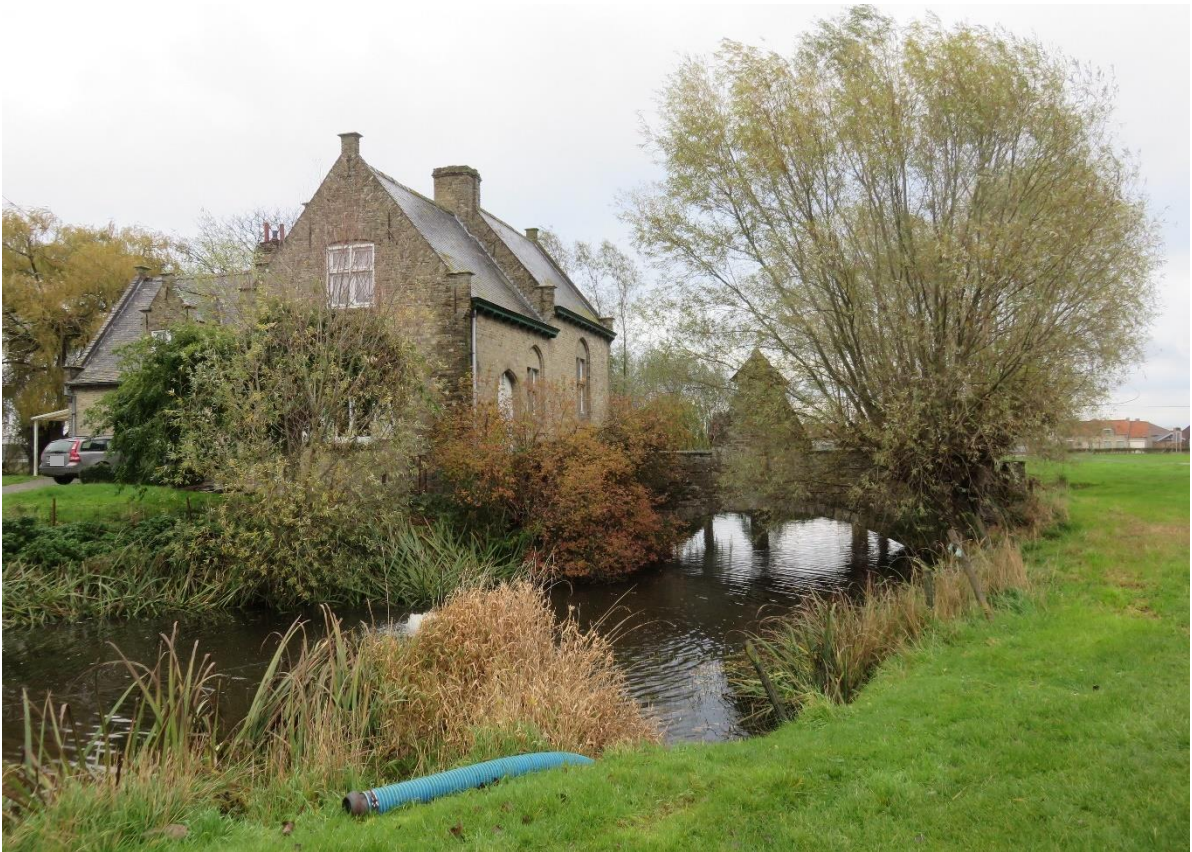
Foto 16: de omwalling rond het landhuis (zuidwestzijde) – zicht op het landhuis en de brug met toegangspoort vanuit het westen (14.11.2019).
