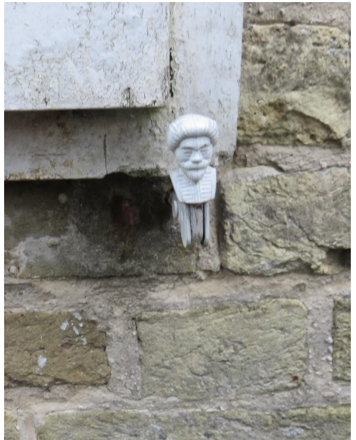
Foto 48: de hogere vleugel met hall (zuidwesten) - westelijke zijgevel met tuitgevel met aandaken en vlechtingen – gietijzeren luikvasthouder met bebaard mannetje (14.11.2019).
