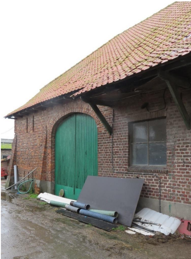
Foto 94: achtergevel met korfbogige schuurpoort - bewaarde poort met twee vleugels - overgang naar smalle dakoverstek op houten modillons bij schuurgedeelte - steunberen en verticale verluchtungspleuven onder en boven - vernieuwde invulling raam zonder erfgoedwaarde (14.11.2019).
