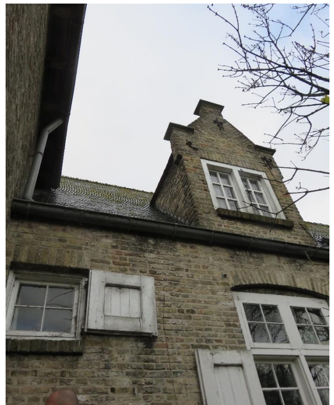
Foto 74: oostelijke langsgewel van de keuken - vierkant kozijnvenstertje en houten kruiskozijn, luiken - dakvenster met tuitgevel (14.11.2019).
