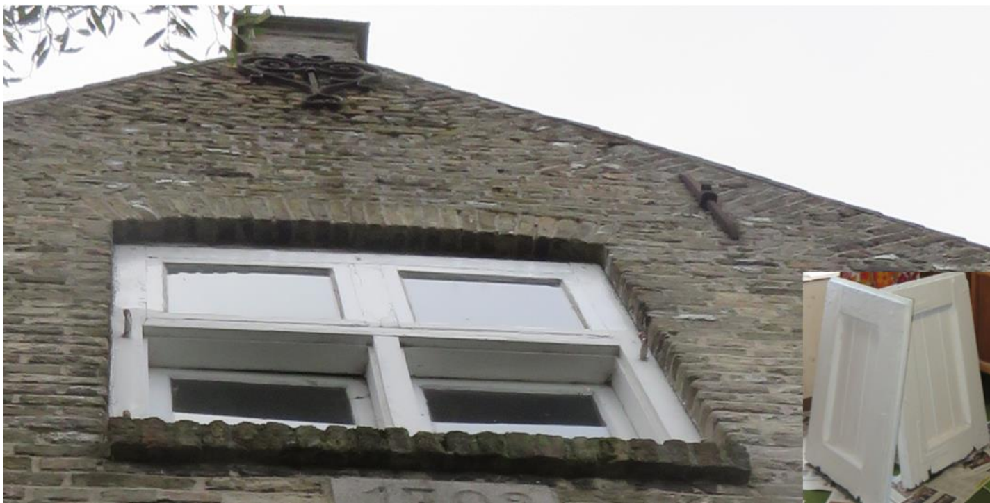
Foto 64: oostelijke zijgevel van de hogere woon- of voutekamer- tuitgevel met aandaken, vlechtingen en sieranker onder het tuitstuk – zoldervenster: houten kruiskozijn op bakstenen afzaat, luikduimen in het houtwerk – inzet: de luiken van de benedenvakken zijn tijdelijk gedemonteerd om te schilderen (14.11.2019).
