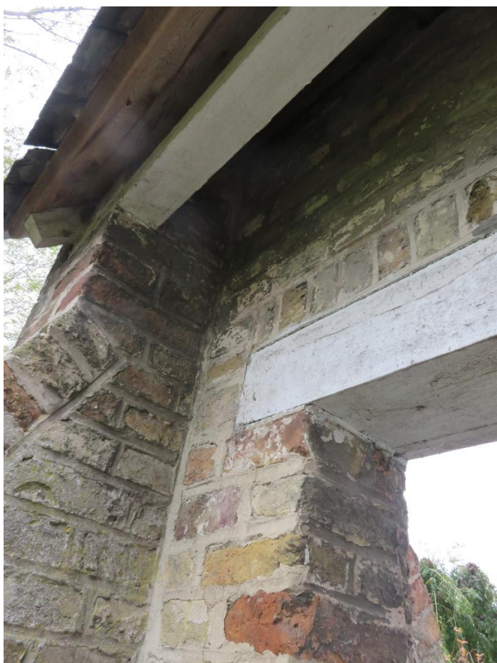
Foto 29: omwalling (zuidzijde) – poort onder leien zadeldak – detail steunbeer, latei en dakoverstek (14.11.2019).
