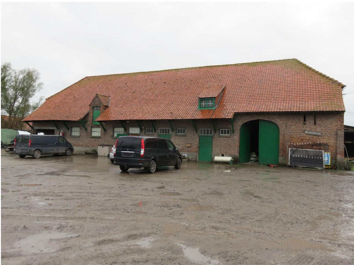
Foto 80: de oostelijke langsgevel of de erfgevel van de stal- en schuurvleugel – gevat onder zadeldak met wolfseinden – brede, licht geknikte dakoverstek – dakvenster (laadvenster) met puntgevel (links) en dakkapel onder sleepdak (14.11.2019).
