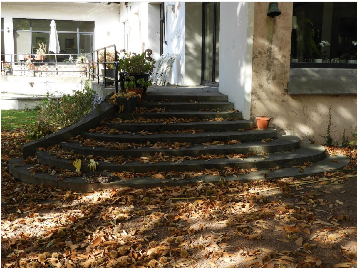
Foto 14: Villa Limpens, trappenpartij die toegang geeft tot het terras. Terras afgezet met buisleuning.
