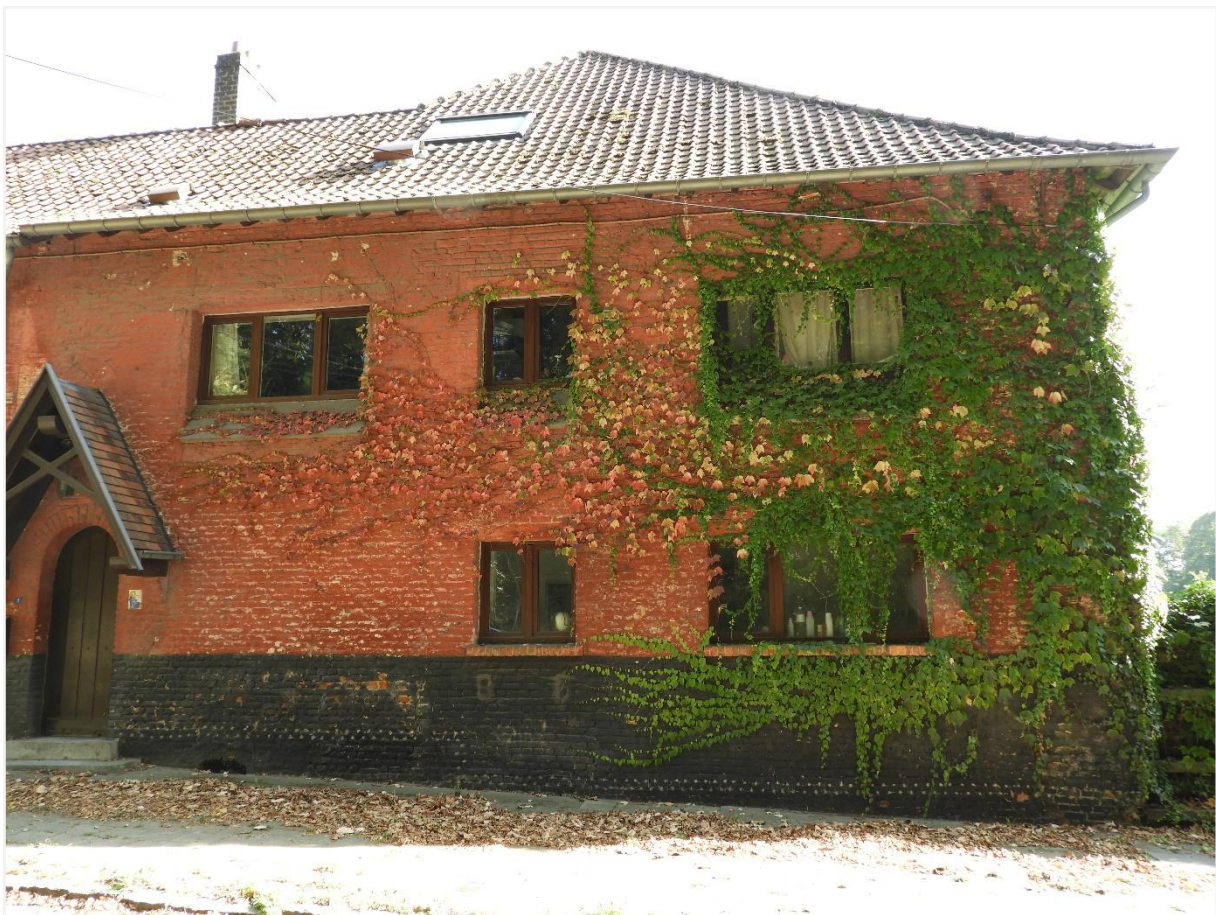
Foto 20: Dienstwoning, westgevel aan de Brabandtlaan.
