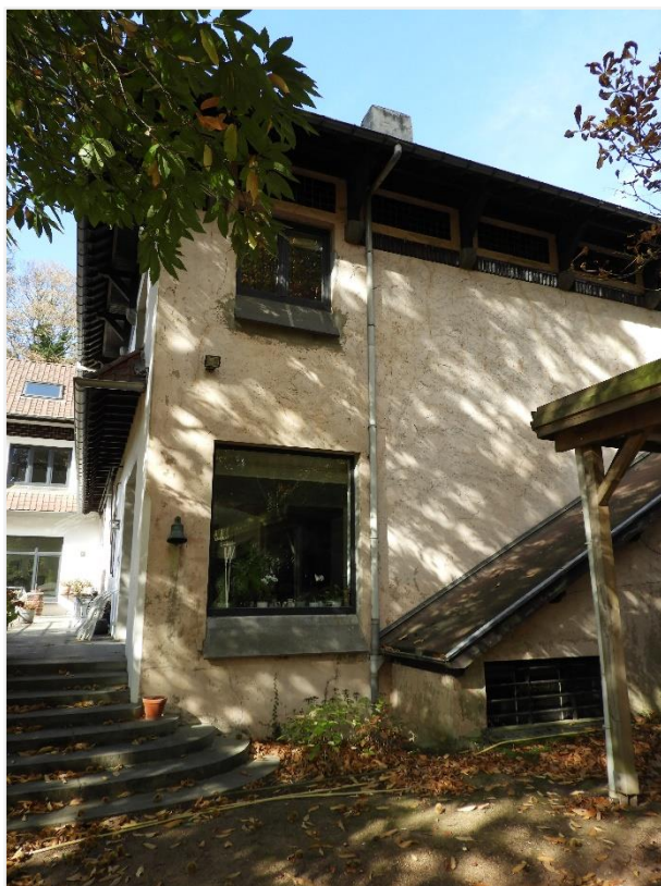
Foto 16: Villa Limpens, oostgevel.
