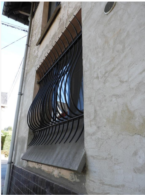
Foto 7: Villa Limpens, detail gevel Brabantlaan, muuropeningen met afzaat en diefijzers.
