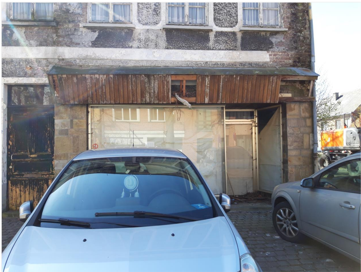
Foto 4: Detail benedenverdieping rechts winkelpui
