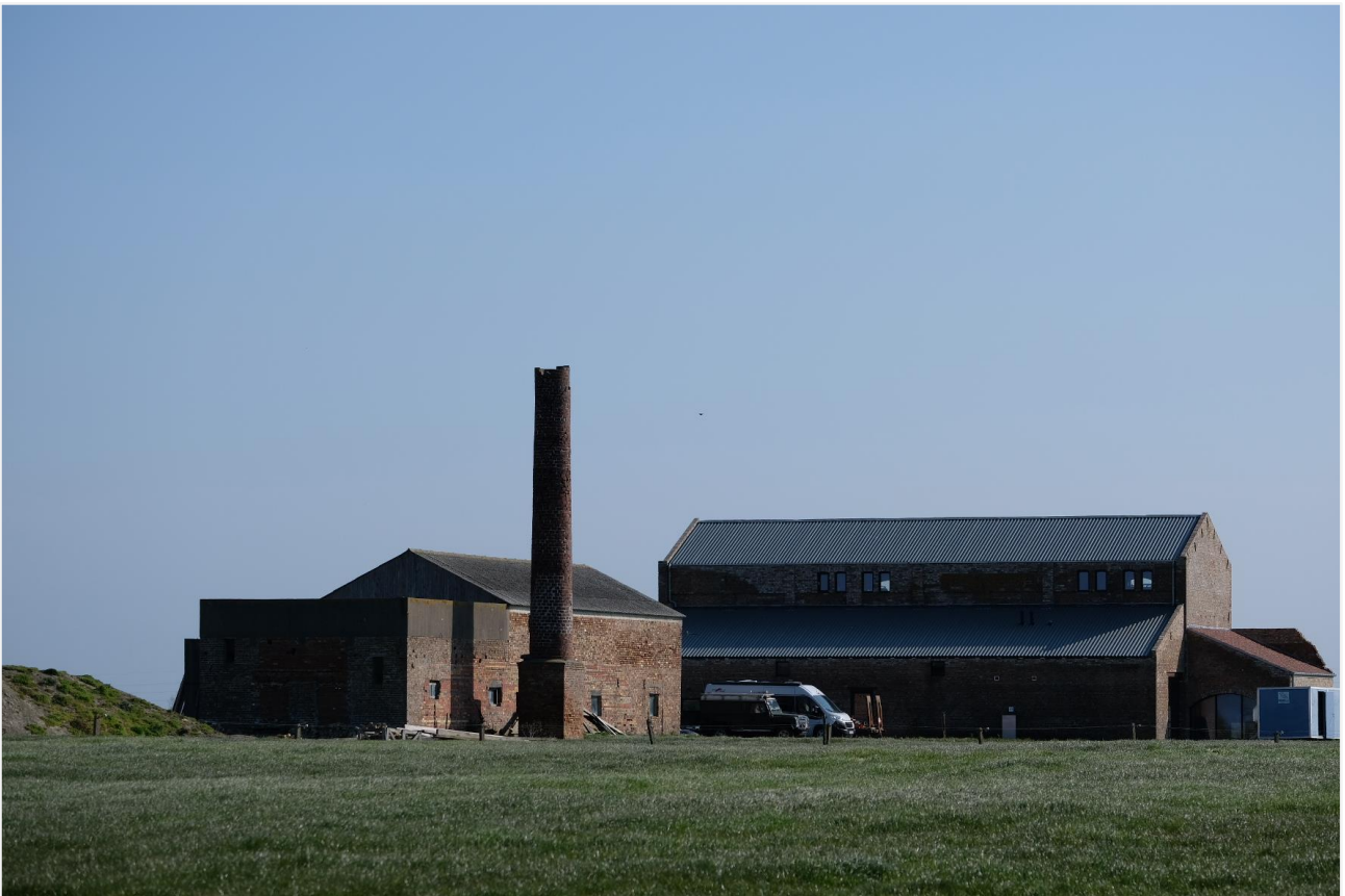
Foto 4: Achterliggende ateliergebouw van steenbakkerij met fabrieksschoorsteen uit het interbellum (plaatsbezoek 21 april 2021)
