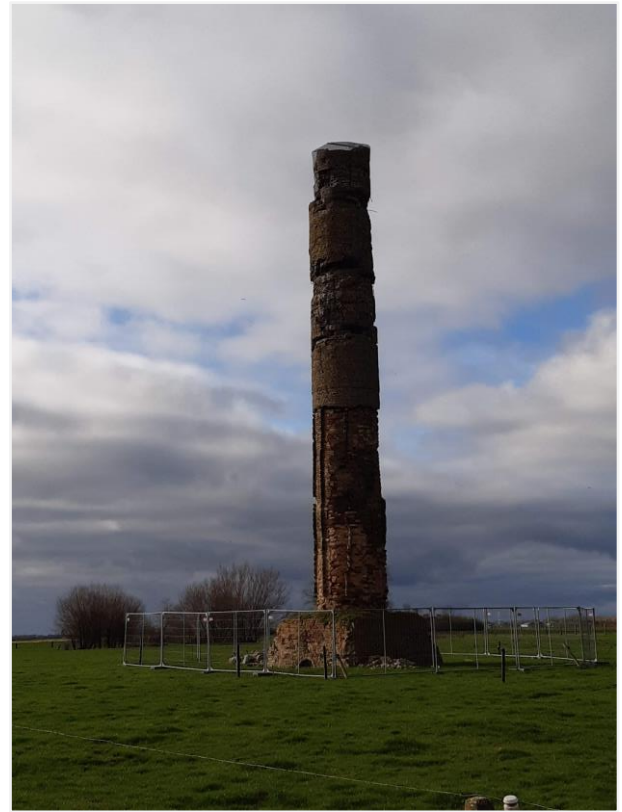
Foto 7: Fabrieksschoorsteen noordoostelijke zijde (plaatsbezoek 5 februari 2021)
