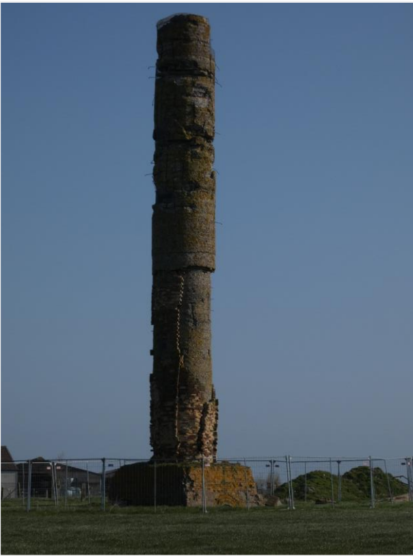
Foto 1: Fabrieksschoorsteen noordoostelijke zijde (plaatsbezoek 21 april 2021)
