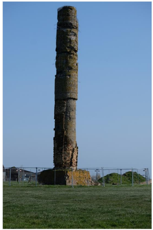
Foto 2: Fabrieksschoorsteen noordoostelijke zijde (plaatsbezoek 21 april 2021)
