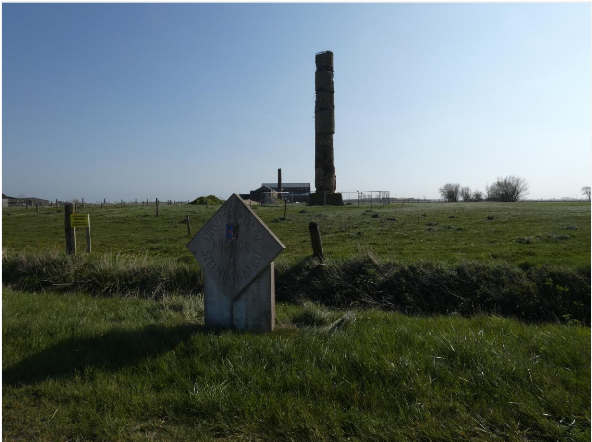
Foto 3: Fabrieksschoorsteen (plaatsbezoek 21 april 2021)
