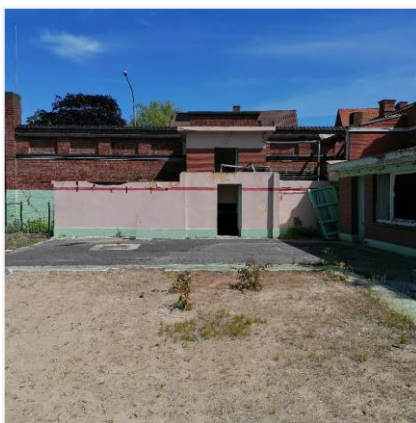
Foto 56: Noordelijke afsluitingsmuur openluchtwembad Ieper (Stad Ieper 8 juni 2021).
