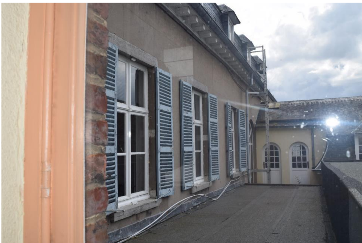
Foto 67: kasteel de Bunswyck: zicht op de westelijke achtergevel ter hoogte van de eerste verdieping, met hedendaagse overbouw van de vroegere binnenkoer met een nieuwe constructie ten behoeve van de herbestemming
