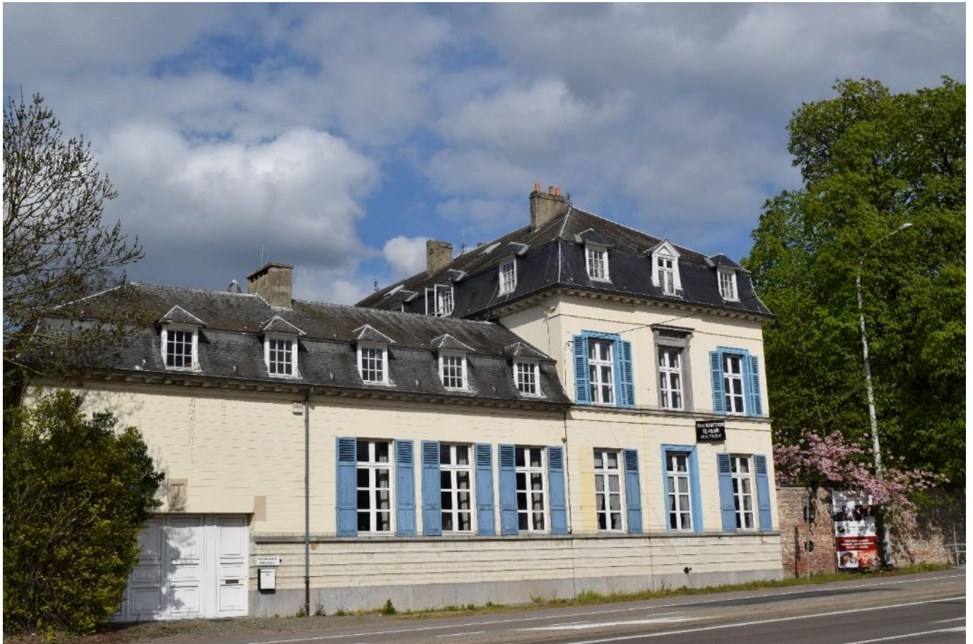
Foto 62: kasteel de Bunswyck: zuidelijke zijgevel van twee bouwlagen verlengd met dwarsvleugel van één bouwlaag
