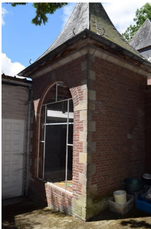
Foto 80: kasteel de Bunswyck: achterzijde van het torentje in neotraditionele stijl op vierkantig grondplan met muuropening en restant van metalen raamframe, vroeger dienstig als volière
