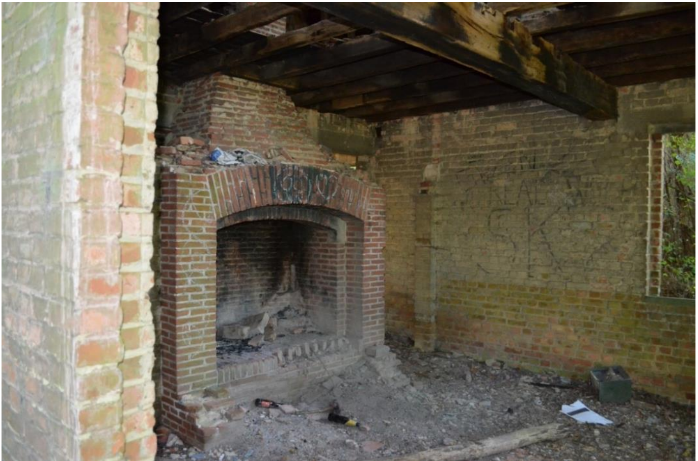
Foto 50: zicht vanuit het noorden op de open haard in de voorkamer of 'salon' van de belvédère en ontbrekend schrijnwerk in de muuropeningen
