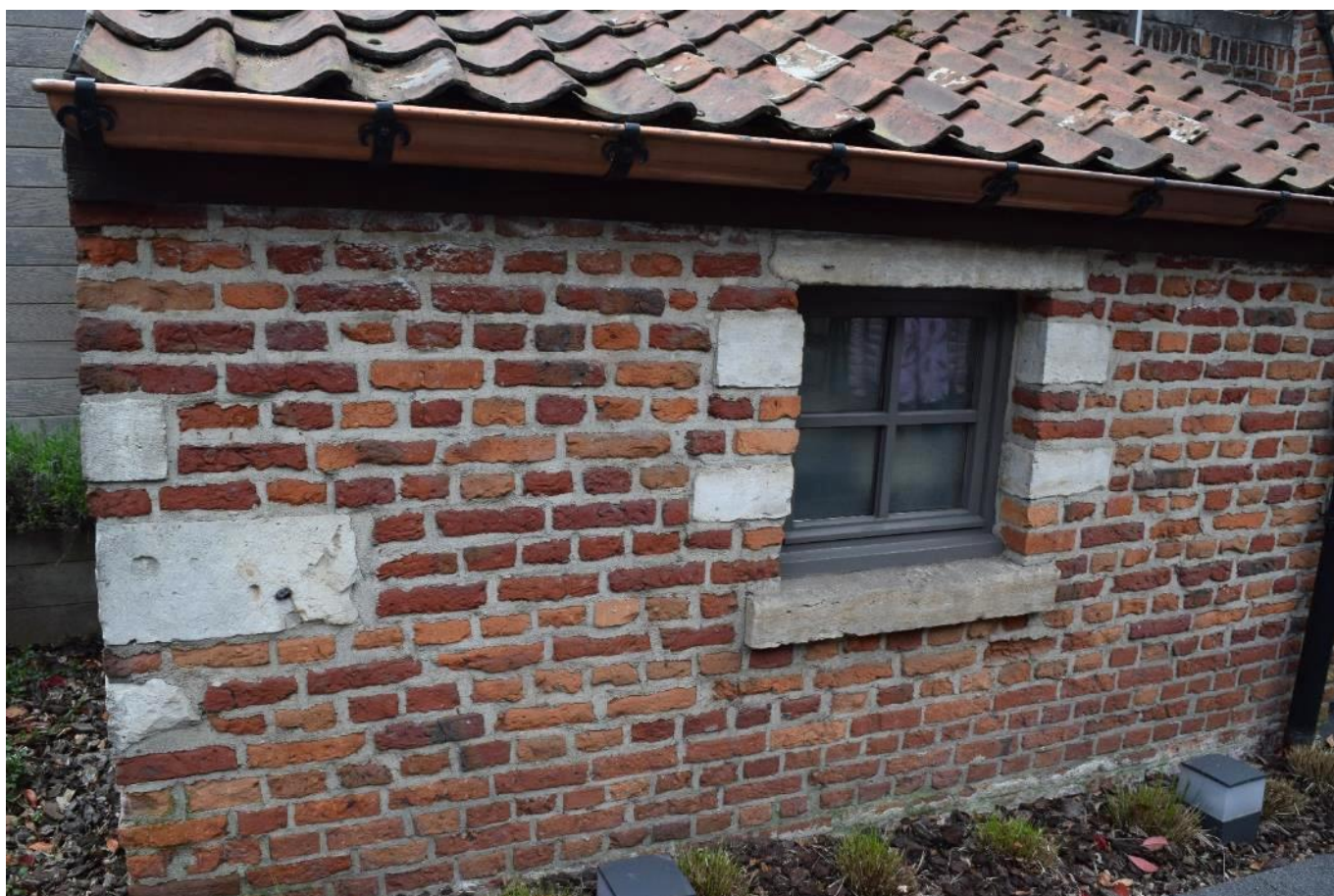
Foto 92: afspanning De Mol: klein manshoog stalletje onder lessenaarsdak met oude bouwsporen, aangebouwd tegen de achtergevel van de afspanning
