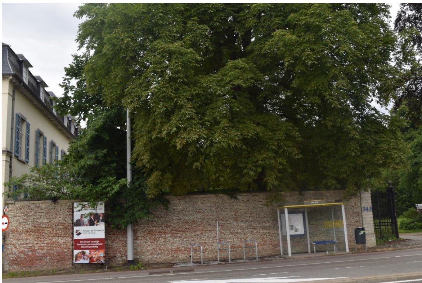
Foto 84: westelijke omheiningsmuur rechtstreeks aansluitend bij de zuidoosthoek van het kasteel
