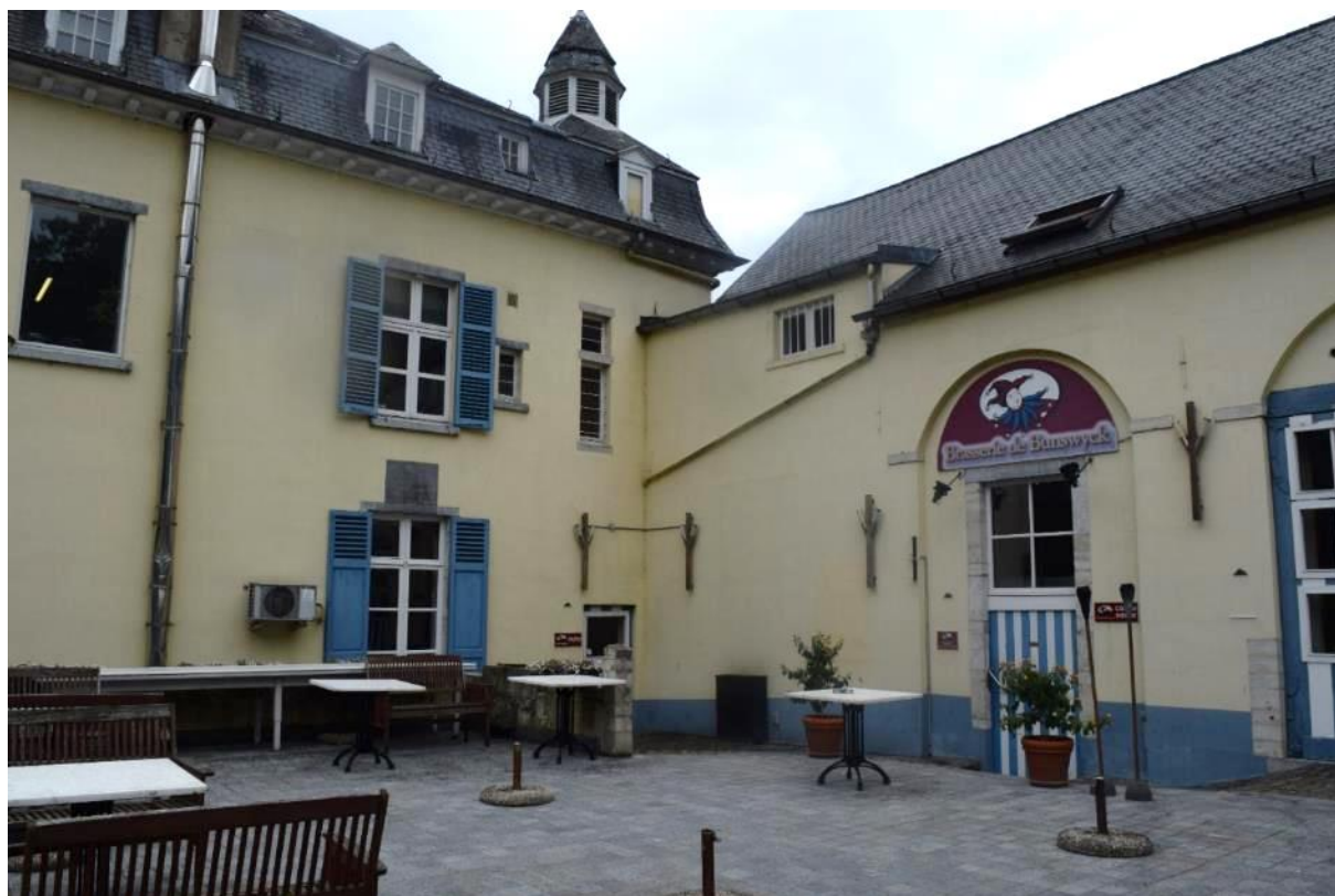
Foto 70: kasteel de Bunswyck: zicht vanuit het Klein park op de noordelijke zijgevel van het kasteelgebouw met dwarsvleugel; aansluitend de vroegere dienstgebouwen van koetshuis en remise, gelegen rond een gekasseide binnenkoer, deels recent geplaveid
