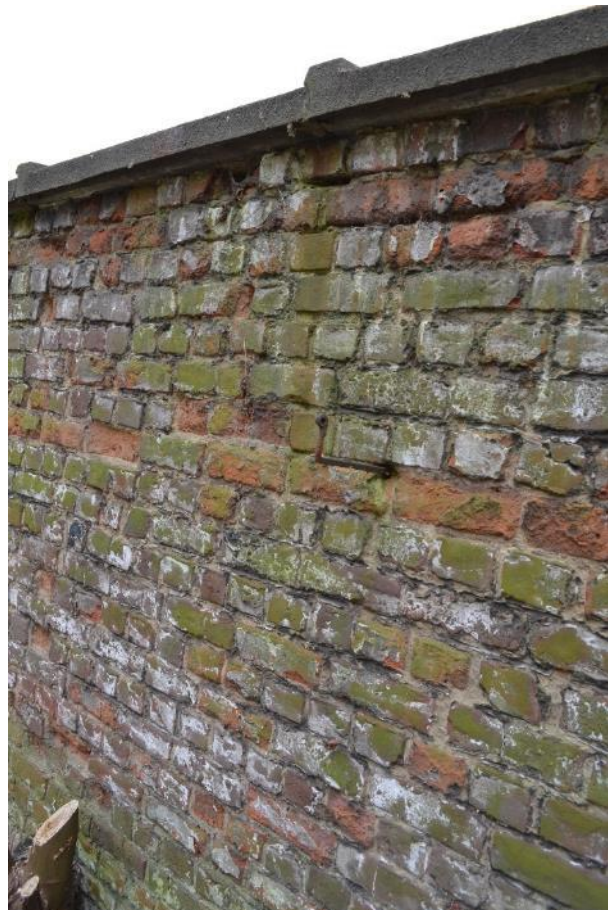
Foto 34: sporen van witkalk en nog aanwezige haken in de omheiningsmuur voor het leiden van fruit
