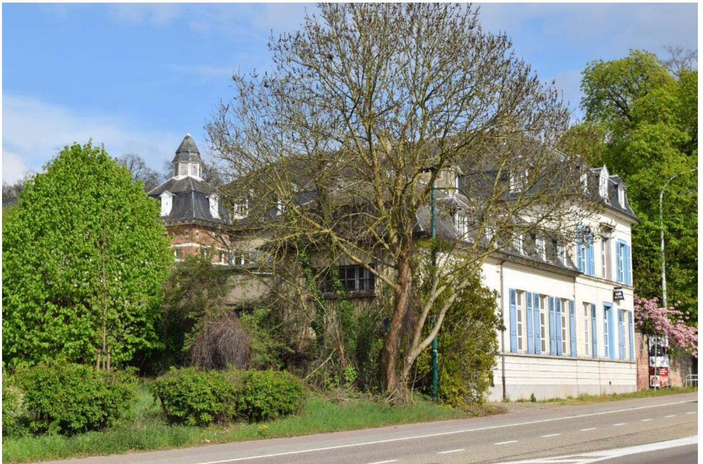
Foto 63: kasteel de Bunswyck: zicht vanop de Tiensesteenweg op de westelijke gevel of achtergevel en op de zuidgevel aan de straat
