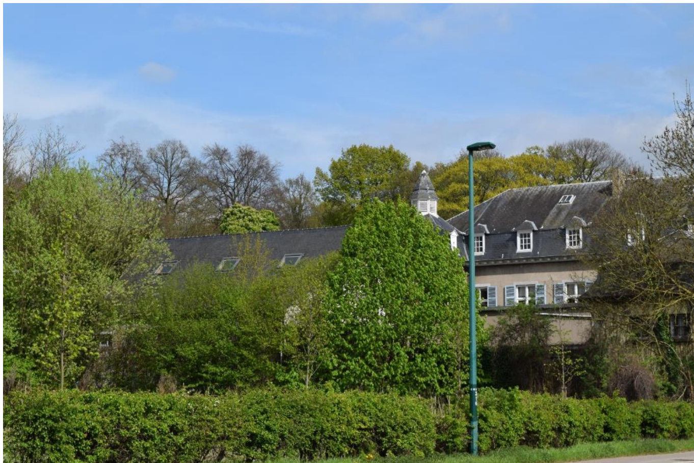
Foto 64: kasteel de Bunswyck: zicht op westgevel of achtergevel van het hoofgebouw en op de bedaking van het aanpalend dienstgebouw
