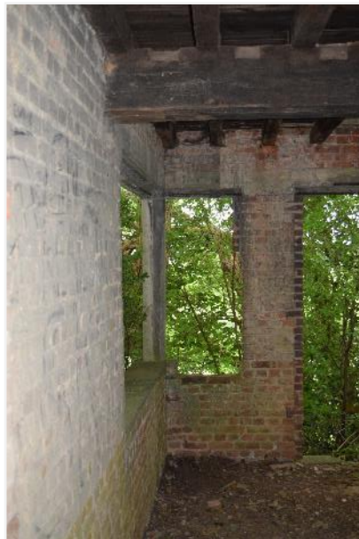
Foto 52: belvédère: zicht op ramen en deuropening naar het terras
