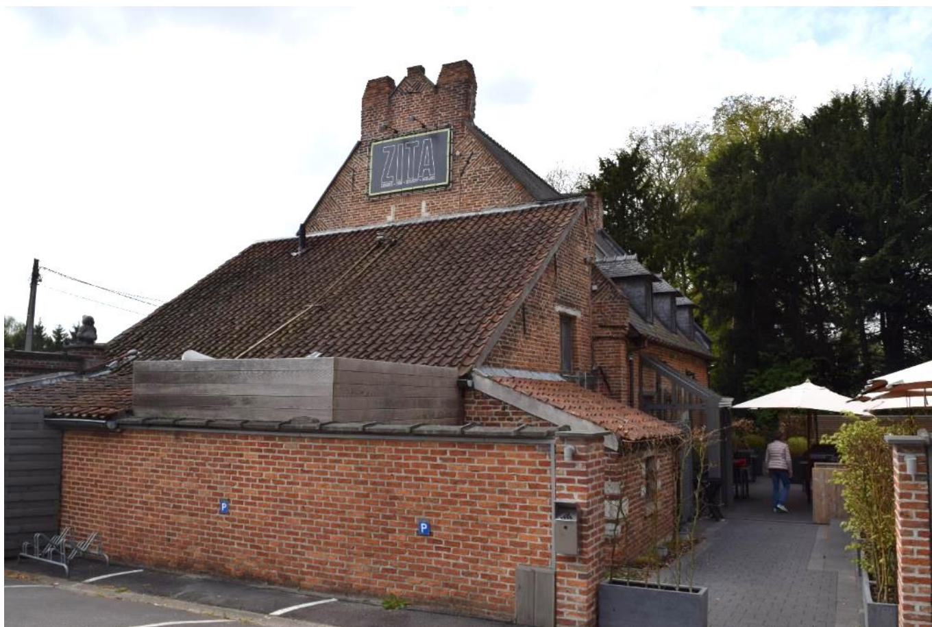
Foto 91: afspanning De Mol: oostelijke zijgevel van hoofdgebouw met twee aanbouwtjes onder lessenaarsdak, ommuurd en met recente aanbouwsels
