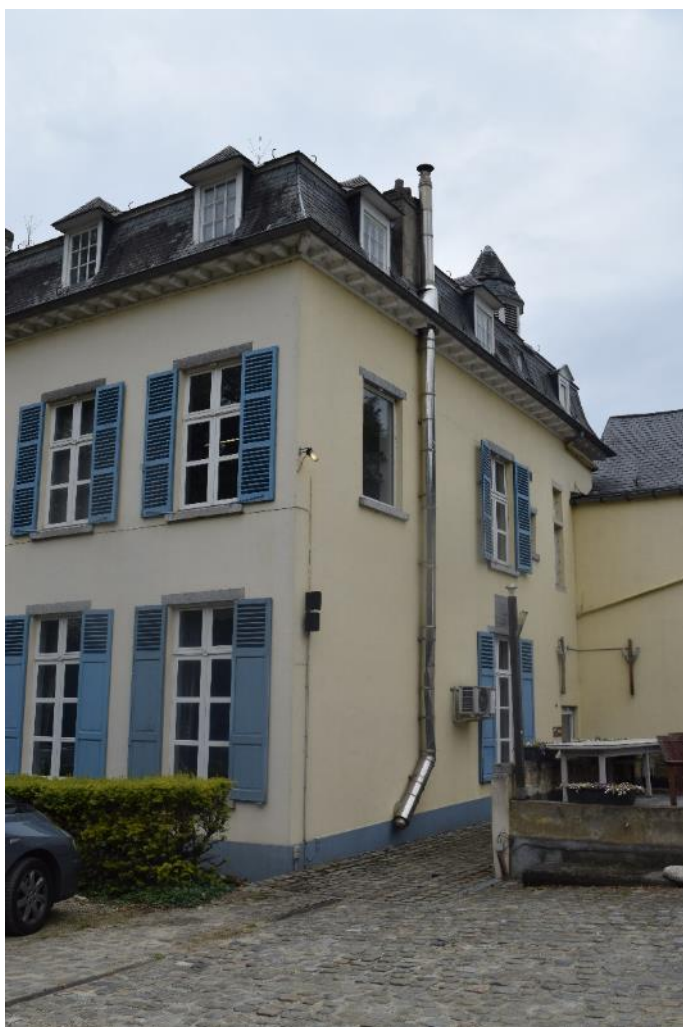
Foto 68: noordelijke zijdegevel van het kasteelgebouw
