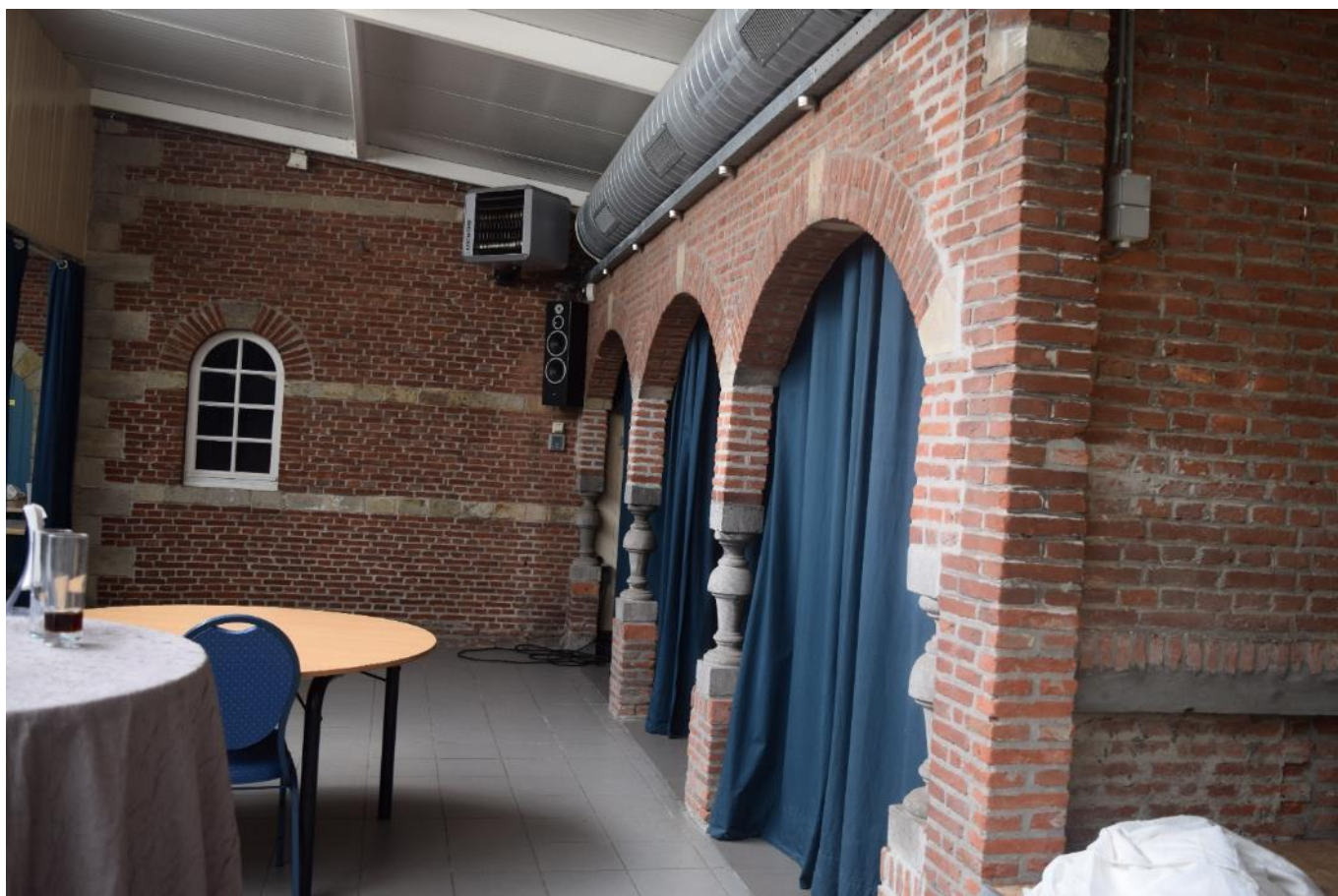
Foto 76: kasteel de Bunswyck: zicht op buitengevels in neotraditionele stijl van de kleine dienstgebouwen uit 1938, zicht op het arcadengebouwtje dat de vierkante duiventoren verbindt met een kleine voliëre
