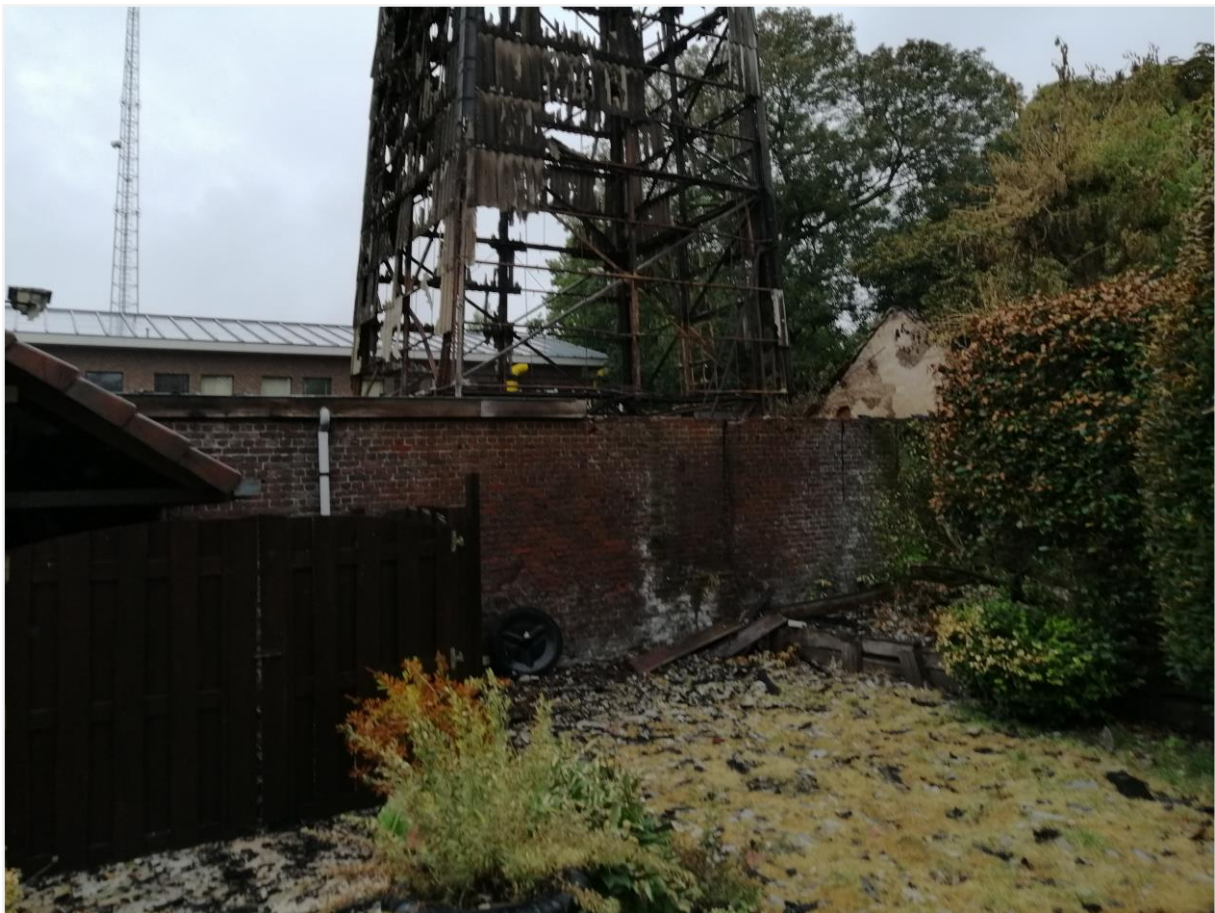
Foto 2: Detail van de onderzijde van de staalstructuur
