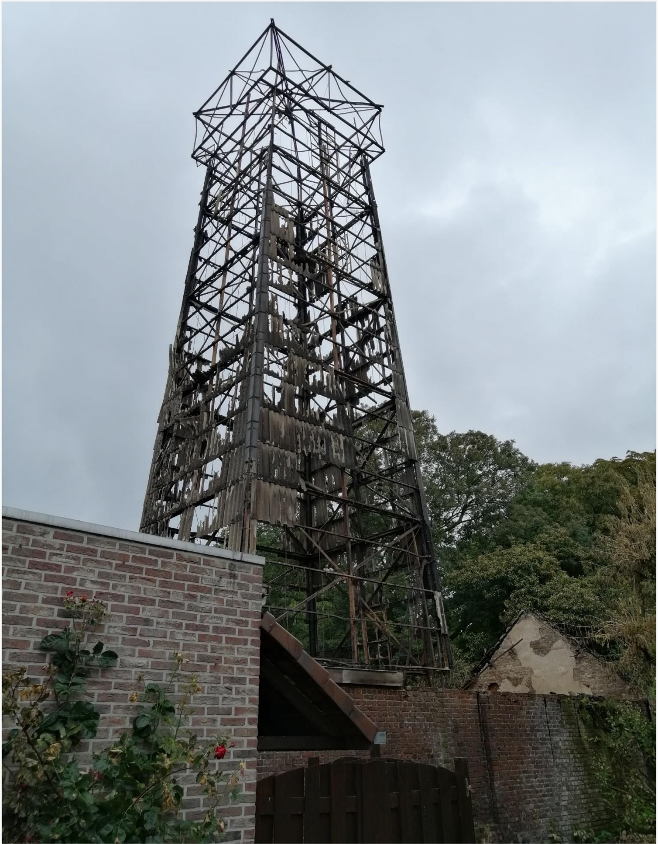
Foto 1: De staalstructuur van de toren
