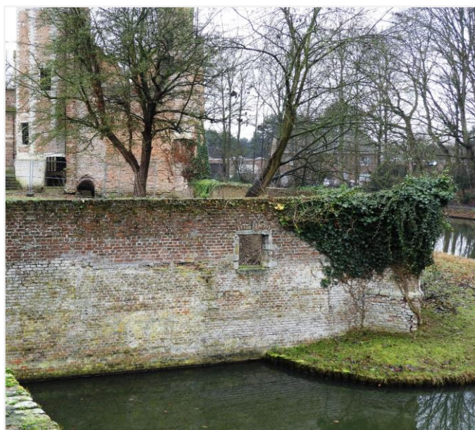
Foto 12: de keermuur aan de rechterzijde van de toegangsbrug, met bewaarde kelderopening en hoeksteunbeer.
