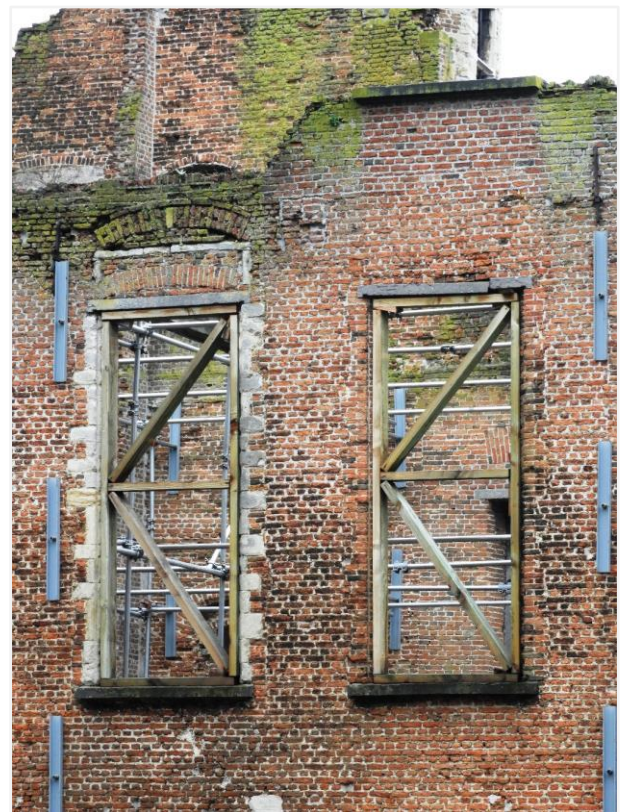
Foto 3: vensteropeningen in de zuidgevel.
