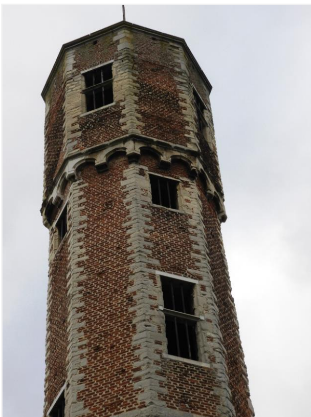
Foto 26: de bovenste geleding van de traptoren.
