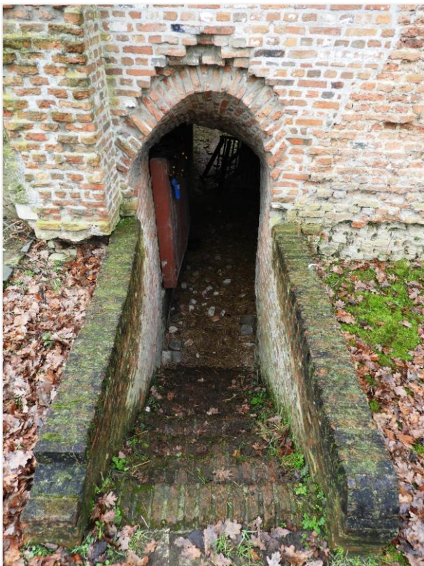
Foto 22: toegang tot de kelder van de westvleugel.
