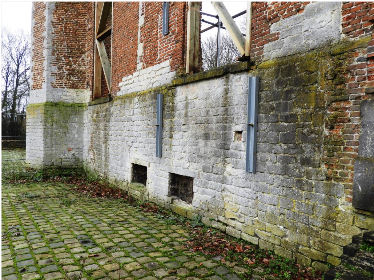
Foto 15: natuurstenen plint van de voorgevel.
