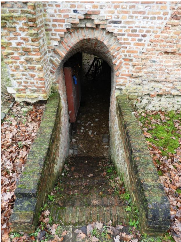
Foto 22: toegang tot de kelder van de westvleugel.
