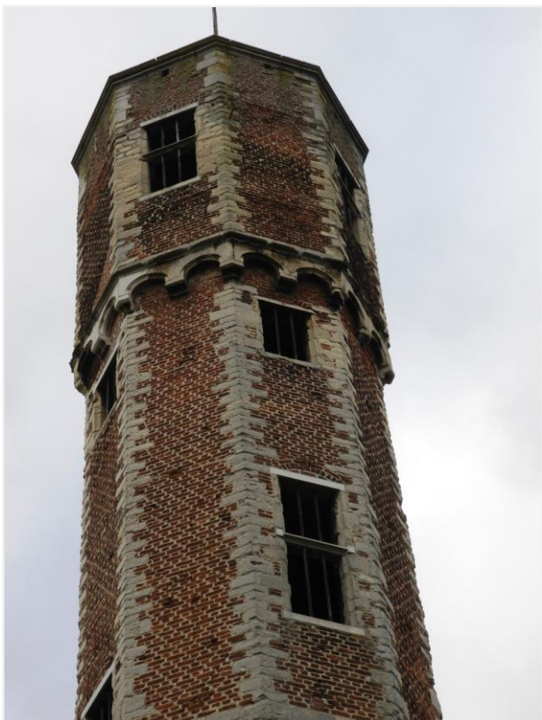
Foto 26: de bovenste geleding van de traptoren.
