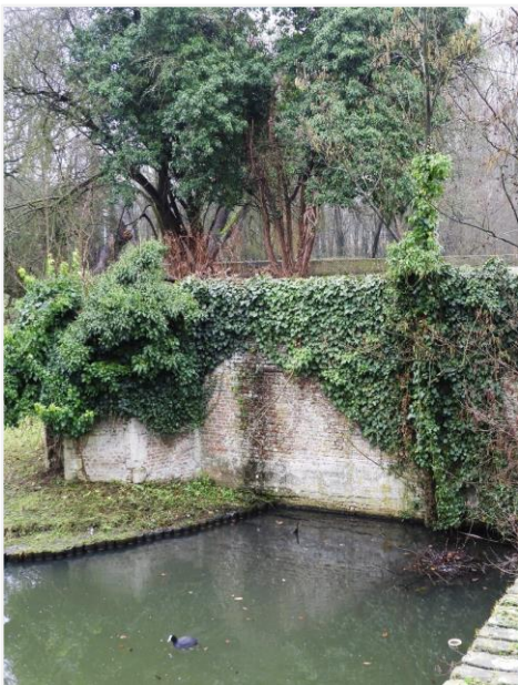
Foto 11: de keermuur aan de linkerzijde van de toegangsbrug. De veelhoekige uitbouw is het overblijfsel van een hoektoren.
