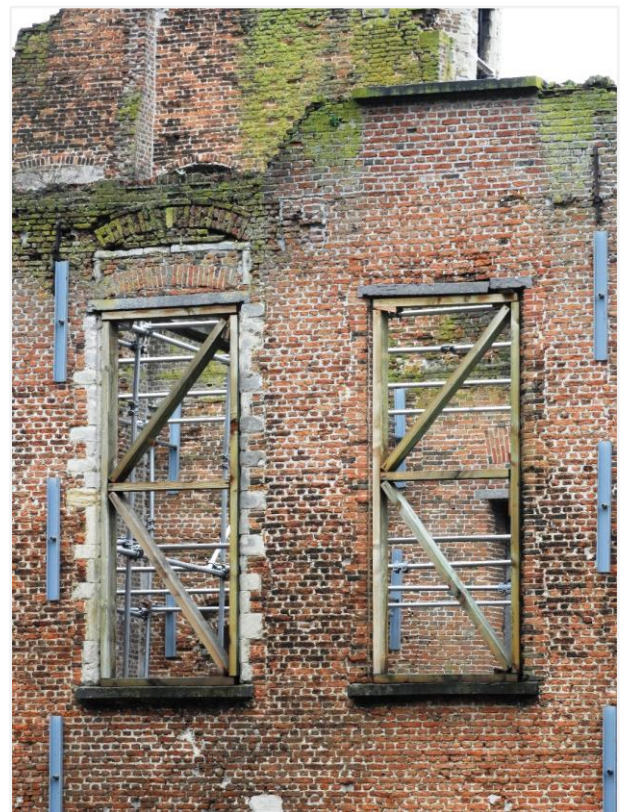
Foto 3: vensteropeningen in de zuidgevel.
