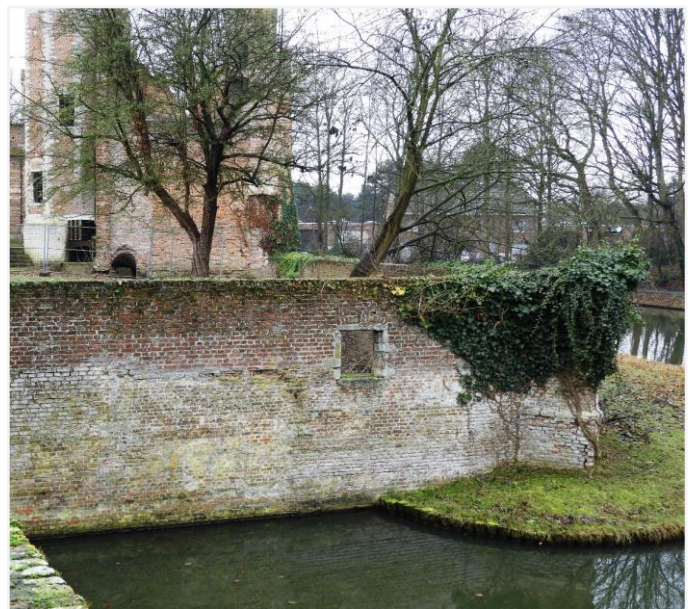
Foto 12: de keermuur aan de rechterzijde van de toegangsbrug, met bewaarde kelderopening en hoeksteunbeer.
