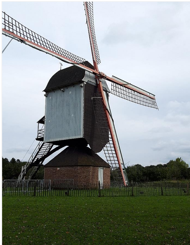
Foto 12: Molenkast met blinde zijwegen. Blinde windweeg onderaan klokvormig uitgewerkt.
