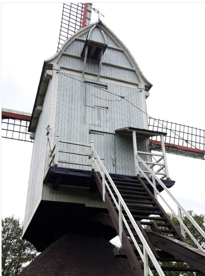
Foto 8: Molenkast. Voorweeg met trap, balkon onder afdak en met balustrade.
