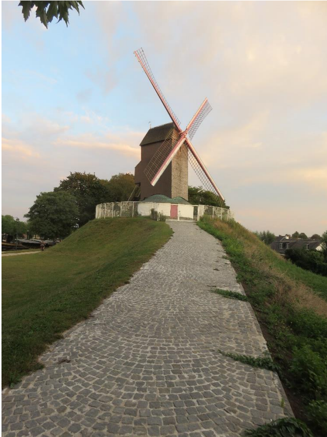
Foto 2: De Bosterhoutmolen of nieuwe Coeleweymolen op de nieuw aangelegde molenberg met gekasseide oprit naar de molen
