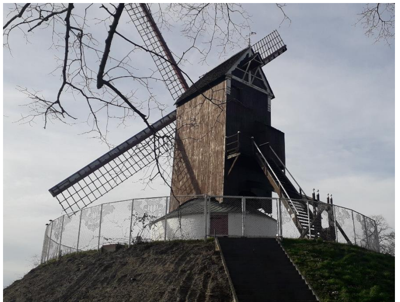
Foto 14: Molenkast met houten beplanking en ronde kijkgaten, afgesloten met houten luikjes
