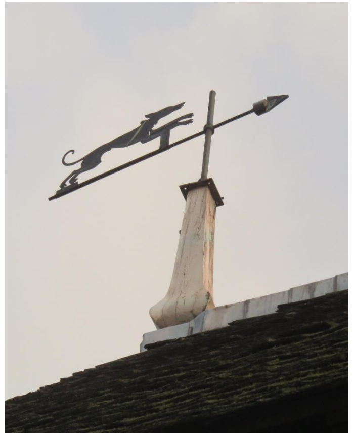
Foto 6: Nok bekrond met houten makelaar en ijzeren windwijzer in de vorm van een hond
