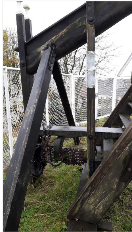
Foto 9: De houten trap en het kruiwerk. Loopstaken en de papen (met gesculpteerde geschilderde kop) Kruibok (of kruisas) met ijzeren ketting
