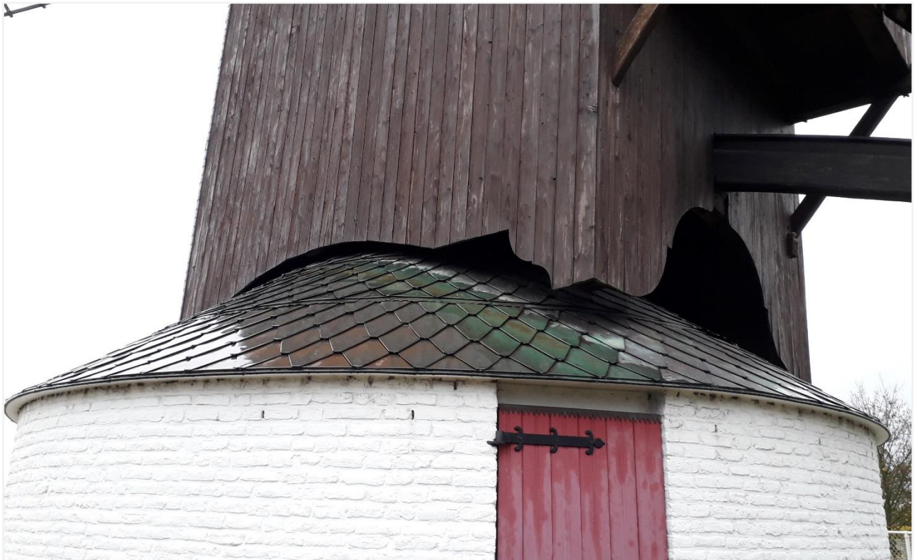
Foto 7: De Bosterhoutmolen of de nieuwe Coeleweymolen op de gesloten molenvoet. Witgeschilderde baksteen boven donkerder plint. Houten deurtjes met ijzeren beslag
