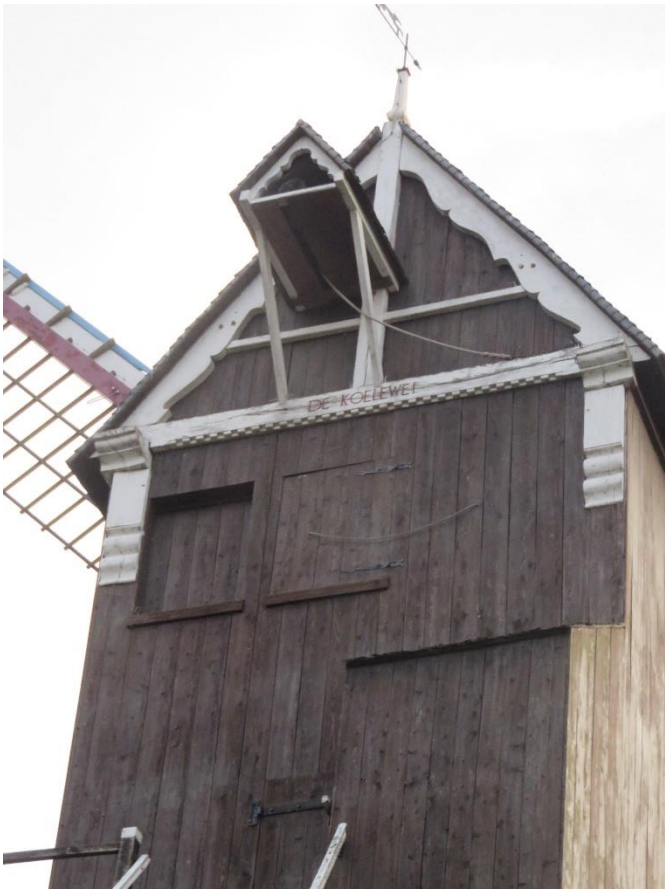
Foto 5: Staartzijde met luikjes en luikap ter bescherming van het buitenluiwerk.
