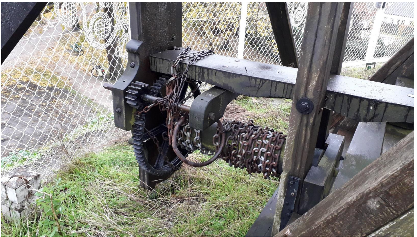
Foto 12: Kruias met ijzeren ketting, links kruipaal.
