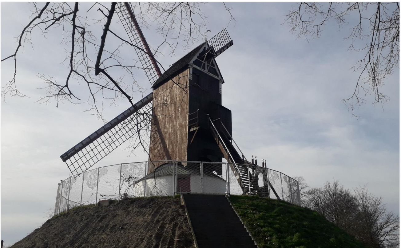
Foto 4: De Bosterhoutmolen of nieuwe Coeleweymolen op de molenberg – trapzijde met links van de trap balkon met houten leuning en rechts kleine kombuis.
