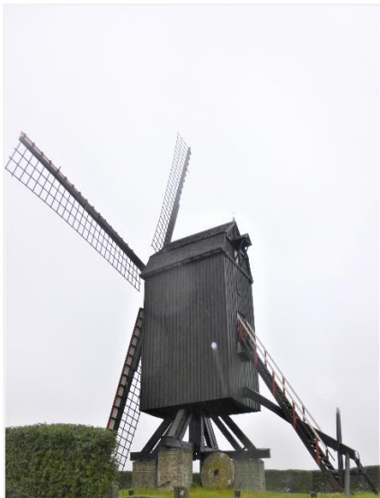
Foto 3: linker- en voorweeg met staart, teerlingen en kruisplaat
