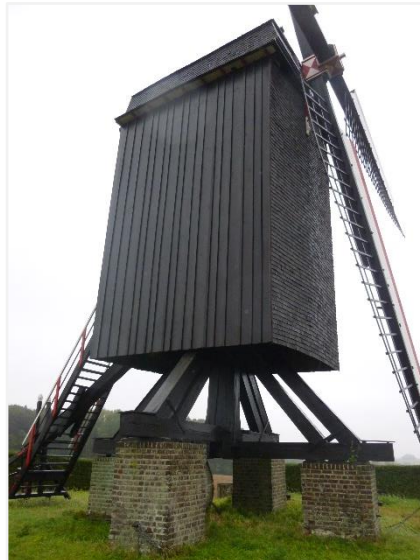
Foto 4: vangzijde en windweeg met gevluht
