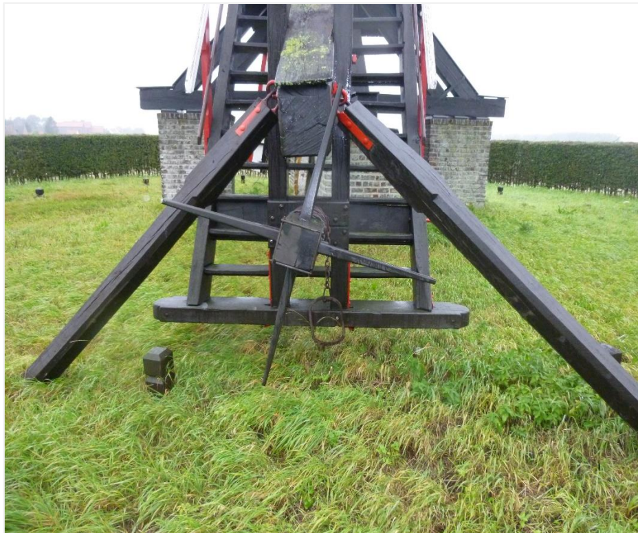
Foto 9: zicht op trap, staart en kruierwerk
